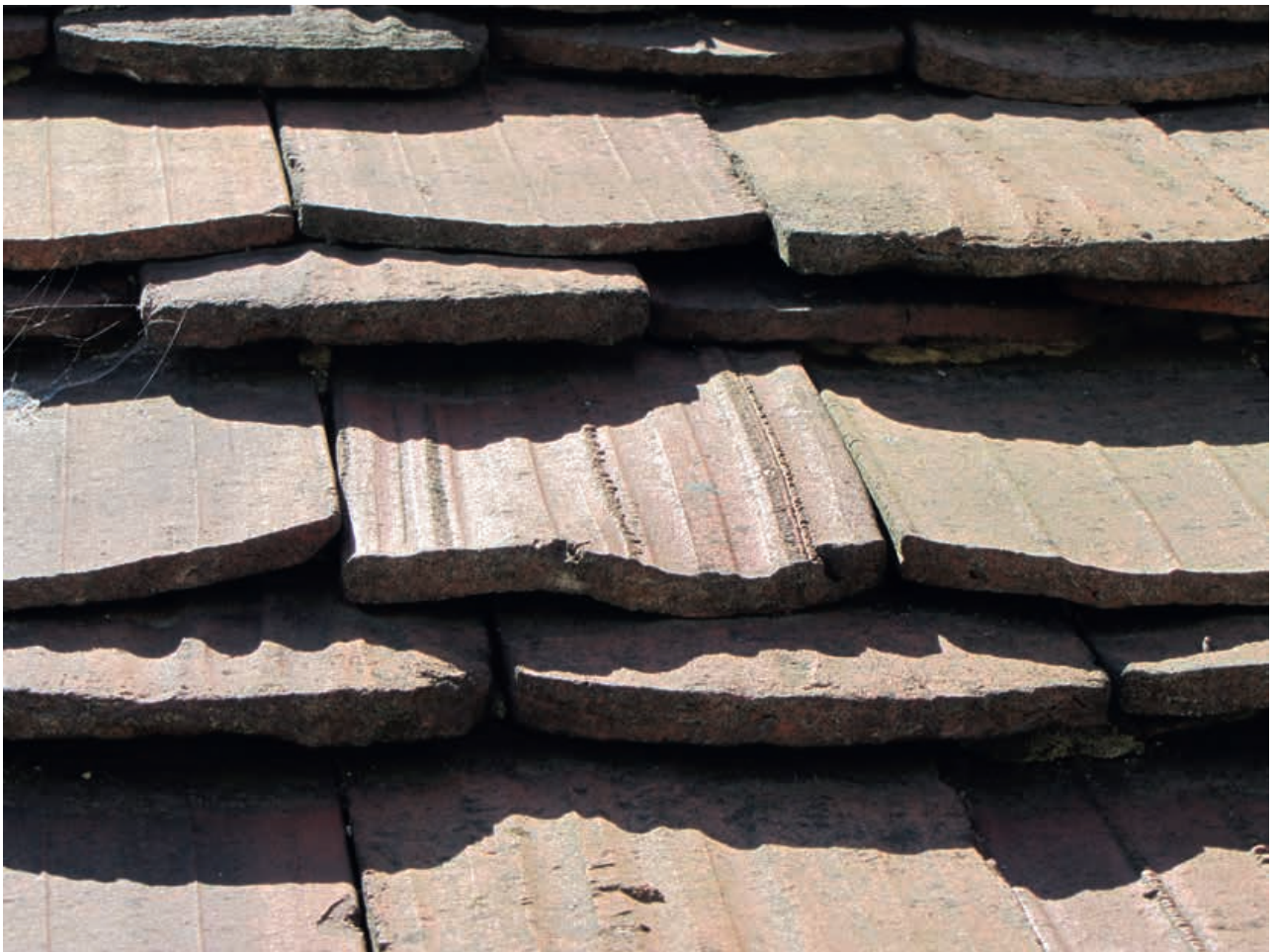
15. Miłaków, kościół parafialny pw. św. Bartłomieja Apostoła, dachówki wykonane mechaniczne, zachowane na połaci dachu zakrystii (fot. A. Duda)
