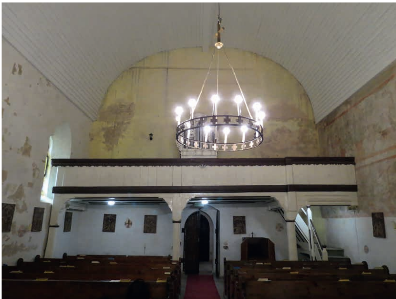
13. Przczyzna Górna. Kościół pw. św. Jerzego. Widok zachodniej partii wnętrza nawy. Stan w 2017 r.
