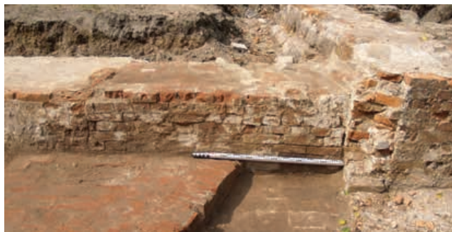
18. Laski Odrzańskie, stan. 1, gm. Czerwieńsk, woj. lubuskie. Przemurowania (styki murów – oznaczone strzałkami) widoczne na ścianie zamykającej pomieszczenie P6. Czy tu znajdowało się pierwotne wejście do piwnicy? Widoczny stopień pomieszczenia P6b (fot. H. Augustyniak)
