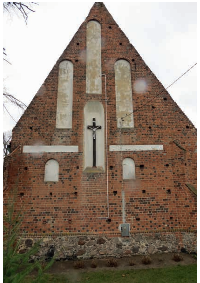
11. Przychyna Górna. Kościół pw. św. Jerzego. Ściana szczytowa prezbiterium.
