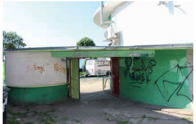
Fot. 6. Budynek dworca PKS przy ul. PCK 10 w Sulechowie, fragment elewacji północnej
