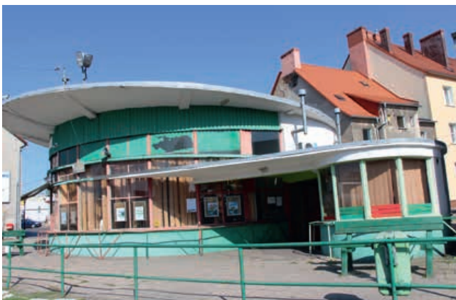
Fot. 3. Budynek dworca PKS przy ul. PCK 10 w Sulechowie, po prawej stronie dawne pomieszczenie dyspozytora ruchu
