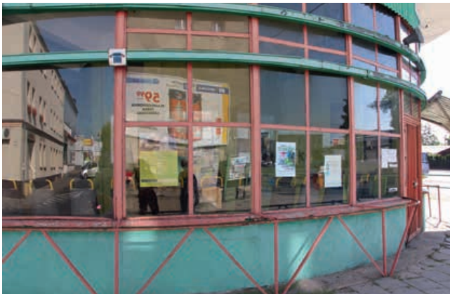
Fot. 2. Budynek dworca PKS przy ul. PCK 10 w Sulechowie, fragment elewacji zachodniej
