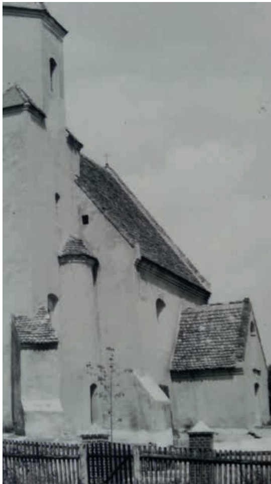
4. Miłaków, widok na kościół od strony południowo-zachodniej. Fotografia z 1964 r. z tzw. karty zielonej w zbiorach Archiwum Wojewódzkiego Urzędu Ochrony Zabytków w Zielonej Górze
