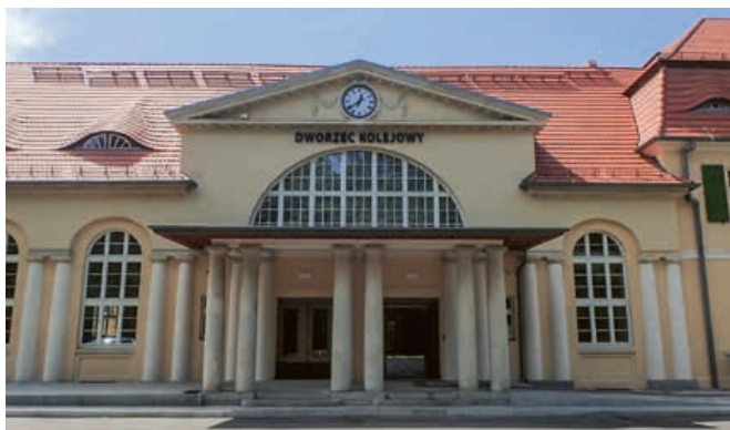
9. Budynek dworca kolejowego w Żaganiu wraz budynkiem dawnej poczty, stan po przeprowadzonych pracach w 2019 r. (fot. B. Idryjan)
