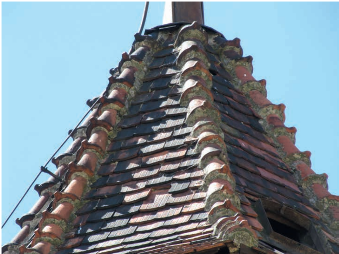
22. Miłaków, kościół parafialny pw. św. Bartłomieja Apostoła. Pokrycie dachu wieży (fot. A. Duda)
