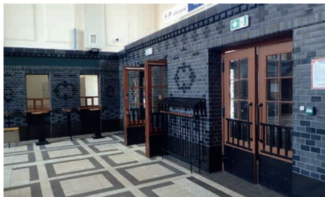
19. Hol dworcowy po pracach konserwatorskich prowadzonych przy okładzinie ceramicznej oraz stolarnie drzwiowej i kasach biletowych (fot. B. Idryjan)
