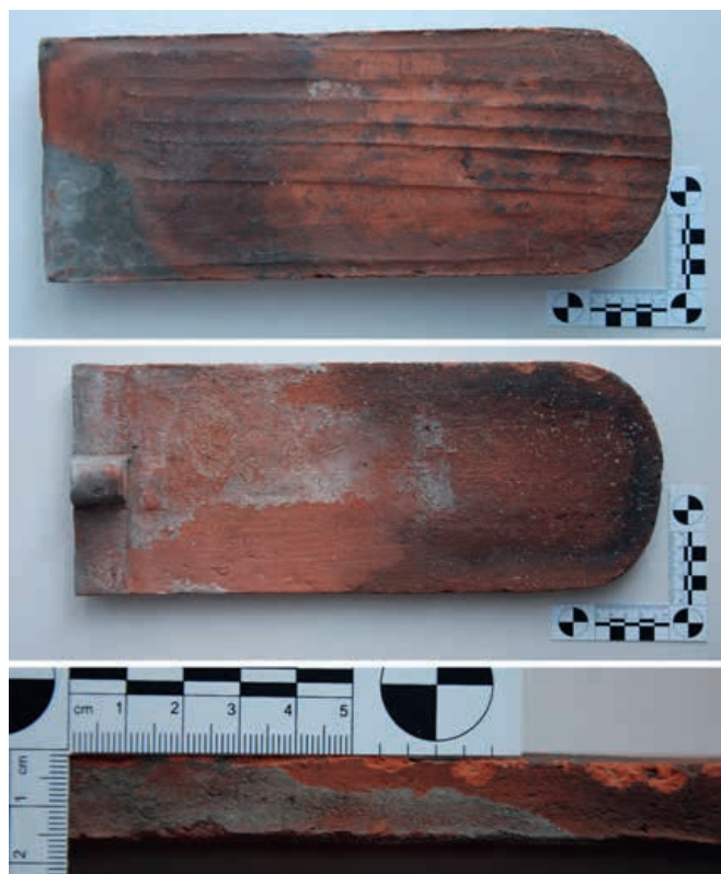
13. Miłaków, kościół parafialny pw. św. Bartłomieja Apostoła, typ dachówki zachowany na połaci północnej prezbiterium (fot. A. Duda)
