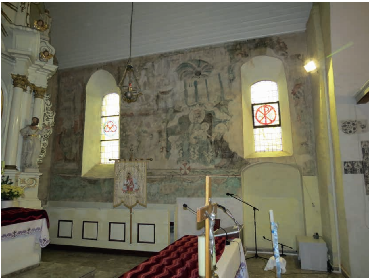
15. Przyczyna Górna. Kościół pw. św. Jerzego. Widok południowej ściany prezbiterium. Stan w 2017 r.
