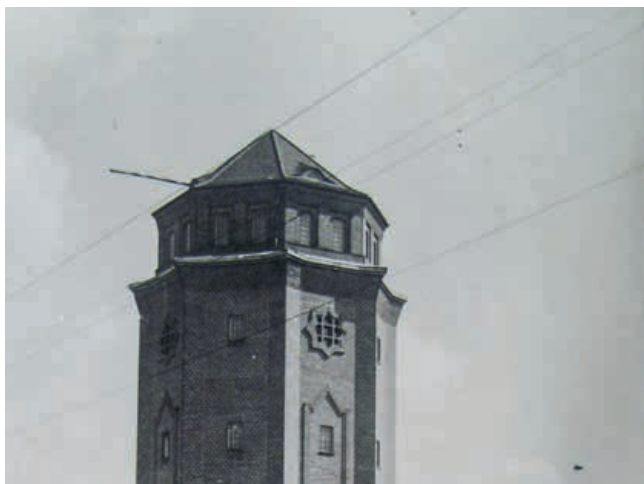
10. Górna partia wieży ciśnień przy dworcu w Zbąszynku z rozetowym obramieniem okien (źródło: Heimatkreis Meseritz Wewelsburg)
