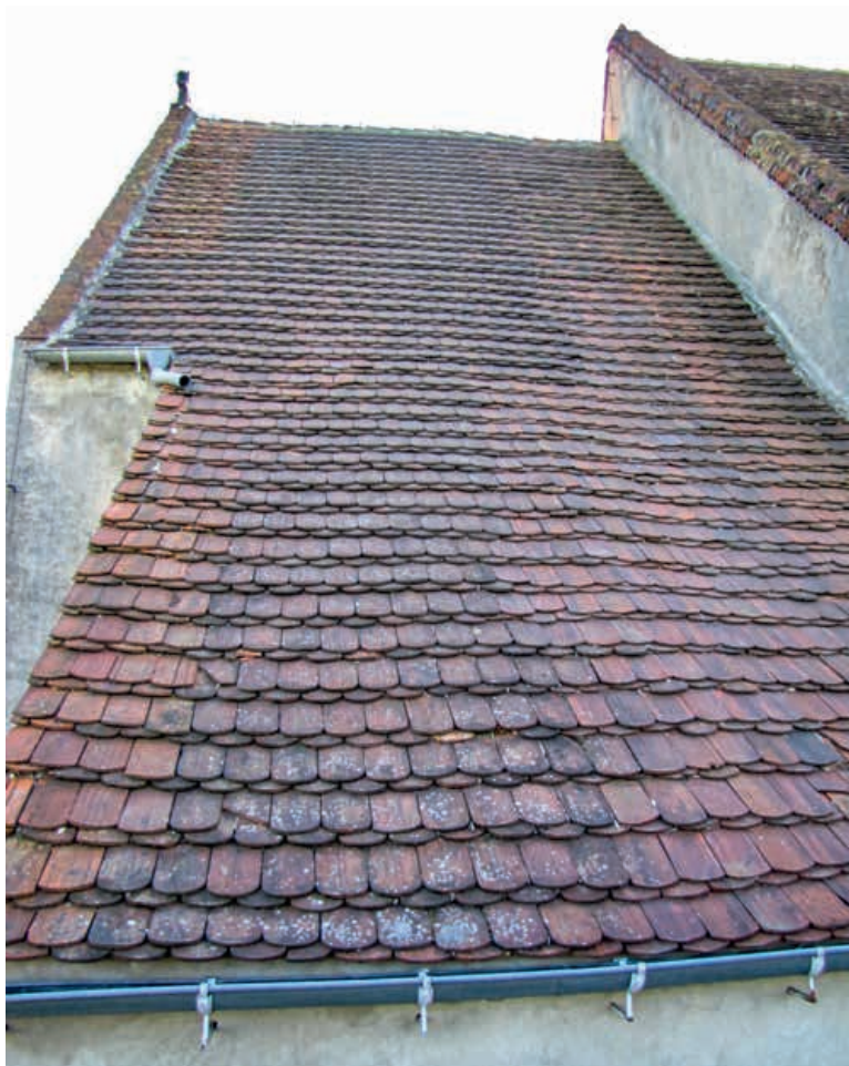
20. Miłaków, kościół parafialny pw. św. Bartłomieja Apostoła, północna połać dachowa prezbiterium i zakrystii ze zróżnicowaną dachówką (fot. A. Duda)
