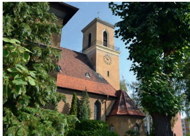
Widok na kościół ewangelicki od strony placu przy plebanii (ob. katolicki, pw. Macierzyństwa NMP) (fot. G. Urbanek)
