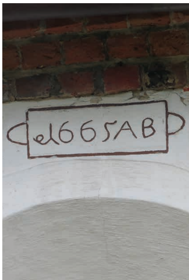
9. Przczyzna Górna. Kościół pw. św. Jerzego. Inskrypcja z 1665 r. wyryta w tynku przy jednym z okien prezbiterium. Stan w 2017 r.
