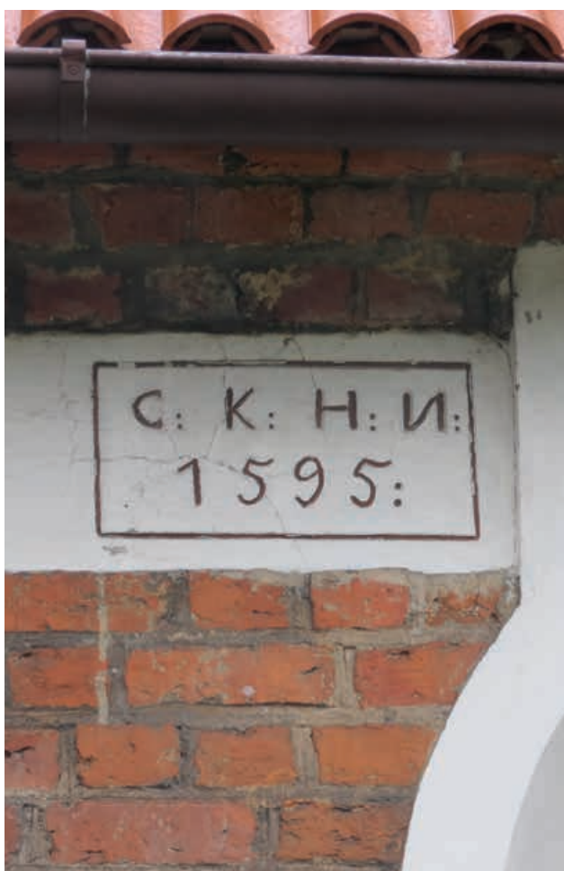
8. Przczyzna Górna. Kościół pw. św. Jerzego. Inskrypcja z 1595 r. wyryta w tynku przy jednym z okien prezbiterium. Stan w 2017 r.
