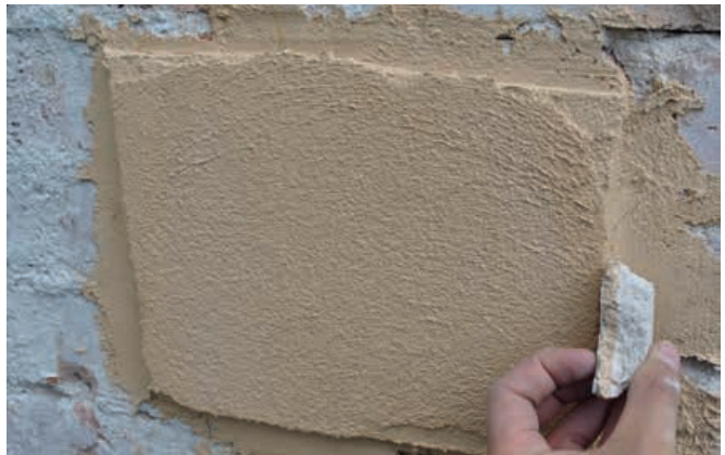
16. Kolorystyczne i fakturalne próby tynkarskie przeprowadzone na elewacjach dworca (fot. B. Idryjan)
