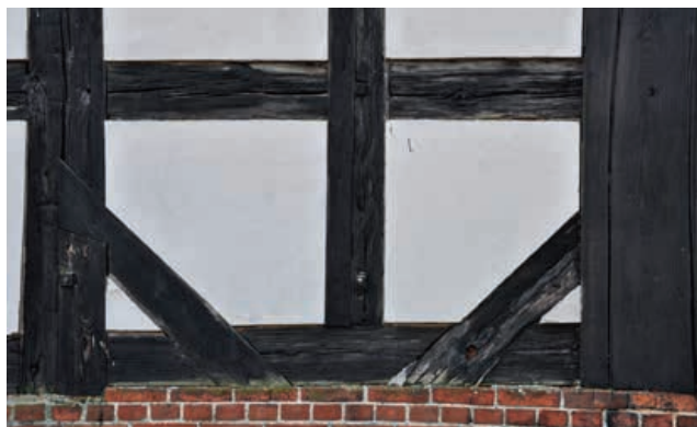
13. Kościół w Kalsku. Fragment konstrukcji szkieletowej. Bale nałożone na zniszczone elementy (fot. U. Schaaf)
