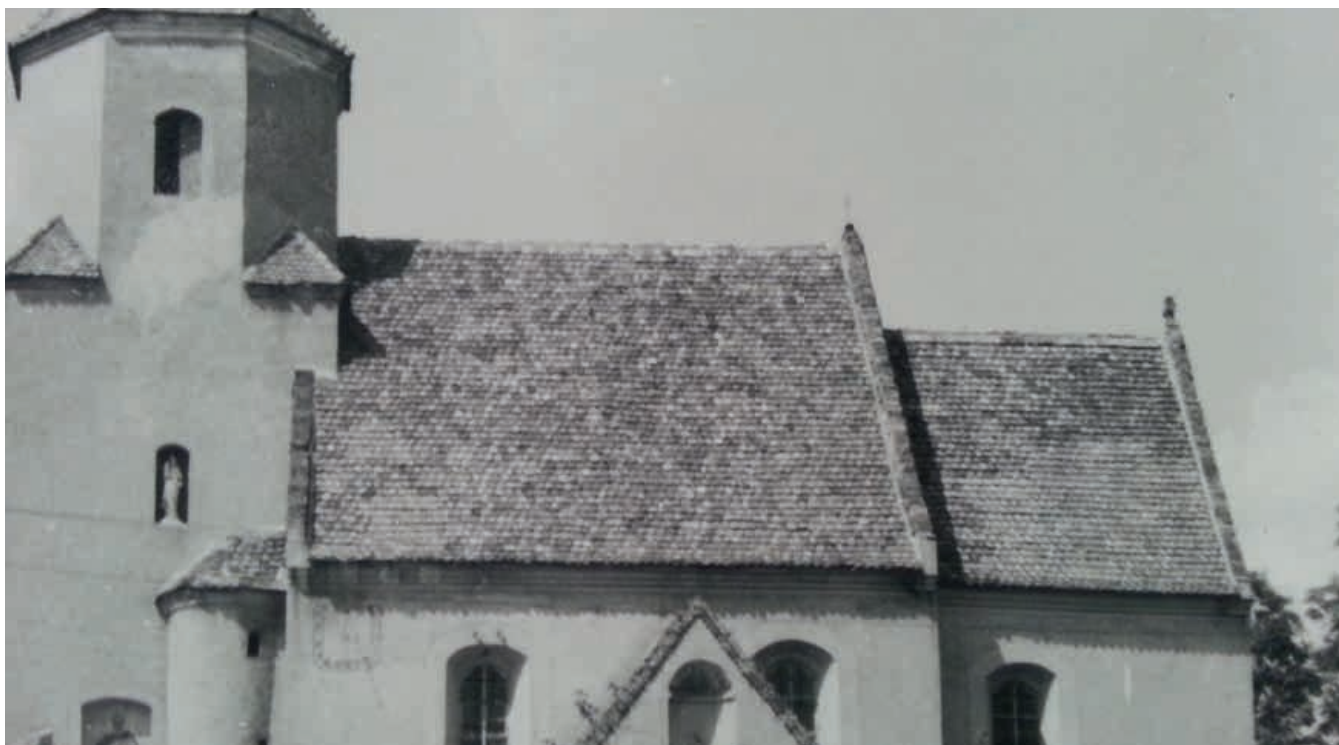
5. Miłaków, widok na kościół od strony południowej. Fotografia z 1964 r. z tzw. karty zielonej w zbiorach Archiwum Wojewódzkiego Urzędu Ochrony Zabytków w Zielonej Górze
