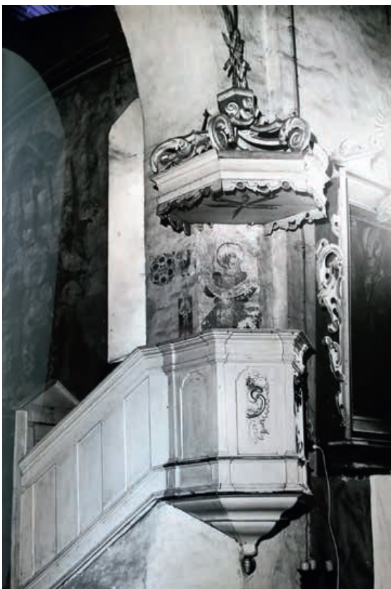
41. Barokowa ambona zniszczona po 1981 r. Stan z 1981 r. Za: Krzyślak B., Przyczyna Górna k. Wschowy. Kościół pw. św. Jerzego. T. I i II – Studium historyczno-architektoniczne wykonane na zlecenie Urzędu Wojewódzkiego – Wydział Kultury – Wojewódzkiego Konserwatora Zabytków w Lesznie
