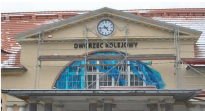
17. Detal architektoniczny w trakcie prac konserwatorskich w 2019 r. (fot. B. Idryjan)
