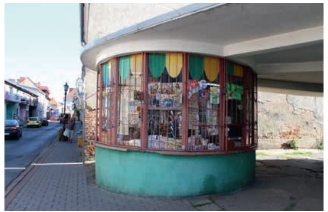
Fot. 5. Budynek dworca PKS przy ul. PCK 10 w Sulechowie, pomieszczenie kiosku RUCH-u
