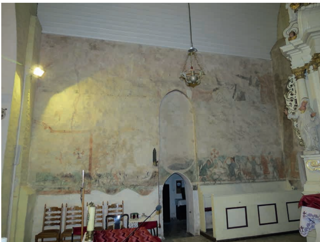
14. Przczyzna Górna. Kościół pw. św. Jerzego. Widok północnej ściany prezbiterium. Stan w 2017 r.
