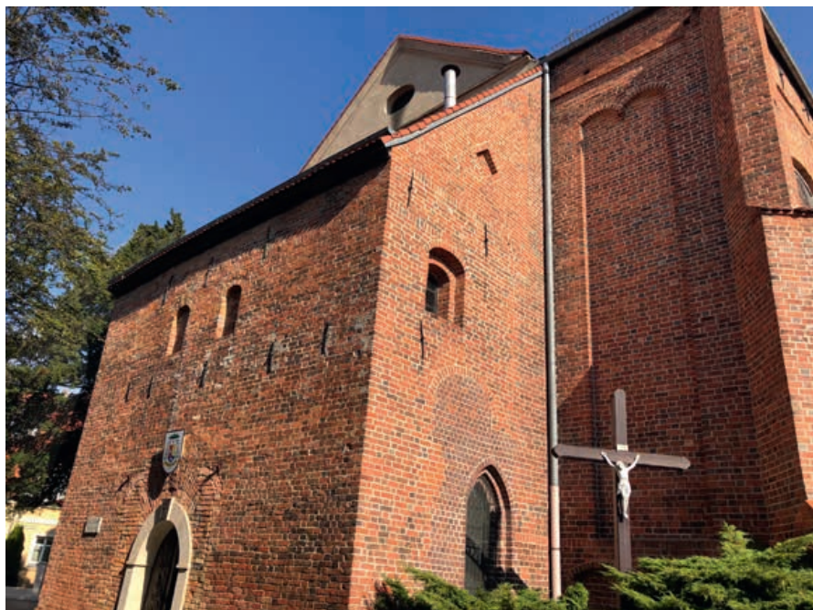
Ryc 12. Zielona Góra, konkatedra pw. św. Jadwigi Śląskiej, elewacja zachodnia (fot. A. Legendziewicz)
