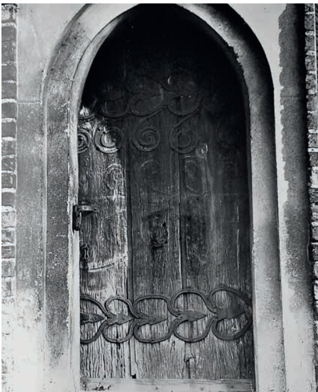
34. Przyczyna Górna. Kościół. Wejście zachodnie. Gotyckie drzwi obecnie przeniesione do muzeum ze Wschowie. Stan z 1981 r. Za: B. Krzyślak, Przyczyna Górna k. Wschowy. Kościół pw. św. Jerzego. T. I i II – Studium historyczno-architektoniczne wykonane na zlecenie Urzędu Wojewódzkiego – Wydział Kultury – Wojewódzkiego Konserwatora Zabytków w Lesznie
