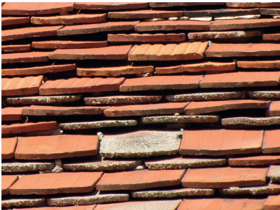
21. Miłaków, kościół parafialny pw. św. Bartłomieja Apostoła, południowa połać dachowa korpusu kościoła ze zróżnicowaną dachówką ceramiczną i cementową (fot. A. Duda)
