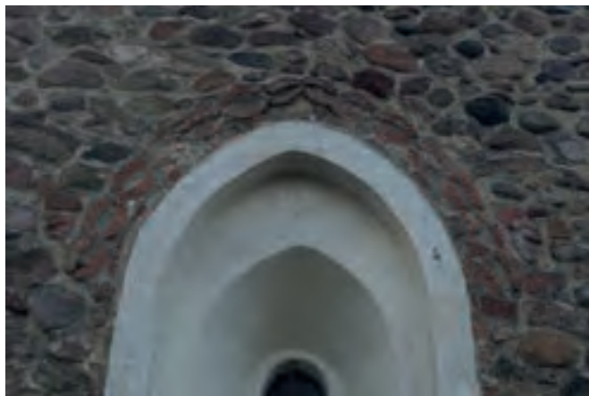
Ryc. 3. Żary, kościół pw. Świętych Apostołów Piotra i Pawła, elewacja wschodnia, detal okna, fot. A. Legendziewicz
