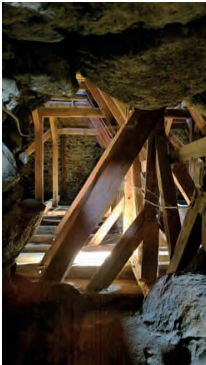
Ryc. 7. Borów Wielki. Kościół pw. Świętego Wawrzyńca. Więźba dachowa w partii poddasza korpusu nawy, fot. K. Błaszczyk
