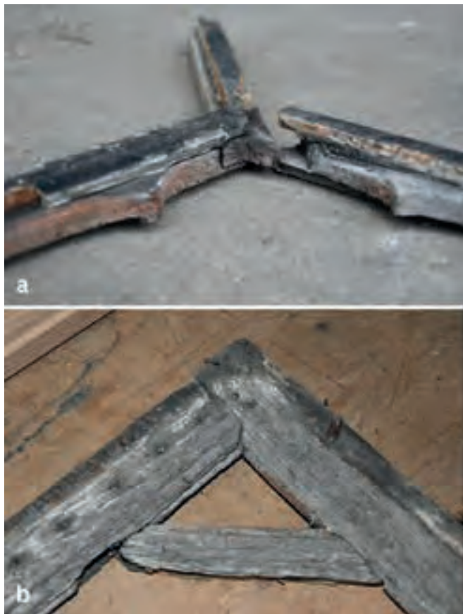
Ryc. 5. Okno kościoła w Krośnie Odrzańskim. Szprosy montowano za pomocą łączeń widlicowych, narożniki ram na połączenia czopowe blokowane dwoma kołkami, fot. P. Celecka
