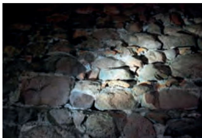
Ryc. 5. Szprotawa, kościół parafialny pw. Wniebowzięcia NMP, fragmenty pokryć ceramicznych z pierwszej połowy XIV w., wmurowane w południową ścianę wieży kościoła, fot. A. Duda
