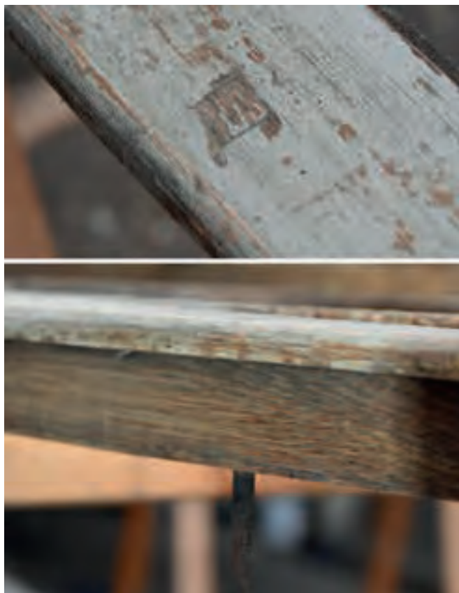
Ryc. 6. Okno kościoła w Krośnie Odrzańskim, fragment krosna ze szprosami. Łeb gwoźdźcia, oprócz kołków, mocującego krosno w głównej ramie okiennej maskowano od strony wnętrza kwadratowym elementem, fot. P. Celecka
