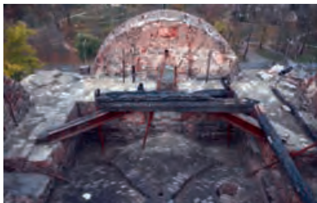
Ryc. 12. Żary, oczyszczone sklepienie krzyżowe w szczycie wieży, fot. A. Gutka, 2020
