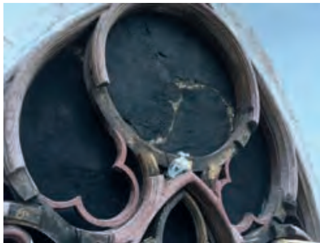
Ryc. 7. Okno w wieży nad wejściem południowym kościoła w Sulechowie w trakcie prac konserwatorskich. Widoczny warstwowy układ elementów łączonych z przesunięciem za pomocą drewnianych kołków, fot. P. Celecka
