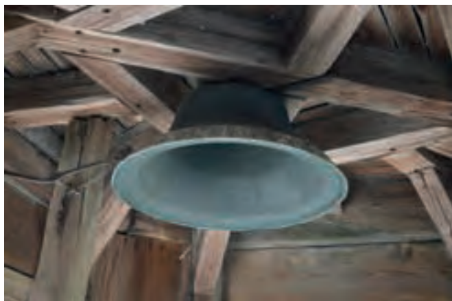
Ryc. 1. Dzwon zegarowy oraz bijak pobudzający zegara na wieży północnej, fot. M. Tureczek
