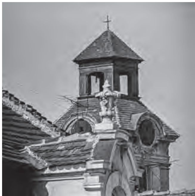
Ryc. 11. Żary, wieża zamkowa przed usunięciem dachówki, fot. Witold Mazurkiewicz, 1974
