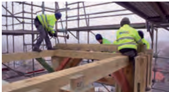
Ryc. 18. Żary, montaż ramy stolcowej pod latarnię hełmu, fot. A. Gutka, 2020
