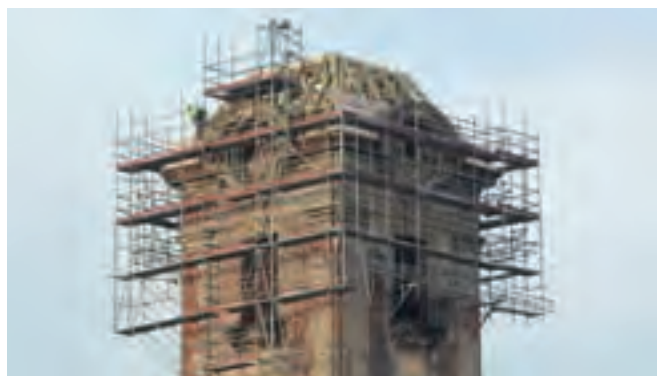
Ryc. 19. Żary, rusztowania w I etapie prac przy odbudowie hełmu wieży zamkowej, fot. A. Gutka, 2020
