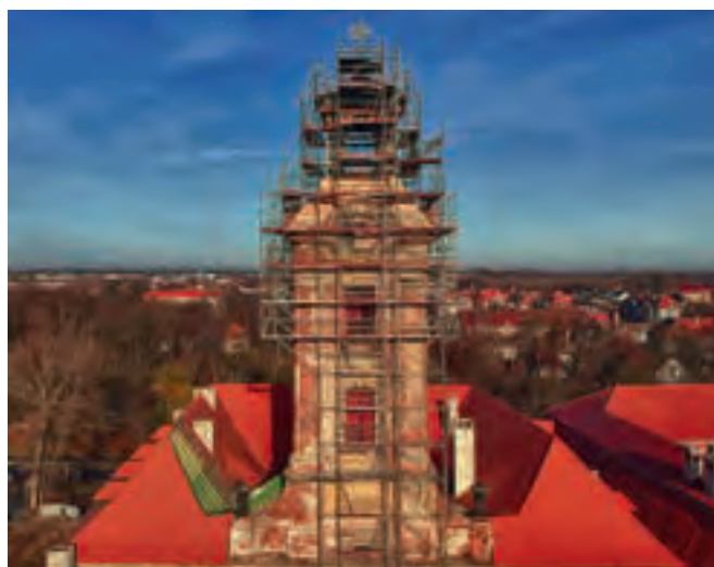
Ryc. 21. Żary, zakres prac w połowie grudnia 2020 r., fot. T. Czech
