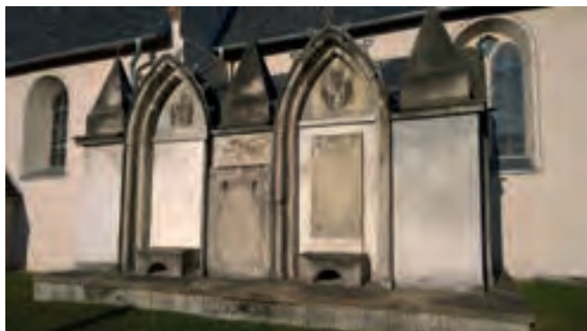
Ryc. 3. Borów Wielki. Kościół pw. Świętego Wawrzyńca. Mauzoleum rodu von Unruh z 1821 r. Widok od południa, fot. K. Błaszczuk
