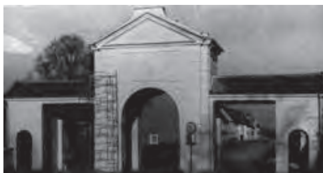
Ryc. 25. Fotografia wykonana w 1991 roku. Widok na bramę miejską od strony południowej. Źródło: Brody. Wytyczne konserwatorskie do studium historyczno-urbanistycznego. Część II Ilustracje fotograficzne, fot. B. Bugiel, Zielona Góra 1991
