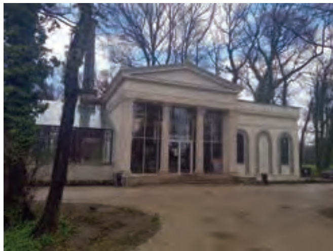
Ryc. 10. Oranżeria po rozbudowie i odtworzeniu dachu, fot. B. Bielinis-Kopeć
