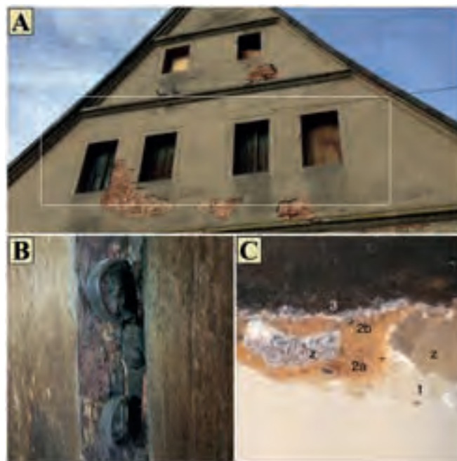
Ryc. 10. Sulechów, dawna szkoła miejska. Okna klasycystyczne (III faza chronologiczna); A. Relikty czterech okien na południowym szczycie budynku; B. Zachowana żelazna zakrętka dwuskrzydłkowa; C. Przekrój stratygraficzny w świetle widzialnym odbitym. Powiększenie obiektywu mikroskopowego \times 5 . Dotyczy wewnętrznej strony okien. Drewno pokryte szarą zaprawką. Wtórnie pomalowane żółtą farbą olejną, fot. M. Błażejowski
