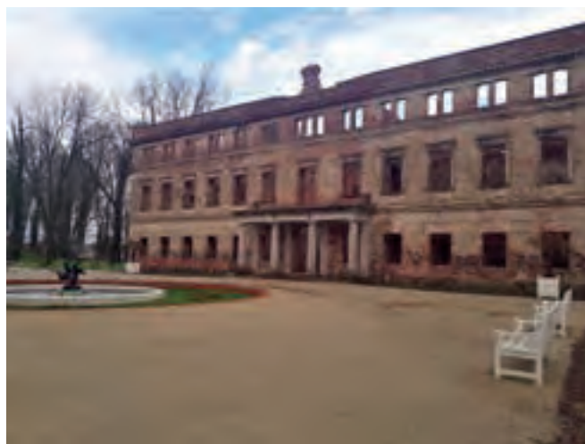
Ryc. 7. Widok na elewację frontową pałacu. Stan z 2020 r., fot. B. Bielinis-Kopeć
