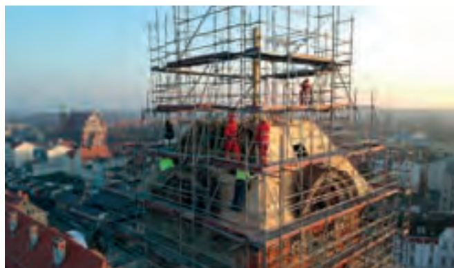
Ryc. 20. Żary, zamontowany pierwszy słup w konstrukcji nowej latarni hełmu, fot. M. Hładowski, 2020
