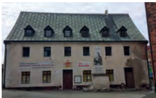
Ryc. 1. Sulechów, dawna szkoła miejska. Fasada (elewacja wschodnia), fot. J. Ciechanowska
