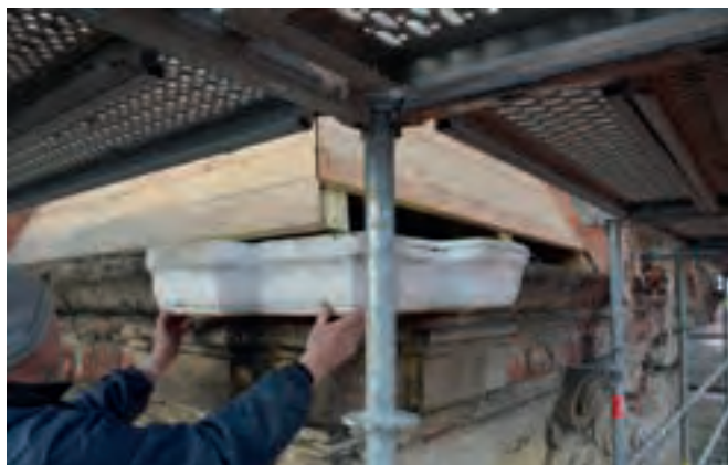
Ryc. 16. Żary, rzeźbiarz Janusz Orzepowski przymierza wykonany model nowego kamiennego naroża gzymsu koronującego, fot. A. Gutka, 2020
