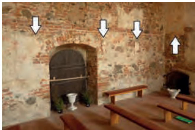
Ryc. 4. Lokalizacja pierwotnego wejścia na łóżę. Zaznaczono ślady belek i zamurowane wejście, fot. D. Kwaśniak
