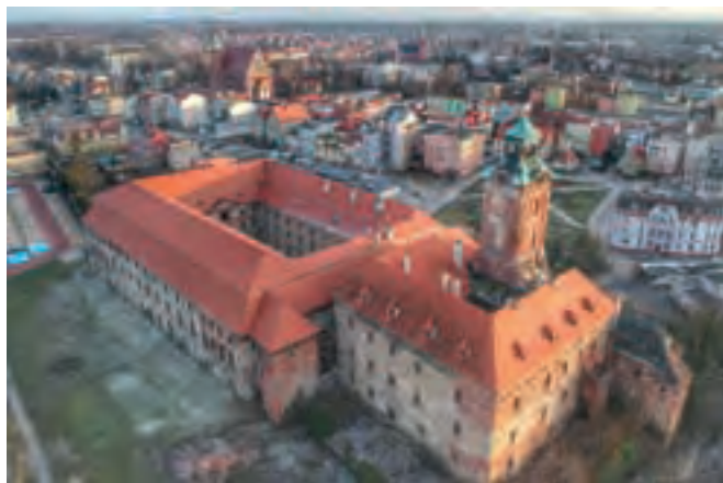
Ryc. 1. Żary, zespół zamkowo-pałacowy przed pożarem, widok od strony północno-zachodniej, fot. M. Hładowski, 2019
