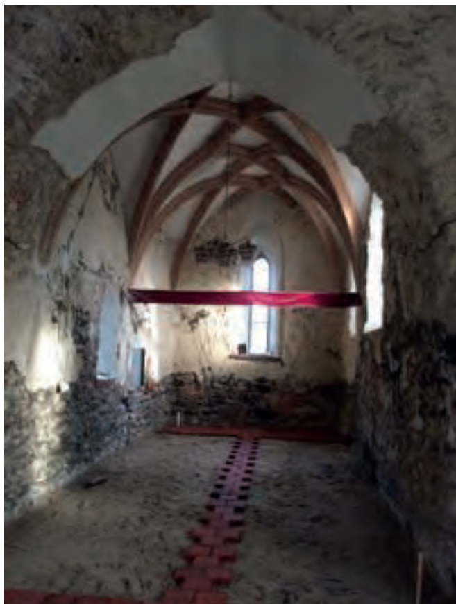
Ryc. 6a. Żary, kościół pw. Świętych Apostołów Piotra i Pawła, wnętrze prezbiterium ku wschodowi, widok w trakcie prac, fot. A. Legendziewicz
