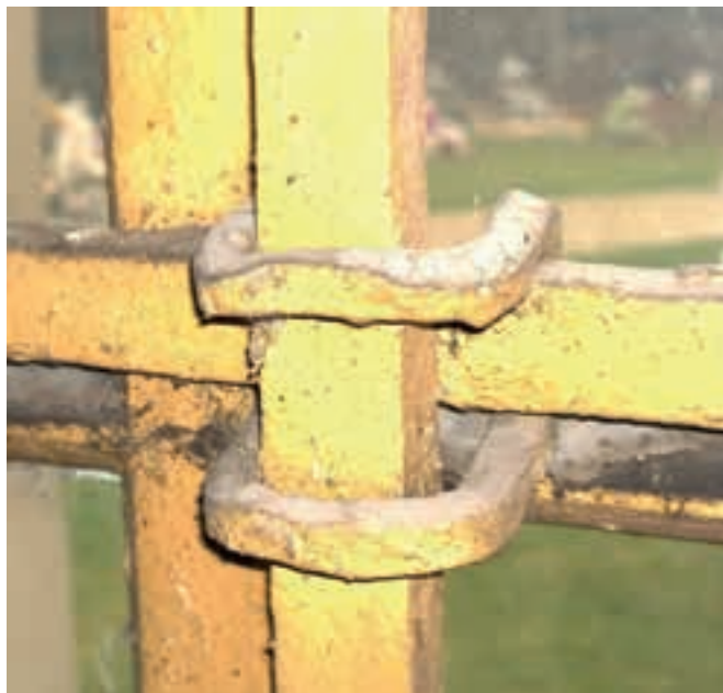
Ryc. 22. Borów Wielki. Kościół pw. Świętego Wawrzyńca. Detal łączenia kraty w oknie prezbiterium, XVII w., fot. K. Błaszczuk
