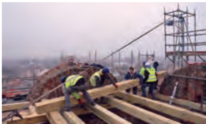
Ryc. 17. Żary, transport najcięższych elementów konstrukcji hełmu, fot. A. Gutka, 2020
