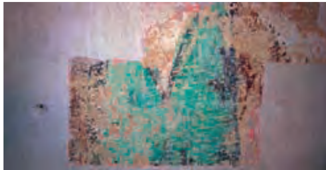
Ryc. 41. Borów Wielki. Kościół pw. Świętego Wawrzyńca. Odkrywka wykonana po południowej stronie arkady łuku tęczowego z fragmentem gotyckiej lub renesansowej polichromii, fot. K. Błaszczyk
