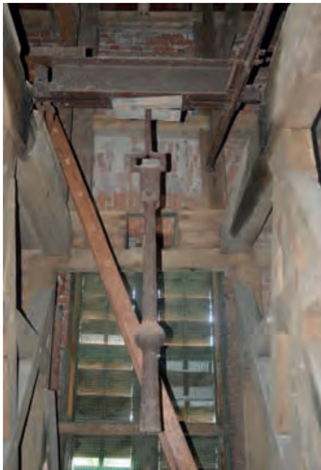
Ryc. 7. Pozostałości po dzwonie „Jezus” we wnętrzu wieży, fot. M. Tureczek
