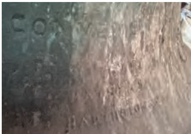
Ryc. 4. Stan zanieczyszczenia płaszcza, fot. M. Tureczek
