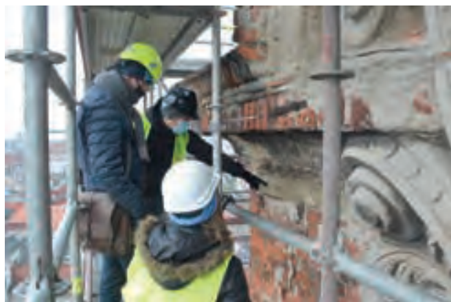
Ryc. 26. Żary, Lubuski Wojewódzki Konserwator Zabytków dr Barbara Bieliniś-Kopeć, prof. dr. hab. inż. arch. Andrzej Legendziewicz i mgr Karol Błaszczak w trakcie prowadzonych badań przy elewacjach zamkowej wieży, fot. A. Gutka, 2020
