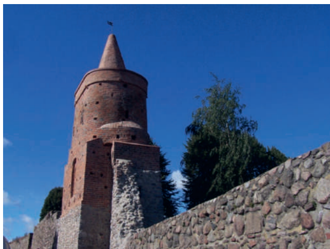
Ryc. 17. Baszta Więzienna, stan po remoncie, fot. M. Bidol
