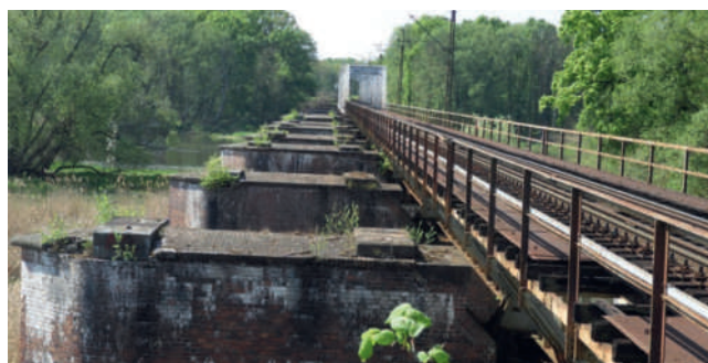
Ryc. 4. Most pod Pomorskiem, z lewej na filarach widoczne miejsce po zdemonstrowanym ciągu przęsła, z prawej przęsła blachownicowe, a w głębi kratownicowe, fot. Archiwum Wojewódzkiego Urzędu Ochrony Zabytków w Zielonej Górze 2020 r.
