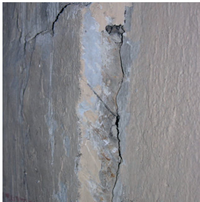
Ryc. 6. Lubiechnia Mała, kościół pw. Podwyższenia Krzyża, korpus, wewnątrz, ściana północna, wiązanie nr 2, słup z obcięcią nakładką po mieczu górnym poniżej drugiego od dołu rzędu rygli
