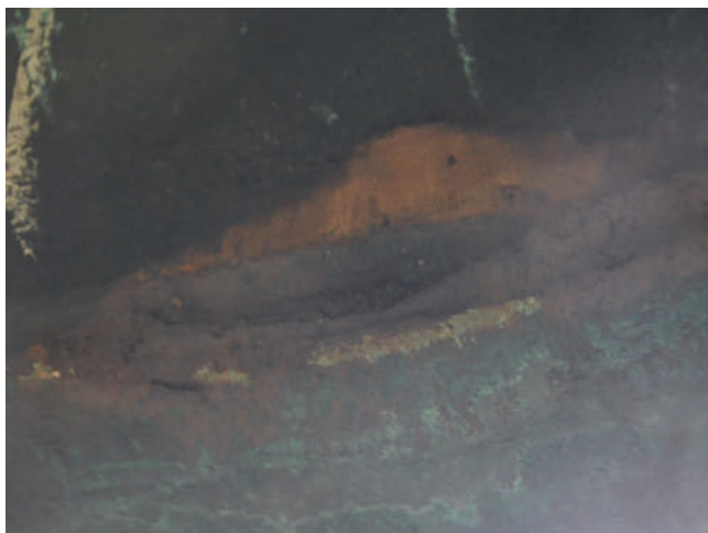
Ryc. 9. Uszkodzenie mechaniczne kryzy powstałe wskutek pracy ostrego bijaka, fot. M. Tureczek 2020 r.
