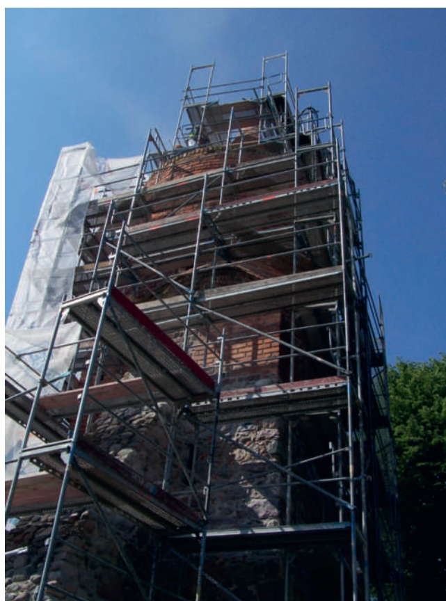
Ryc. 13. Baszta Więzienna, remont, 2013 r., fot. M. Bidol
