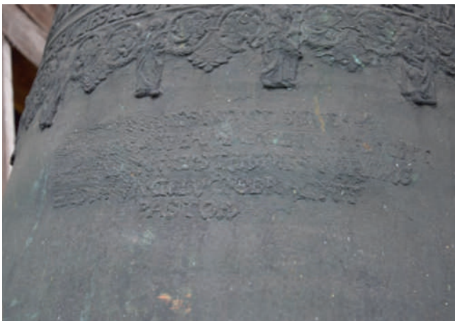
Ryc. 3. Usunięta mechanicznie inskrypcja na płaszczu dzwonu, fot. M. Tureczek 2020 r.
