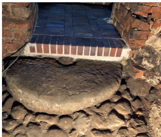
Ryc. 9b. Szprotawa, dawny klasztor magdalenek, piwnica, pasmo wschodnie, komora, stopień wejścia – stan po pracach, fot. A. Legendziewicz
