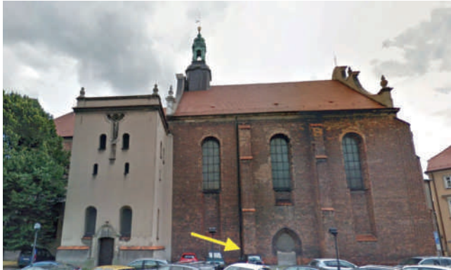
Ryc. 1. Kościół franciszkanów w Kaliszu – strzałka wskazuje miejsce wmurowania cegły ze śladami dwóch łap. Cegła ta znajduje się w ścianie przypory, w dobrze widocznym miejscu, na wysokości ok. 140 cm od obecnego poziomu terenu, fot. D. Mączyński
