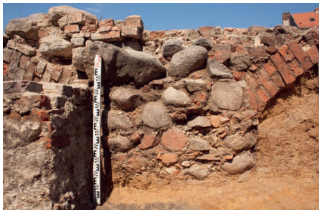
Ryc. 17. Zielona Góra, stan. 31, wykop 1. Fundament muru zbudowanego w konstrukcji łękowej, fot. B. Gruszka
