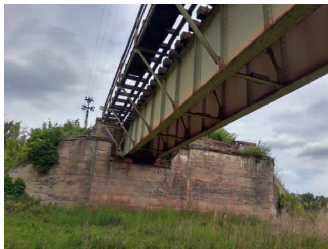
Ryc. 6. Most pod Pomorskiem – zrekonstruowany wtórnie w betonie przyczółek prawobrzeżny, fot. Archiwum Wojewódzkiego Urzędu Ochrony Zabytków w Zielonej Górze 2020 r.
