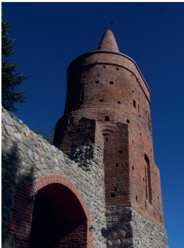
Ryc. 14. Baszta Więzienna, stan po remoncie, fot. M. Bidol
