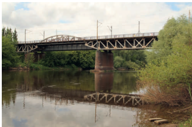
Ryc. 8. Układ kratownicowych przęseł mostu gerberowskiego na Starołęce w Poznaniu, fot. M. Urbaniak 2014 r.
