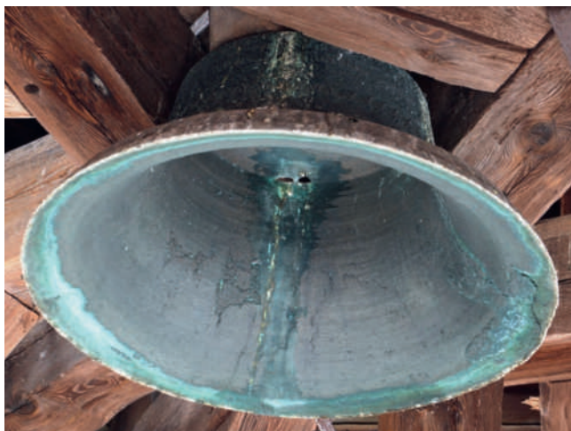
Ryc. 1. Dzwon zegarowy z 1635 r., widok wnętrza tuby wraz z otworami „przestrzałami”, naciekami korozyjnymi oraz śladami odlewniczymi, stan 18.08.2020 r., fot. M. Tureczek
