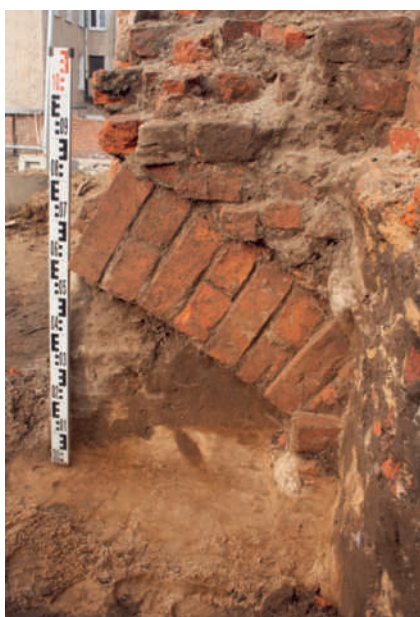
Ryc. 18. Zielona Góra, stan. 31, wykop 1. Fundament muru zbudowanego w konstrukcji łękowej, fot. B. Gruszka
