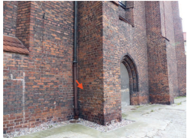
Ryc. 2. Lokalizacja cegły w ścianie przypory
