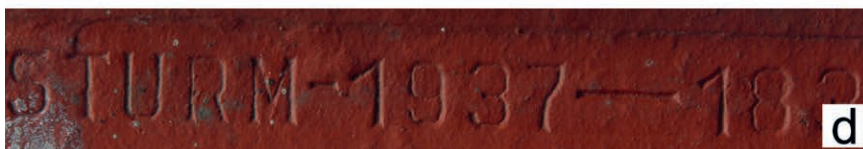
Ryc. 14. Przykłady oznaczeń cegielni: a) stempel cegielni w Bojadłach, b) stempel Birkenwerder CESS 8 – cegielnia Carla Ericha Seyringa i jego synów w Birkenwerder, c) znakowanie rolką na karpówce produkowanej w dachówczarni w Jasieniu; dachówka pochodząca z dachu bramy w Brodach, d) znakowanie rolką na dachówce zakładkowej produkowanej w zakładach ceramicznych Johanna Gottfrieda Sturma (Freiwaldauer Ziegelwerk) w Gozdnicy, fot. A. Duda 2020 r.
