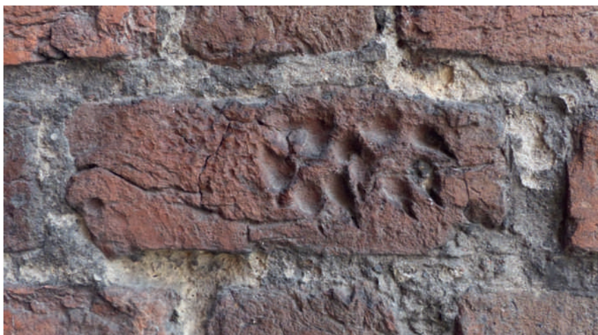
Ryc. 9. Kalisz – cegła z zewnętrznej przypory muru kościoła franciszkanów. Wymiary wozówki cegły – wysokość ok. 90 mm, długość ok. 265 mm. Wymiary pojedynczego śladu zwierzęcia ok. 60×65 mm. Ale czy faktycznie zwierzęcia? fot. D. Mączyński
