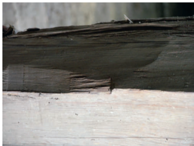
Ryc. 12. Lubiechnia Mała, kościół pw. Podwyższenia Krzyża, więźba nad korpusem, ślady obróbki toporem motykowatym
