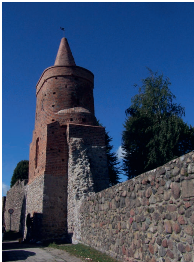
Ryc. 15. Baszta Więzienna, stan po remoncie, fot. M. Bidol
