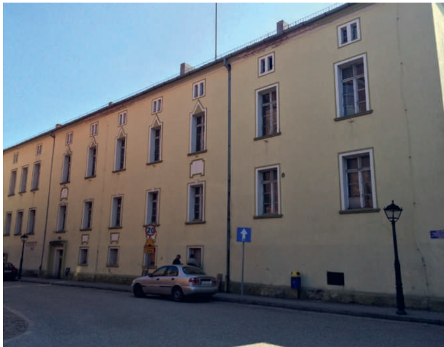
Ryc. 2a Szprotawa, dawny klasztor magdalenek, widok od północnego-zachodu – stan przed pracami, fot. A. Legendziewicz
