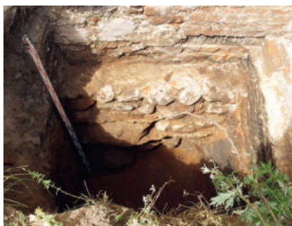
Ryc. 24. Szprotawa, dawny klasztor magdalenek, woj. lubuskie. Sondaż 3 – odsłonięta ława fundamentowa, fot. S. Kałagate
