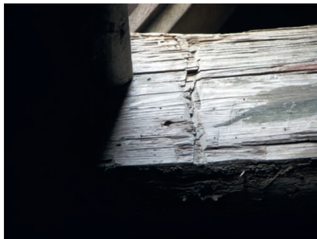
Ryc. 11. Lubiechnia Mała, kościół pw. Podwyższenia Krzyża, więźba nad korpusem, ślady obróbki siekierej
