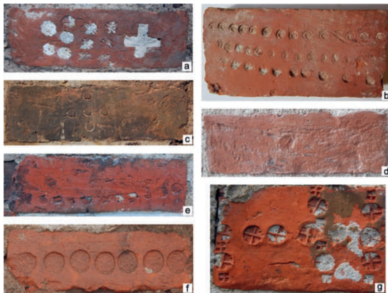
Ryc. 4. Cegły z oznaczeniami strycharскими w formie zwielokrotnionych stempli: a) cegła wmurowana w północną elewację zamku joannitów w Słońsku (powiat sulęciński), b) cegła wydobycza podczas badań archeologicznych z zasypu krypty w Gorzowie Wielkopolskim, c) cegła wmurowana we wschodnią ścianę wieży fary w Gubinie, d) cegła wmurowana w północną przyporę prezbiterium katedry w Gorzowie Wielkopolskim e) cegła południowej elewacji wieży kościoła parafialnego pw. Wniebowzięcia Najświętszej Maryi Panny w Żaganiu, f) cegła z tzw. tunelu przy ruinach zamku na terenie Starego Miasta w Kostrzynie nad Odrą (fot. K. Socha 2012 r.), g) cegła profilowana portalu kościoła filialnego Wniebowzięcia Najświętszej Maryi Panny w miejscowości Słowniu, gm. Dobiegniew, fot. A. Duda
