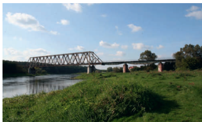
Ryc. 2. Most wspornikowy systemu Gerbera w Stobnicy – ustrój nośny kratownicowo-błachownicowy, fot. M. Urbaniak 2008 r.
