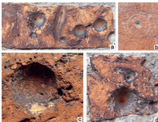
Ryc. 13. Przykład śladów krzesania ognia o mury świątyń: a) ślady świdra oraz prostego wgłębienia na cegle w kościele parafialnym pw. Chrystusa Króla w Dobiegniewie, b) ślad w początkowej fazie użycia świdra widoczny na cegle w kościele parafialnym pw. Chrystusa Króla w Dobiegniewie, c) ślad po świdrze w cegle na elewacji południowej nawy kościoła parafialnego pw. św. Jana Chrzciciela w Międzyrzeczu, d) ślad świdra na cegle w kościele parafialnym pw. Chrystusa Króla w Dobiegniewie, fot. A. Duda 2020 r.
