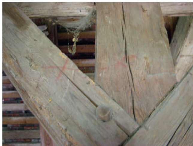
Ryc. 13. Lubiechnia Mała, kościół pw. Podwyższenia Krzyża, więźba nad korpusem, ciesielskie znaki wykonane sangwiną
