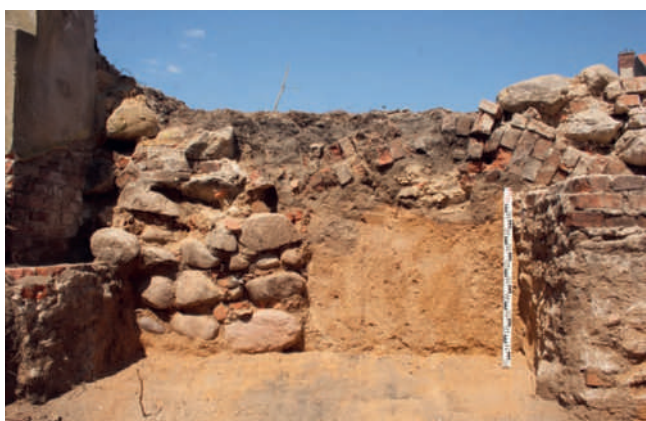
Ryc. 18. Zielona Góra, stan. 31, wykop 1. Fundament muru zbudowanego w konstrukcji łękowej, fot. B. Gruszka
