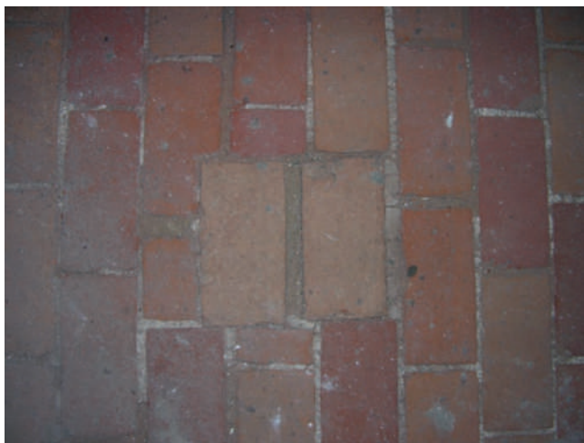
Ryc. 8. Lubiechnia Mała, kościół pw. Podwyższenia Krzyża, korpus, wnętrze, posadzka w obrębie wiązania nr 2, miejsce wtórnie uzupełnione za pomocą cegieł świadczących o lokalizacji słupa pierwotnej empory poprzecznej
