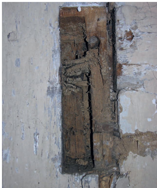
Ryc. 7. Lubiechnia Mała, kościół pw. Podwyższenia Krzyża, korpus, wewnątrz, ściana północna, wiązanie nr 2, słup z gniazdem czopowym oraz ślad po kółku poniżej trzeciego od dołu rzędu rygli
