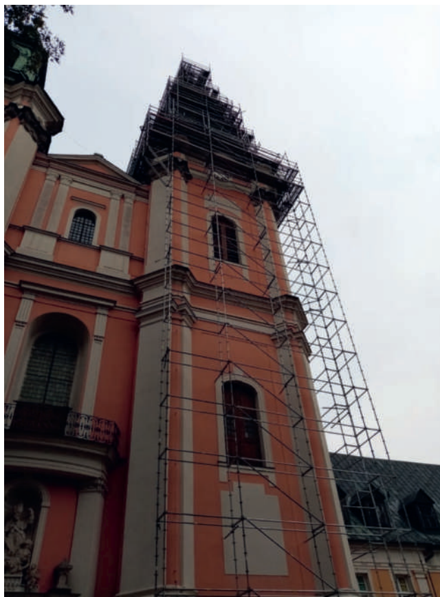
Ryc. 4. Wieża południowa klasztoru podczas prac konserwatorskich, stan 18.08.2020 r., fot. M. Tureczek
