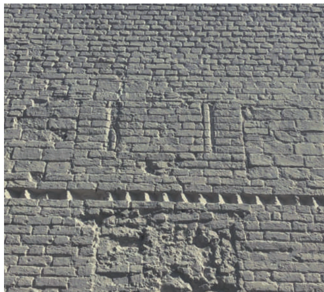
Ryc. 5c. Szprotawa, dawny klasztor magdalenek, elewacja zachodnia, detal szczytu gotyckiego – stan po pracach, fot. A. Legendziewicz
