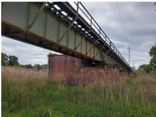
Ryc. 5. Most pod Pomorskiem – ciąg przęseł blachownicowych z przełomu lat 20. i 30. XX w. w strefie zalewowej, fot. Archiwum Wojewódzkiego Urzędu Ochrony Zabytków w Zielonej Górze 2020 r.
