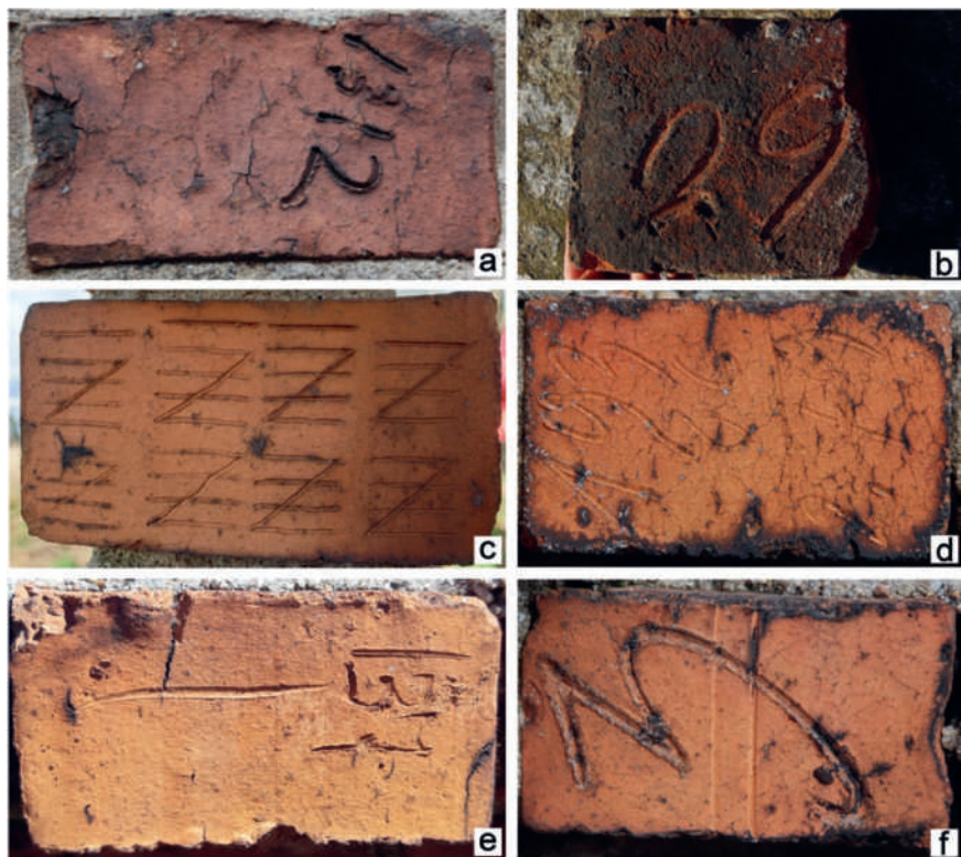
Ryc. 9. Przykłady oznaczeń rachunkowych: a) cegła w elewacji budynku gospodarczego w miejscowości Stypułów, gm. Koźuchów, b) fragment cegły z liczbą 29 odnaleziony na terenie zespołu pałacowo-parkowego w Zatoniu, c) cegła z numerycznym oznaczeniem kreskowym w murze ogrodzenia cmentarza w Mirocinie Dolnym, d) cegła z zapisem rachunkowym w murze ogrodzenia cmentarza w Mirocinie Dolnym, e) cegła z cyfrą 137 i kreską na główce cegły w murze ogrodzenia cmentarza w Mirocinie Dolnym, f) cegła z cyfrą 3 na główce w murze ogrodzenia cmentarza w Mirocinie Dolnym, fot. A. Duda 2020 r.
