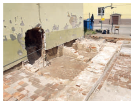
Ryc. 8. Szprotawa, dawny klasztor magdalenek, woj. lubuskie. Wykop II – odsłonięte relikty architektury późnośredniowiecznej i nowożytnej w północnej partii wykopu, pomieszczenia 2, 3 i 8, fot. S. Kałagate
