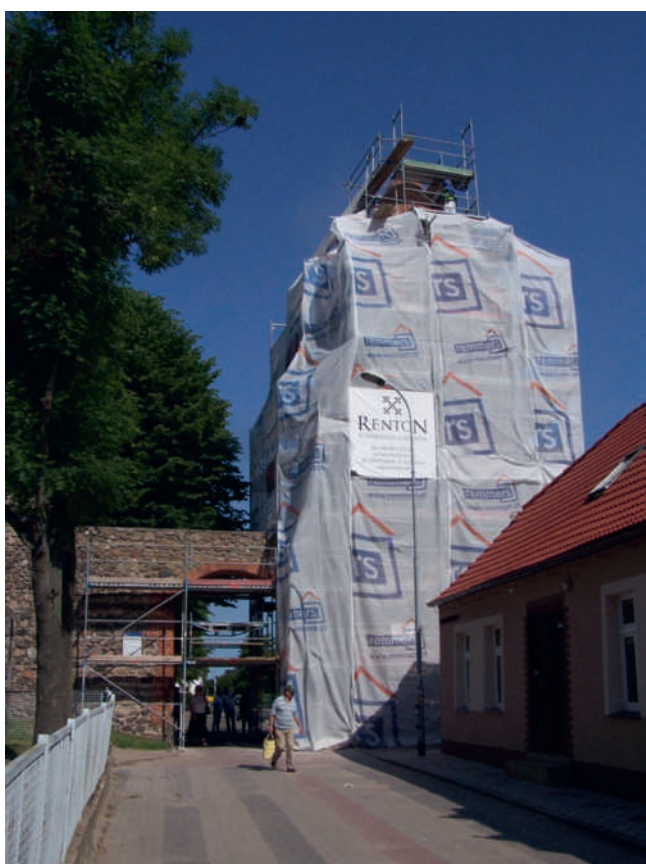
Ryc. 12. Baszta Więzienna, remont, 2013 r., fot. M. Bidol
