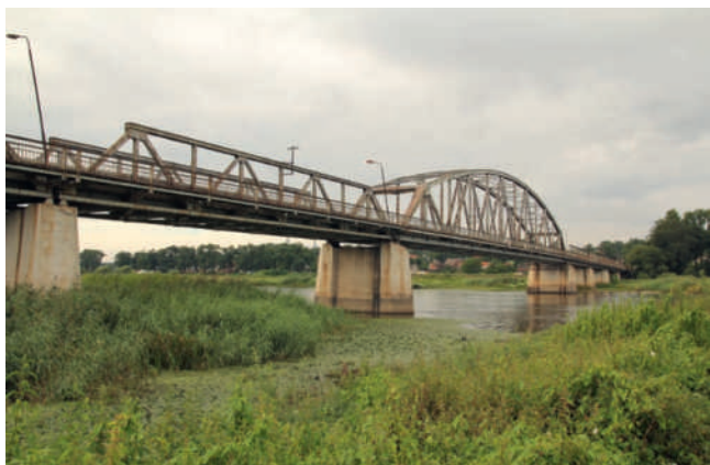
Ryc. 7. Oryginalne przęsło nurtowe i zalewowe mostu drogowego w Cigacicach z lat 20. XX w., fot. M. Urbaniak 2016 r.
