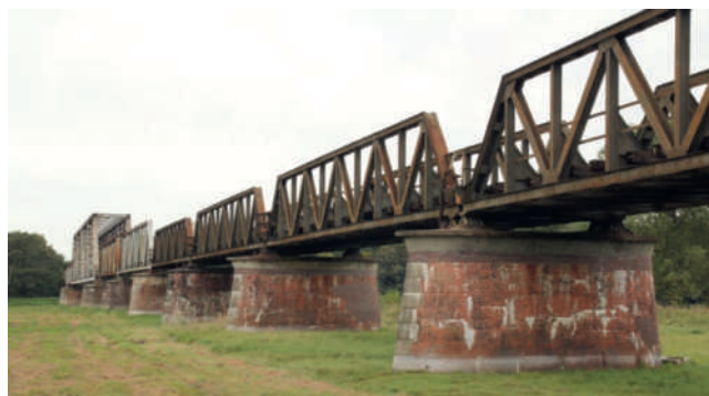
Ryc. 3. Most kolejowy w Stanach, w głębi przęsło nurtowe o rozpiętości ok. 100 m, fot. M. Urbaniak 2014 r.
