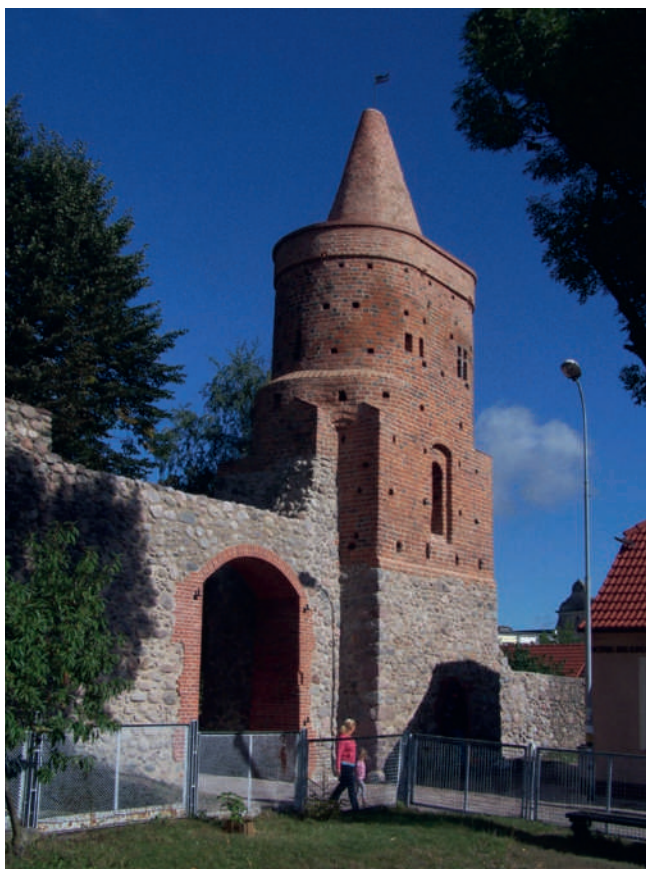
Ryc. 16. Baszta Więzienna, stan po remoncie, fot. M. Bidol
