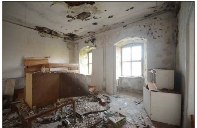
Fot. 18. Pokój marmurowy przed odgruzowaniem. Fot. A. Gutka, 2017 r.
