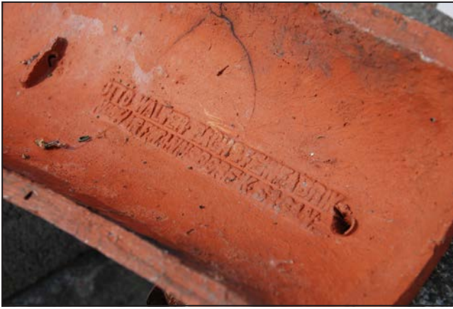
Fot. 37. Gąsior dachowy wyprodukowany przez zakłady Dachsteinfabrik Otto Walter w Witoszynie, fot. Alicja Duda
