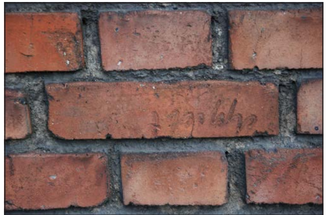
Fot. 49. Szczaniec, cegła wmurowana w elewację budynku gospodarczego, fot. Alicja Duda
