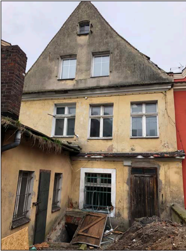
Fot. 5. Zielona Góra, parcela przy ul. Artura Grottgera 1, kamienica frontowa, elewacja zachodnia
