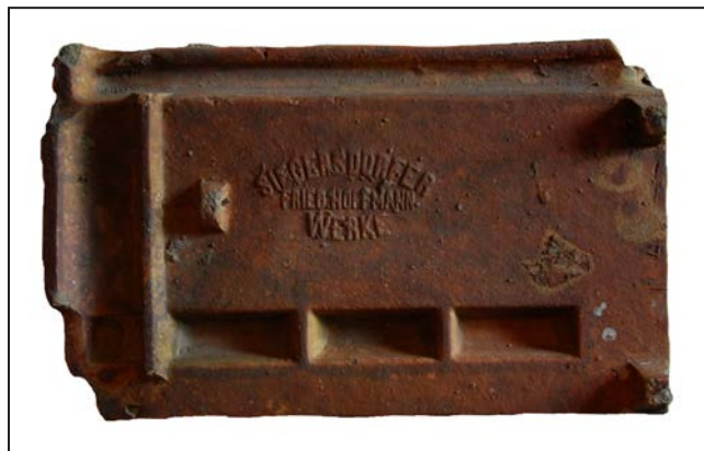
Fot. 36. Solniki, dachówka zakładkowa pochodząca z kościoła w Solnikach (gm. Kozuchów), wyprodukowana w fabryce ceramiki budowlanej Siegersdorfer (Zebrzydowa), ze zbiorów Izby Regionalnej w Kozuchowie, fot. Alicja Duda
