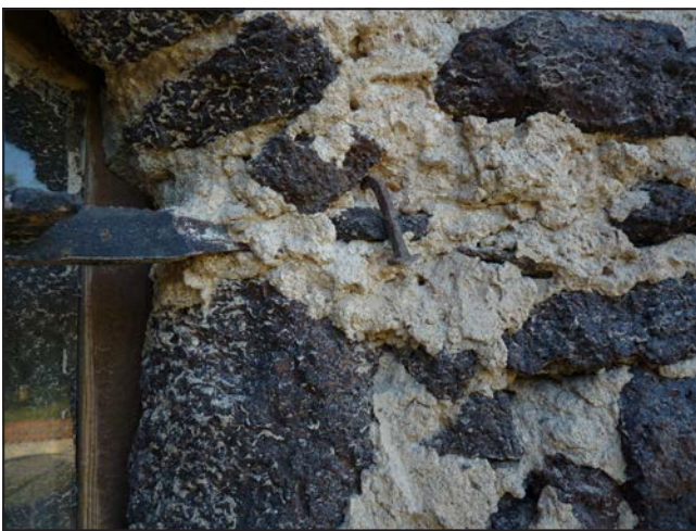
Fot. 10. Metal i drewno w ścianach kościoła, fot. D. Kwaśniak
