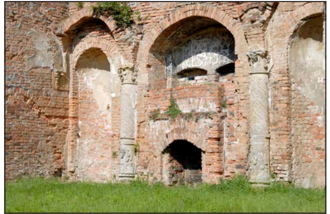
Il. 6. Widok na ścianę wsch. dawnej sali ogrodowej zamku w Siedlisku z półkolumnami i pozostałością kominka. Stan z 2011 r. Fot. K. Adamek-Pujszo
