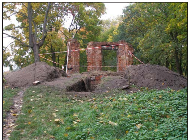
Ryc. 16. Żary, „Domek winniczy”, widok na wykop nr I oraz zachowane relikty barokowego budynku, ujęcie z E na W. Fot. dr Jarosław Lewczuk
