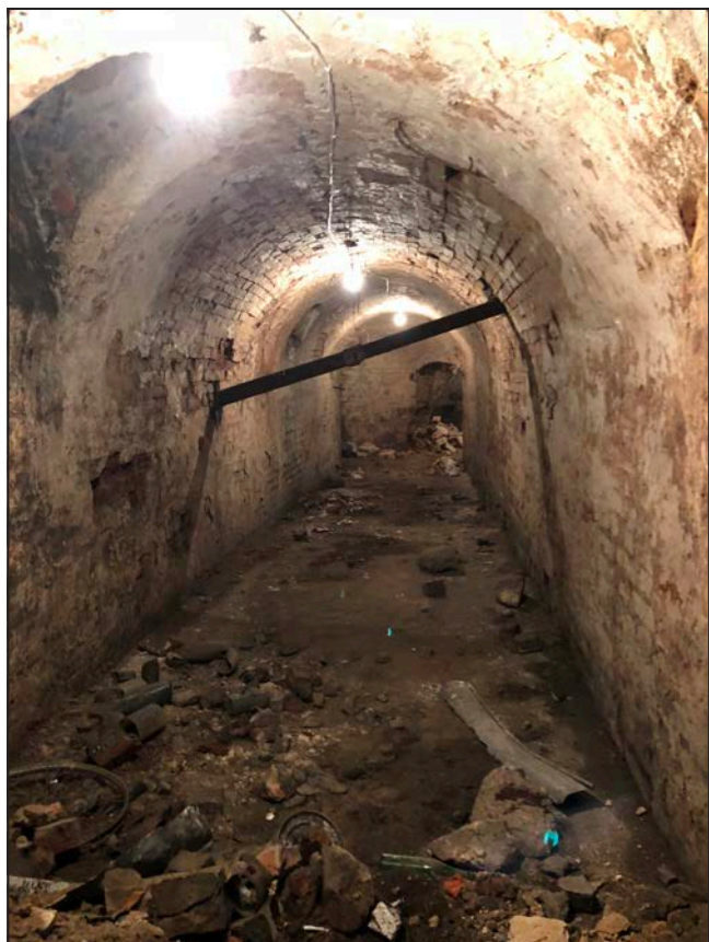
Fot. 9. Zielona Góra, parcela przy ul. Artura Grottgera 1, oficyna, piwnice, komora między kamienicą a oficyną, widok ku wschodowi
