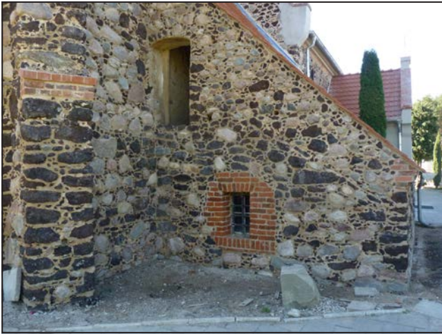
Fot. 5. Odkryte wejście we wschodniej ścianie zakrystii, fot. D. Kwaśniak
