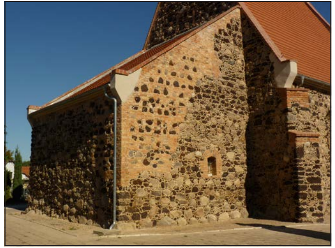
Fot. 7. Odkryty przemurowany narożnik dawnej wieży, fot. D. Kwaśniak
