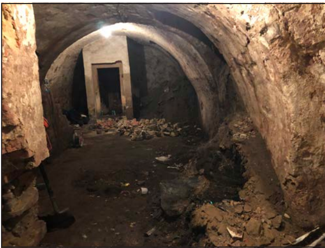
Fot. 8. Zielona Góra, parcela przy ul. Artura Grottgera 1, oficyna, piwnice, komora widok ku zachodowi
