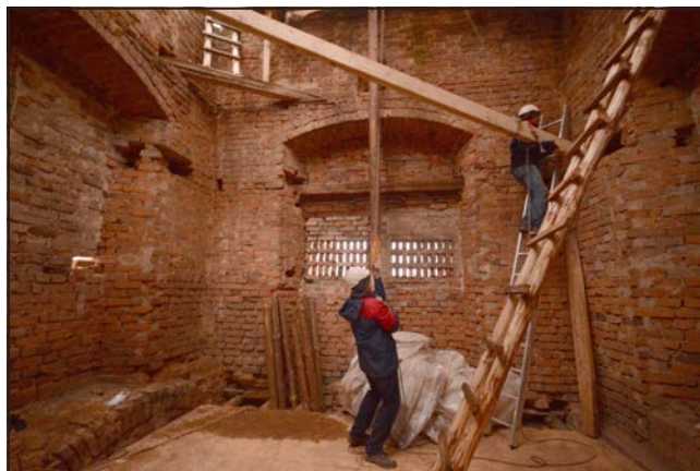
Fot. 3. Prace ratunkowe przy hełmie wieży bramnej. Fot. A. Dziadek, Lubuski Oddział TOnZ, 2017 r.
