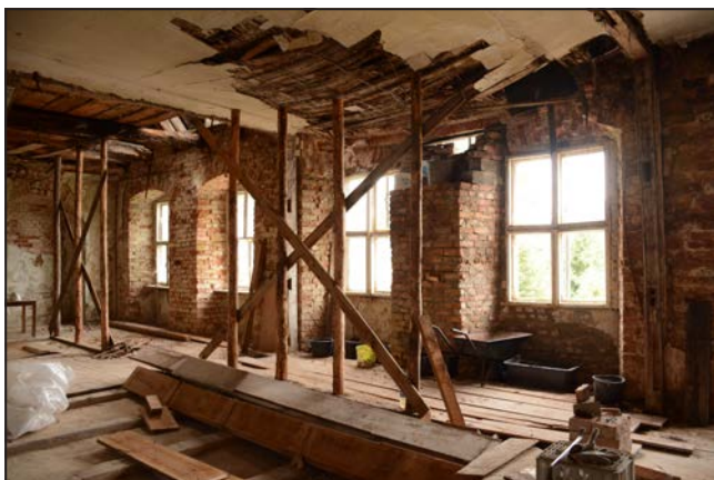
Fot. 5. Wnętrze I p. pałacu po odgruzowaniu i wstępnych pracach zabezpieczających. Fot. A. Gutka, 2018 r.
