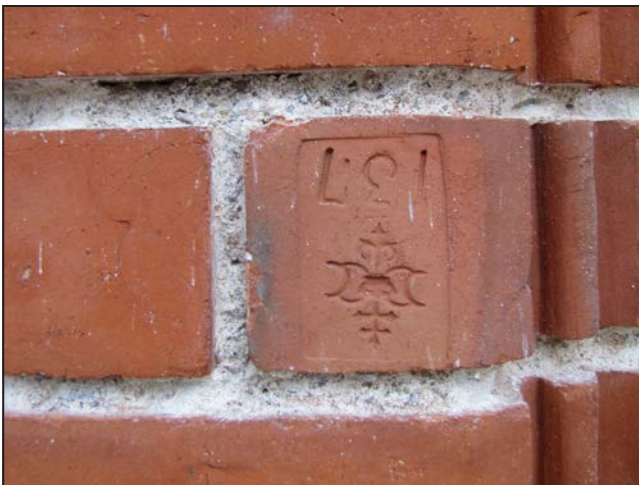
Fot. 39. Żagań, kształtka ceramiczna wmurowana w elewację dawnego szpitala księżnej Doroty de Talleyrand-Périgord w Żaganiu, fot. Alicja Duda
