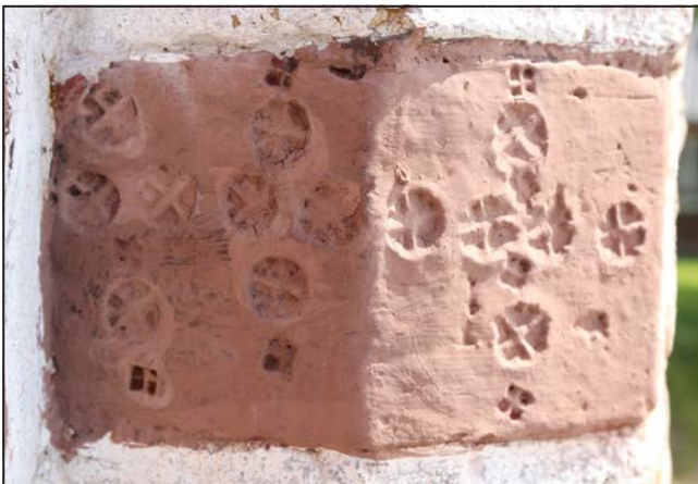
Fot. 6. Słowin, cegła wmurowana w portal kościoła filialnego pw. Wniebowzięcia NMP w miejscowości Słowin (gm. Dobiegniew). Fot. Marceli Tureczek
