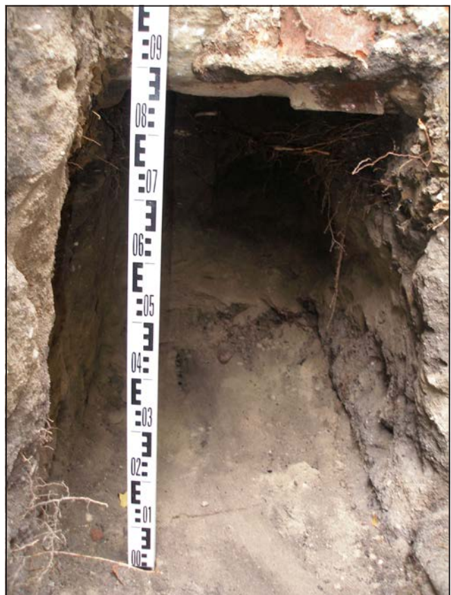
Ryc. 15. Żary, „Domek winniczy”, widok całościowy na przekop poniżej spągu muru fundamentowego budowli, ujęcie ze strony E na W. Fot. dr Jarosław Lewczuk
