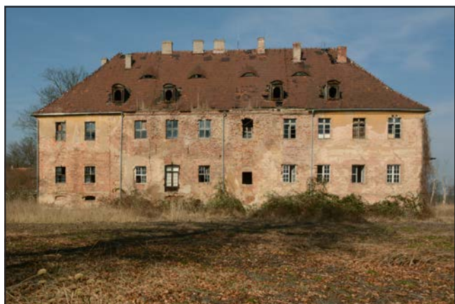
Fot. 9. Elewacja pałacu od strony parku, widok przed rozpoczęciem prac zabezpieczających na dachu. Fot. A. Gutka, 2017 r.
