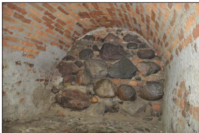
Ryc. 4. Kożuchów. Ściana północna krypty po uporządkowaniu. Fot. J. Wrześciński
