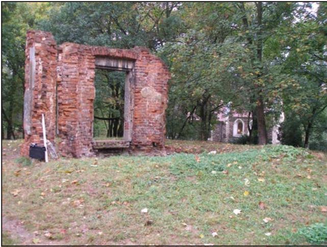
Ryc. 2. Żary, dawny park pałacowy Promnitzów, grodzisko WS, st. nr 3 w/m, dz. nr ewid 19, obręb 0003, widok na pozostałości „Domku winniczego”, ujęcie od strony SE na NW. Fot. dr Jarosław Lewczuk
