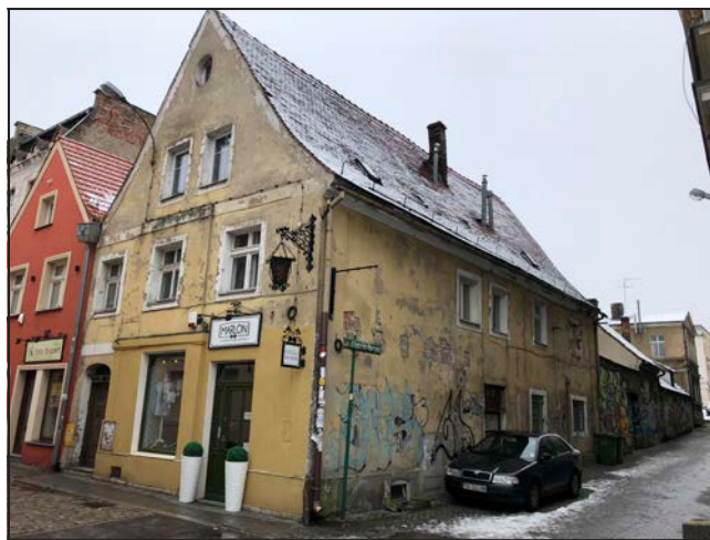
Ryc. 4. Zielona Góra, parcela przy ul. Artura Grottgera 1, kamienica frontowa, widok ogólny od północnego-wschodu
