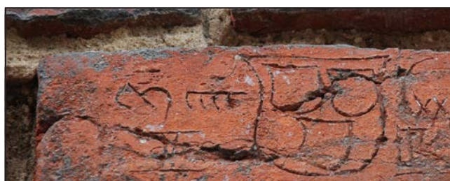
Fot. 3. Gorzów Wielkopolski, cegła wmurowana we wschodnią elewację prezbiterium katedry gorzowskiej. Fot. Alicja Duda
