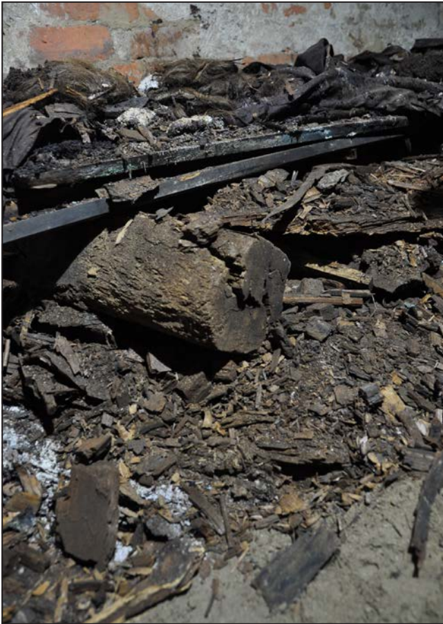
Ryc. 7. Kozuchów. Wnętrze krypty – część wschodnia, przed rozpoczęciem prace. Fot. J. Wrzeński
