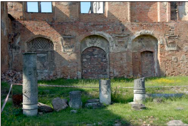
Il. 5. Widok na dawną salę ogrodową zamku w Siedlisku i relikty kolumn od strony płd. Stan z 2011 r. Fot. K. Adamek-Pujszo
