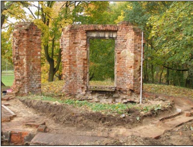
Ryc. 17. Żary, „Domek winniczy”, widok na odsłonięty zarys murów fundamentowych, ujęcie ze strony E na W (widoczne zachowane fr. ścian W i SW). Fot. dr Jarosław Lewczuk
