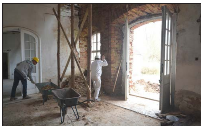
Fot. 11. Prace przy odgruzowywaniu holu na parterze pałacu. Fot. A. Dziadek, 2018 r.
