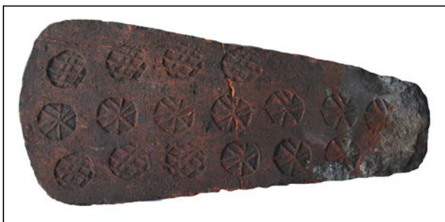
Fot. 24. Świdnica, dachówka karpiówka w typie tzw. ogona bobra (niem. Biberschwantz ), egzemplarz pochodzący z dachu kościoła pw. św. Marcina w Świdnicy, fot. Alicja Duda
