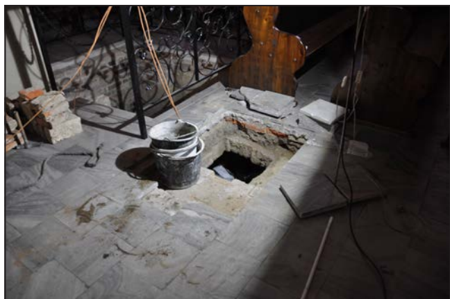
Ryc. 2. Kożuchów. Odsłonięte w posadzce wejście do krypty. Fot. J. Wrześciński
