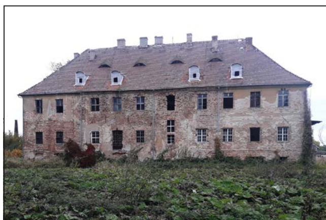
Fot. 13. Elewacja pałacu od strony parku, widok po zakończeniu prac zabezpieczających na dachu. Fot. A. Gutka, 2018 r.
