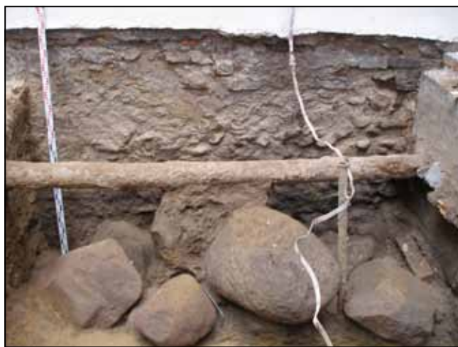
Ryc. 4. Kozuchów, zamek, dziedziniec, wykop nr I, ściana E wykopu, widoczny kamienny mur fundamentowy zamku piastowskiego oraz pozostałości kamiennej ławy fundamentowej pod przyporę domu gotyckiego. Fot. J. Lewczuk.
