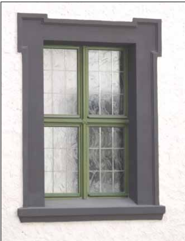
Fot. 34. Zrekonstruowana stolarka okienna. Fot. M. Domańska-Tomczyk.
