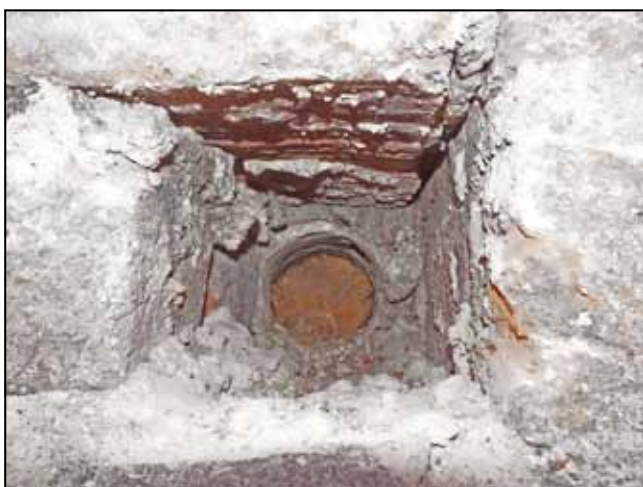
Fot. 14. Widoczny fragment muru gotyckiego z otworem moczulcowym z zachowanym fragmentem rusztowania drewnianego. Fot. M. Domańska-Tomczyk.
