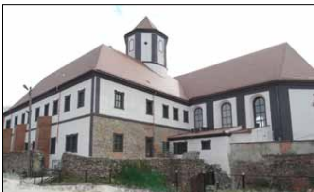
Fot. 19. Elewacja płn.-zach. Stan po konserwacji. Widoczne tynki wapienne, nakrapiane z odtworzoną kolorystyką oraz stolarką okienną. Okna kaplicy malowane iluzjonistycznie. Fot. M. Domańska-Tomczyk.
