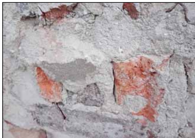
Fot. 15. Świadek tynku XIX w. odkryty na elewacji wschodniej. Fot. M. Domańska-Tomczyk.
