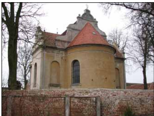
Ryc. 3. Elewacja wschodnia (prezbiterialna) kościoła z murem obwodowym. Fot. G. Urbanek 2006.
