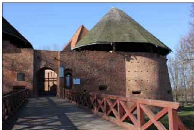
Ryc. 9. Międzyrzecz, zamek – zewnętrzne lica muru bramy wjazdowej (łącnika między bastejami) i bastei północnej; stan po wykonaniu prac remontowo-konserwatorskich. Fot. A. Indycka.
