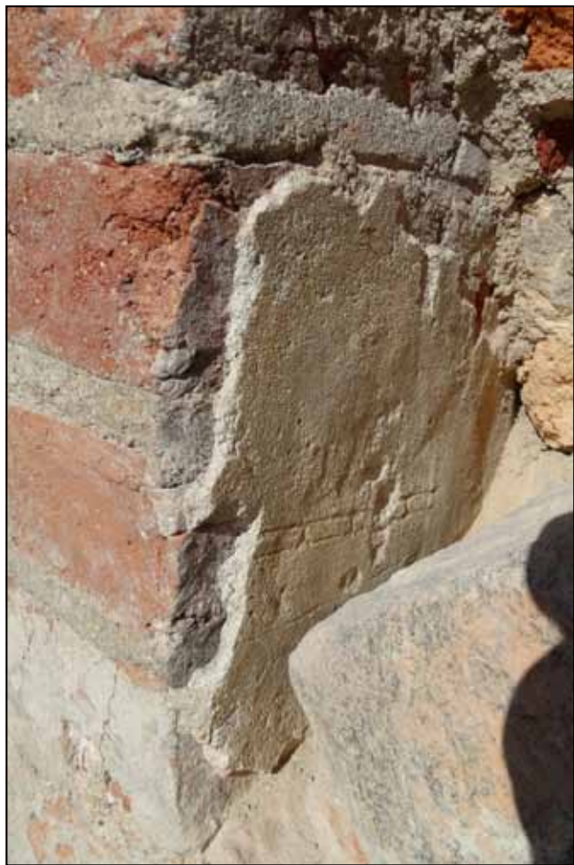
Fot. 2. Widoczny zachowany fragment tynku w glicie wejścia bramnego pochodzącego z II fazy zamku (zachowały się warstwy pobiał – nałożona bezpośrednio na wążku ceglany, a na niej druga warstwa tynku wapiennego z pobiałą i gmerkami). Fot. M. Domańska-Tomczyk.
