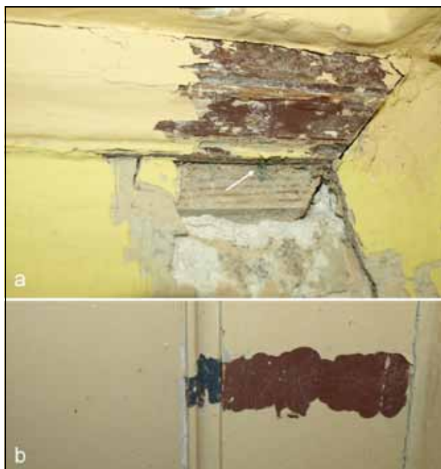
Fot. 6. Pomieszczenie mieszkalne na I piętrze. a) Zachowana spodnia i wierzchnia listwa systemu napinania tkaniny na ściany z jej pozostałościami (zaznaczone strzałką). b) Płycina pod parapetem okiennym, widoczna pierwotna kolorystyka czarno-brązowa.
