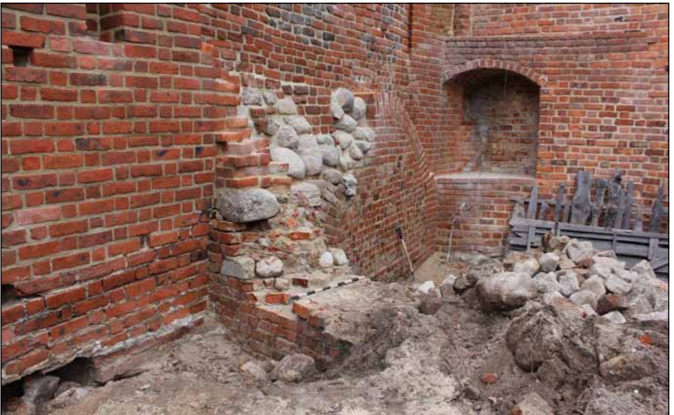
Fot. 14. Międzyrzecz, zamek (odcinek północny, część wschodnia) – odsłonięty relikw budynku nowożytnego; widok od południowego zachodu. Fot. A. Indycka.
