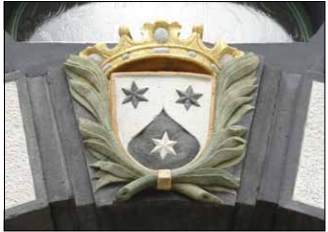
Fot. 31. Widok na portal na elewacji płd. po konserwacji. Widoczny oczyszczony i uzupełniony portal z odtworzoną kolorystyką i złoconiem korony. Fot. M. Domańska-Tomczyk.
