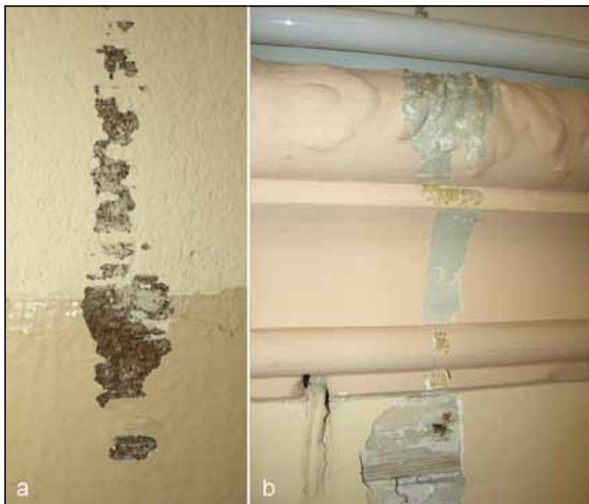
Fot. 1. Pomieszczenie reprezentacyjne, sąsiadujące z salą balową. a) Odkrywka we wnęce okiennej; obszary ścian nieprzykryte tkaninami pomalowano brązową olejnica. b) Gzyms między ścianą i stropem oryginalnie malowany na szaro farbą klejową i lokalnie złożony w celu podkreślenia profilu oraz liści akantowych. Pod sztukaterią widoczna listwa drewniana, do której przybito tkaninę stanowiącą rodzaj tapety.
