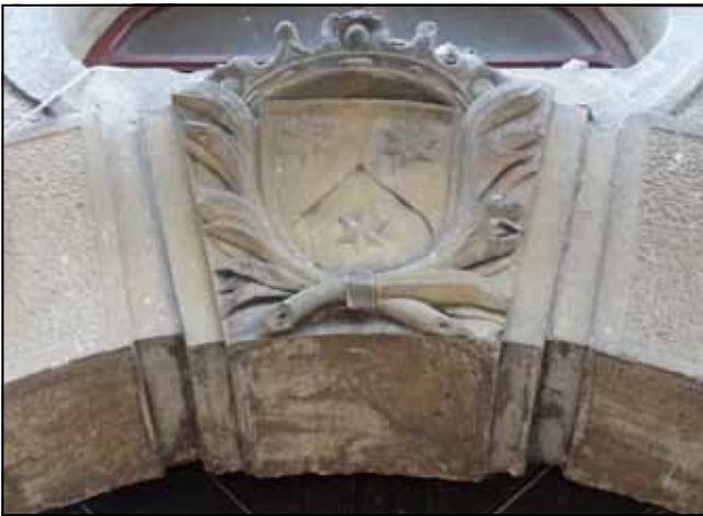
Fot. 30. Widok na portal na elewacji płd. przed konserwacją. Widoczne zabrudzenia i patyna na kamiennym herbie. Fot. M. Domańska-Tomczyk.
