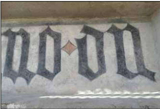
Fot. 26. Fragment inskrypcji na elewacji płd. nad pierwotną bramą wjazdową na średniowieczny zamek. Stan po scaleniu kolorystycznym uzupełnień. Fot. M. Domańska-Tomczyk.
