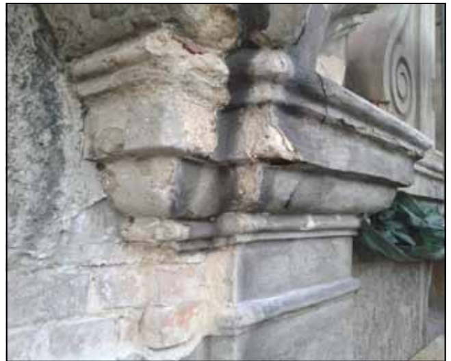
Fot. 28. Widok na fragment portalu. Stan przed konserwacją z widocznymi zniszczeniami tynków. Fot. M. Domańska-Tomczyk.
