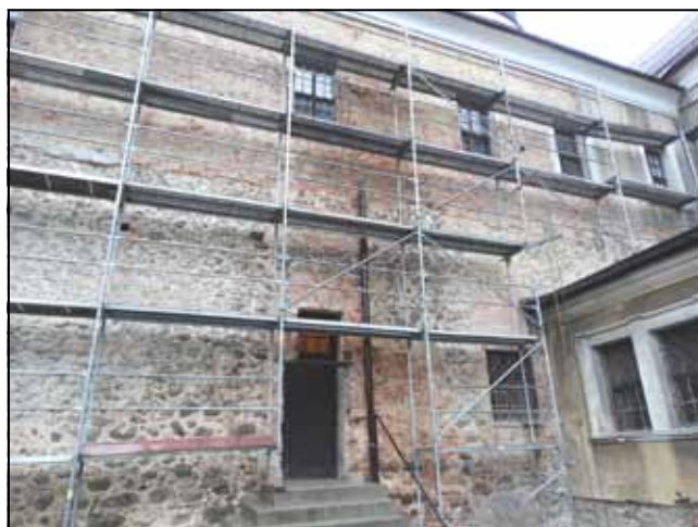
Fot. 11. Elewacja zachodnia po usunięciu tynków nakrapianych z lat 20. XX w. i odsłonięciu wątku ceglano i kamiennego z XV/XVI w. Fot. M. Domańska-Tomczyk.
