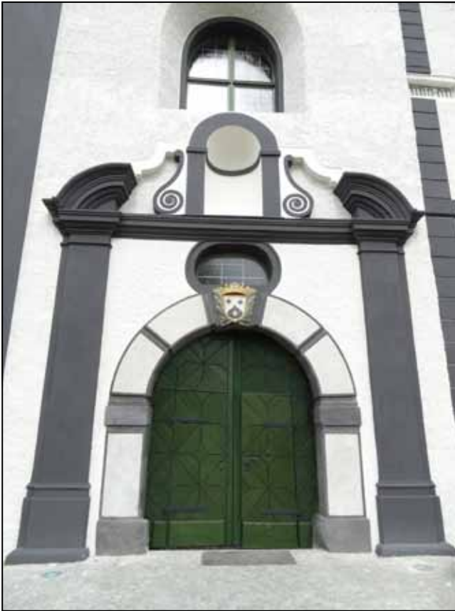
Fot. 33. Widok na portal na elewacji płd. Stan po konserwacji. Widoczny oczyszczony i uzupełniony portal z odtworzoną kolorystyką i złożeniem korony oraz drewnianą odnowioną bramą. Fot. M. Domańska-Tomczyk.
