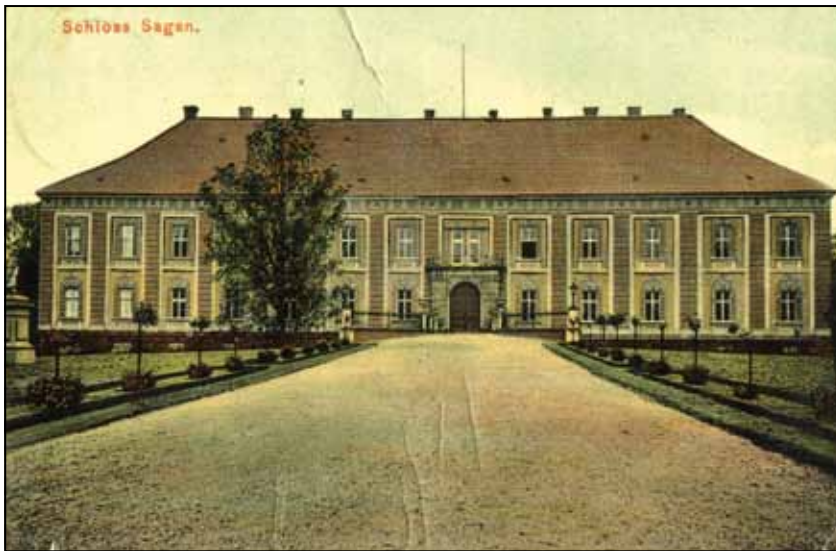
Il. 4. Widok na aleję dojazdową przed skrzydłem frontowym pałacu w Żaganiu. Stan sprzed 1908 r. Pocztaówka ze zbiorów własnych.
