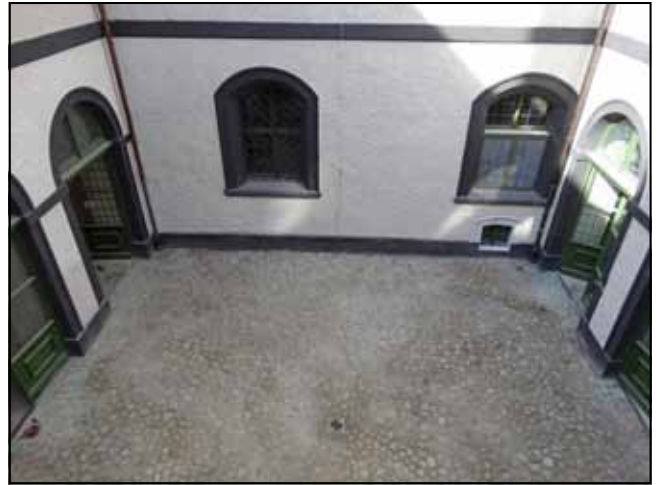
Fot. 35. Widok na ścianę zach. dziedzińca. Stan po konserwacji. Bruk wykonany z kamieni polnych, otoczków, ze spadkami do odpływu na środku posadzki. Fot. M. Domańska-Tomczyk.
