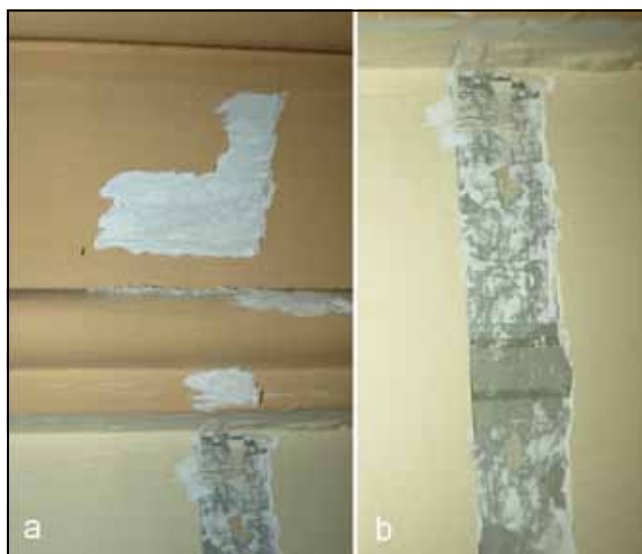
Fot. 7. Jedno z pomieszczeń mieszkalnych na I piętrze. Jasnoszare profile sztukaterii oraz szarozielone ściany z delikatną dekoracją w formie pasków podkreślających krawędzie pod sztukateriami i przy narożnikach ścian.
