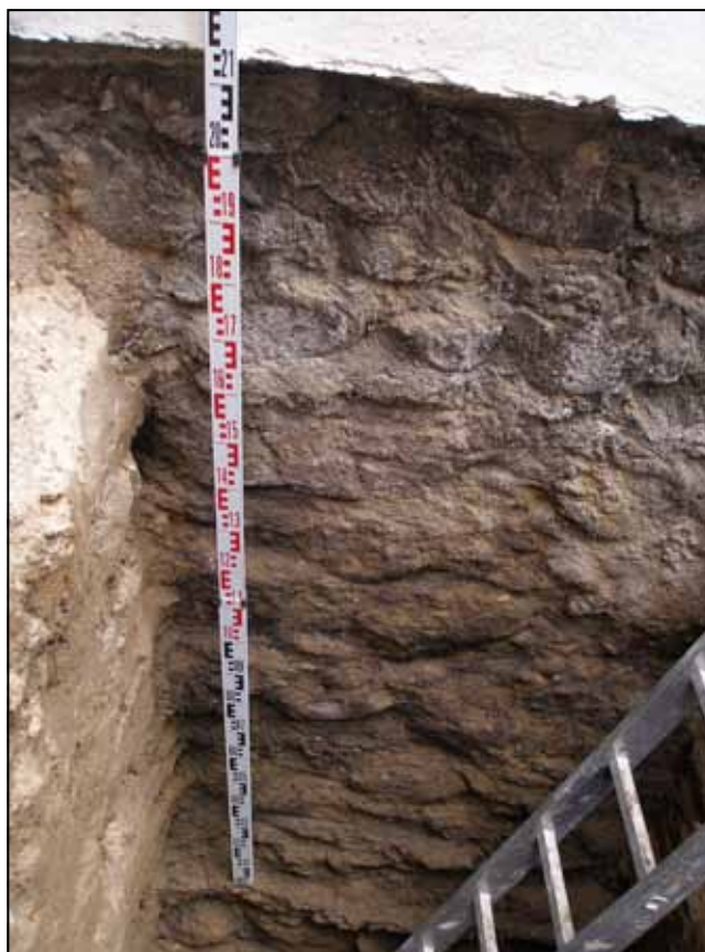
Ryc. 5. Kozuchów, zamek, dziedziniec, wykop nr II, ściana zachodnia domu gotyckiego w obrębie zamku piastowskiego, gł. 215 cm; łąta oparta na warstwie zaprawy cementowo-wapiennej (do tej gł. wykonano izolację pionową murów zamku w l. 70./80. XX w.). Fot. J. Lewczuk.
