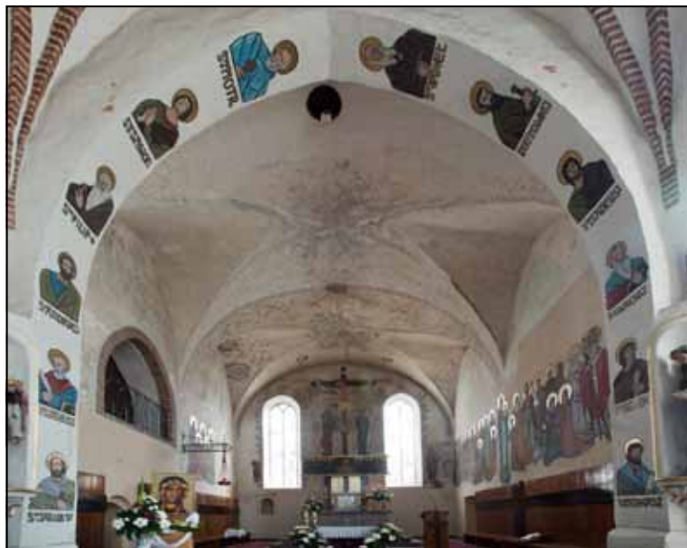
Fot. 1. Wnętrze kościoła pw. św. Jana Chrzciciela w Międzyrzeczu przed rozpoczęciem prac w 2014 r. Fot. D. Kwiecień.
