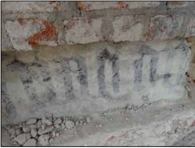
Fot. 5. Widok na zachowaną lewą wnękę z inskrypcją z XVI w. po usunięciu zamurowania. Na powierzchni zabielenie z zaprawy wapiennej oraz liczne ubytki i pęknięcia. Fot. M. Domańska-Tomczyk.
