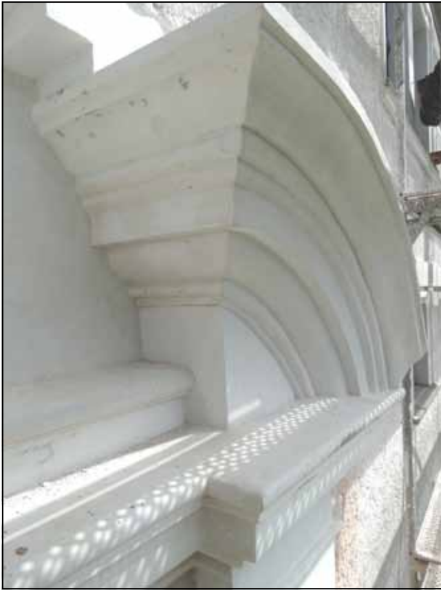
Fot. 29. Widok na fragment portalu. Stan w trakcie prac. Widoczne profile portalu po częściowej rekonstrukcji. Fot. M. Domańska-Tomczyk.
