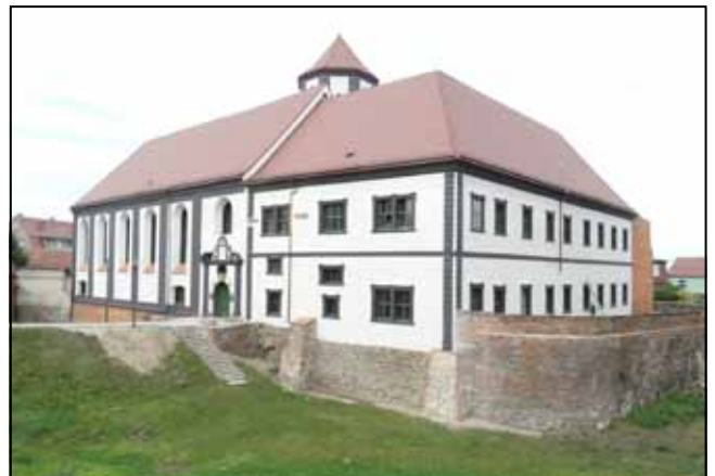
Fot. 37. Zamek w Koźuchowie. Elewacja płd. Stan po konserwacji. Widoczny oczyszczony wątek kamienny oraz ceglany, odtworzone tynki nakrapiane, zrekonstruowana stolarka okienna, kamienny portal po konserwacji i odtworzeniu kolorystyki. Fot. M. Domańska-Tomczyk.
