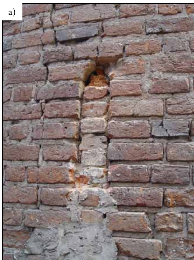
Ryc. 8. Koźuchów, zamek, wieża, zablockowane okno szczelinowe (a), prześwit blankowania przekształcony w okno (b) (fot. A. Legendziewicz).
