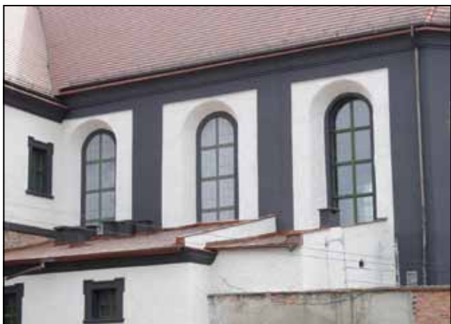
Fot. 18. Elewacja zach. Widok ogólny. Stan po konserwacji. Okno lewe i środkowe kaplicy zostało namalowane iluzjonistycznie. Fot. M. Domańska-Tomczyk.
