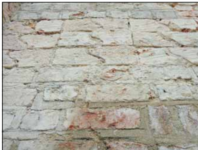
Fot. 3. Widoczna cegła profilowana służąca do zamurowania inskrypcji, podczas rozbudowy w XVIII w. Fot. M. Domańska-Tomczyk.
