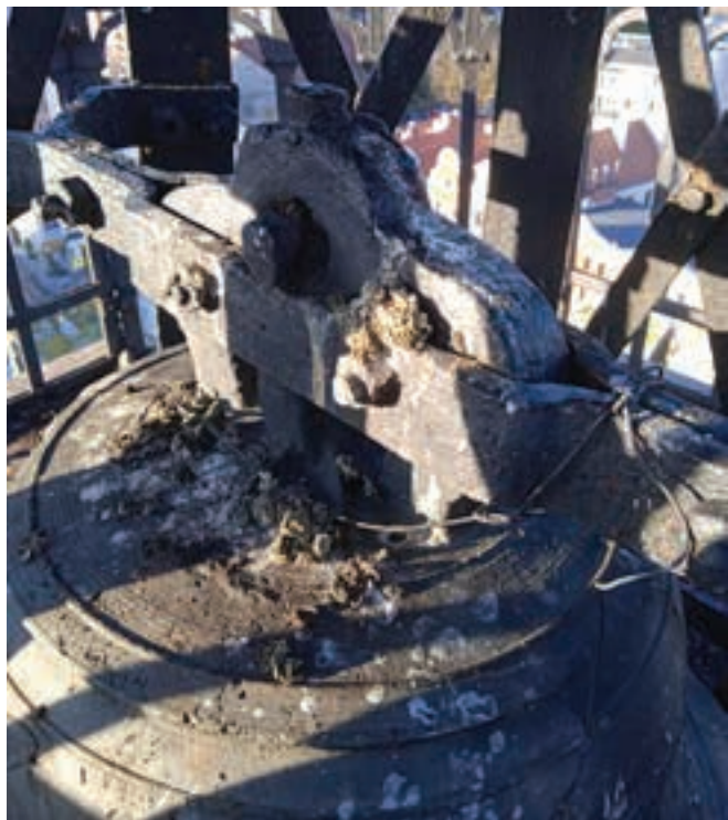
13. Zawieszenie dzwonu dolnego zegarowego z XVII wieku. Fot. M. Tureczek
