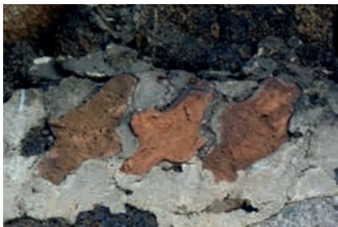
Fot. 4. Kształtki w elewacji południowej. Fot. D. Kwaśniak
