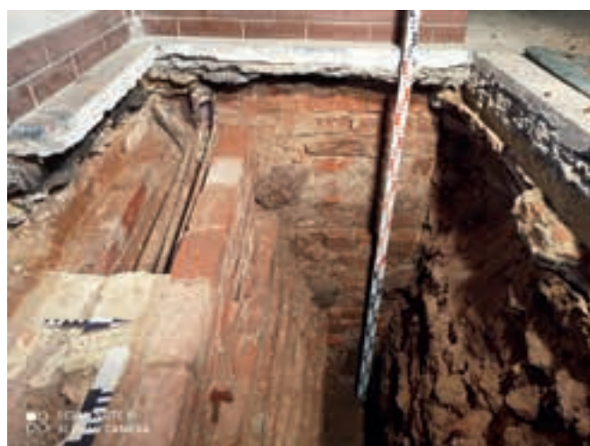
Fot. 11. Sondaż „A”. Lico wschodnie fundamentu pod mur zachodni kościoła (konstrukcja „C”). Z boku, po lewej stronie „schodkowy” fundament pod półkolumnę (konstrukcja „B”). Ujęcie od E, z góry. Fot. P. Banaszak
