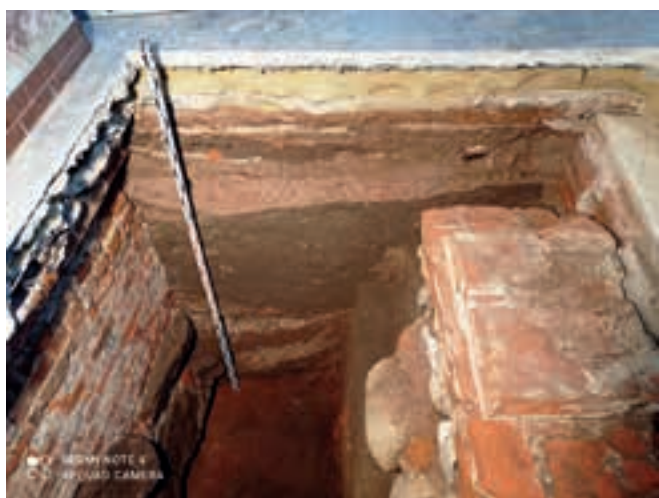
Fot. 18. Sondaż „C”. XVIII-wieczny relikw fundamentu pod drewniany słup dawnej empory (konstrukcja „B”). Ujęcie od S, z góry. Fot. P. Banaszak
