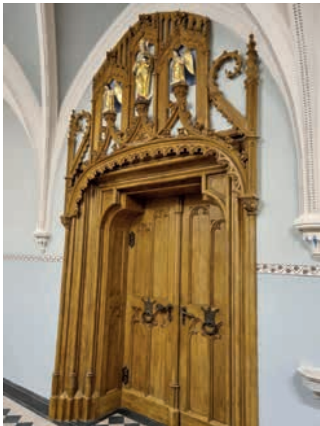
16. Stolarka neogotycka po konserwacji – wejście do kaplicy św. Doroty. Stan z 2020 roku. Fot. B. Bieliniś-Kopeć
