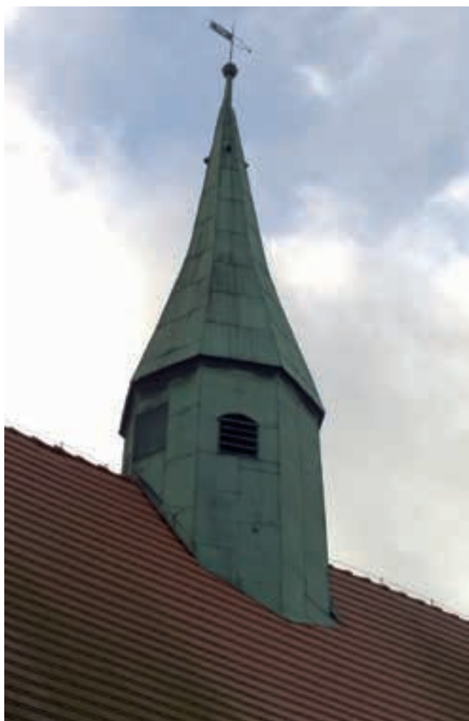
3. Chrobrów, kościół pw. św. Augustyna, sygnaturka, widok od południowego zachodu. Fot. K. Błaszczyk, stan w 2019 roku
