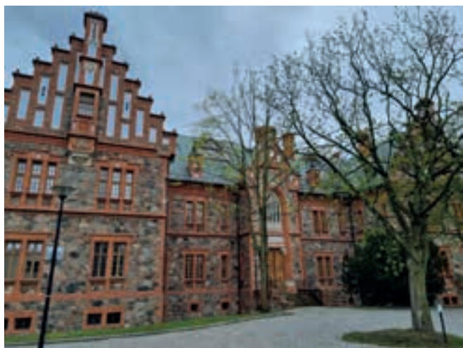
3. Budynek główny. Elewacja frontowa od strony południowej. Fot. B. Bieliniś-Kopeć
