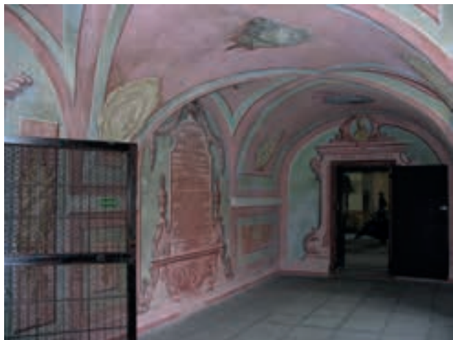
21. Żagań, zespół klasztorny, korytarz w skrzydle wsch. na piętrze – przy wejściu do biblioteki. Fot. K. Adamek-Pujso, 2010
