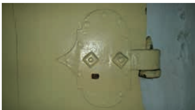
13. Chrobrów, kościół pw. św. Augustyna, kruchta, drzwi – zawias tarczowy. Fot. K. Błaszczyk, stan w 2019 roku
