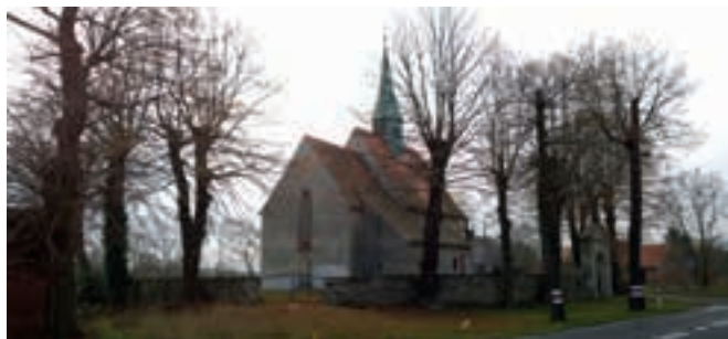
2. Chrobrów, kościół pw. św. Augustyna, widok od północnego wschodu. Fot. K. Błaszczyk, stan w 2019 roku
