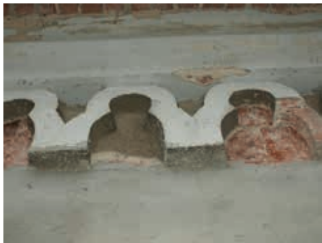
3. Arkadowy fryz pod gzymszem koronującym elewacji północnej w trakcie prac remontowych przy elewacji w 2010 roku, widoczna czerwona warstwa malarska położona bezpośrednio na ceglany murze. Fot. P. Celecka
