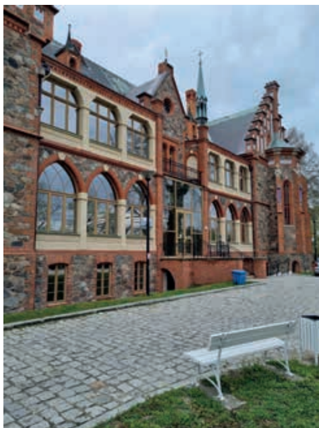
5. Budynek główny. Elewacja północna. Fot. B. Bielinis-Kopeć
