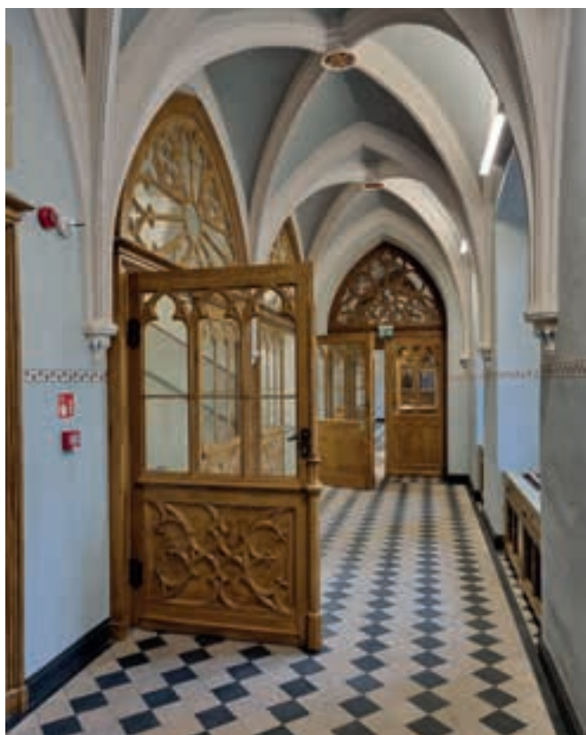
13. Hol na parterze w budynku głównym po pracach konserwatorskich, stan z 2020 roku. Fot. B. Bielinis-Kopec
