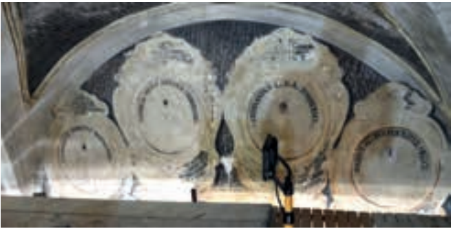
2. Fragmenty galerii w trakcie prac konserwatorskich. Fot. M. Tureczek
