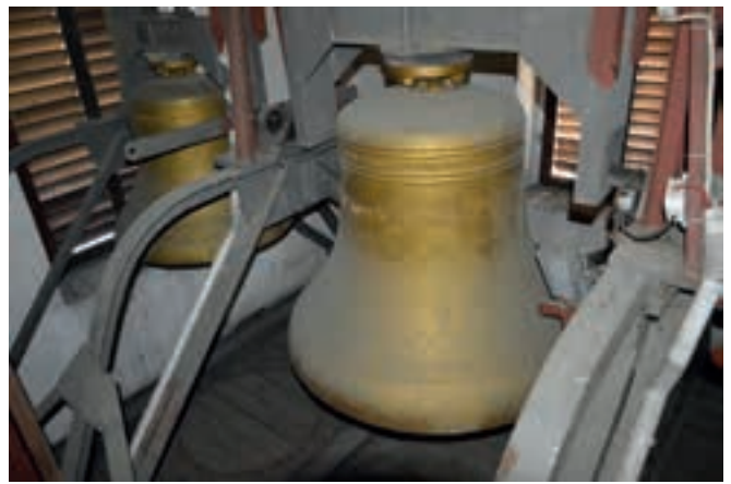
2. Staliwne dzwony z Witoszyna (powiat zagański) odlane w Bochum w 1918 roku. Tego typu instrumenty ciągle czekają na odrębne opracowanie na tle odlewnictwa dzwonów z brązu. Fot. M. Tureczek
