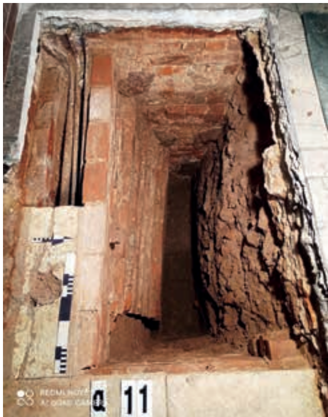
Fot. 8. Sondaż „A”. Sytuacja po zakończeniu eksploracji i odsłonięciu konstrukcji „A” – „C”. Ujęcie od E, z góry. Fot. P. Banaszak
