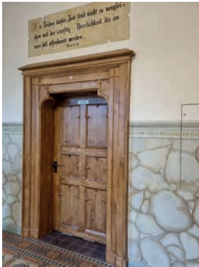
17. Stolarka drzwiowa i odsłonięte inskrypcje po konserwacji w korytarzu w budynku głównym. Stan z 2020 roku. Fot. B. Bieliniś-Kopeć
