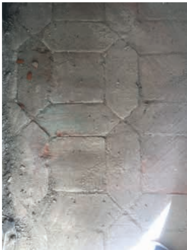
5. Posadzka odkryta po usunięciu wtórnej wylewki betonowej. Fot. P. Celecka
