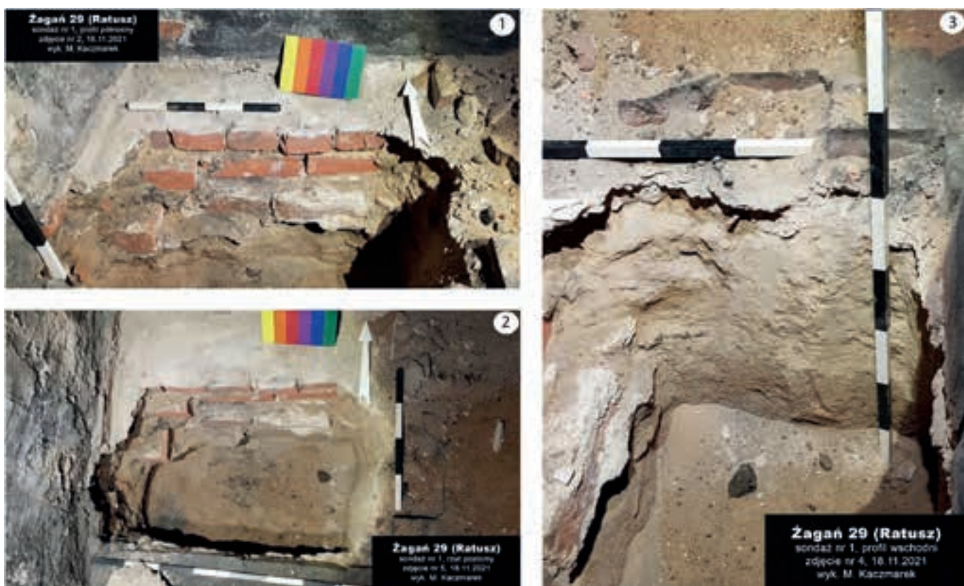
Ryc. 10. Odkrywka sondażowa nr 1 przedstawiająca warstwy gruntowe oraz konstrukcję fundamentową budynku: 1 – profil północny, 2 – rzut poziomy, 3 – profil wschodni. Oprac. M. Kaczmarek
