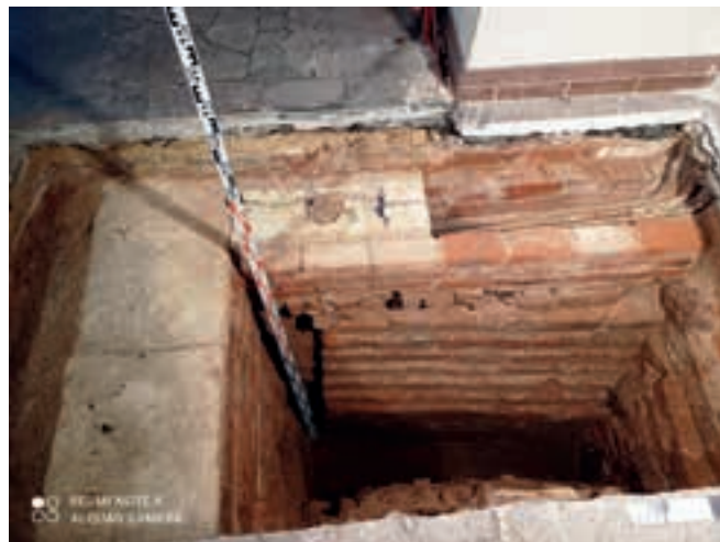
Fot. 10. Sondaż „A”. Lico północne fundamentu pod półkolumnę z początków XVIII wieku (konstrukcja „B”) oraz górne partie XIX-wiecznego kanału „grzewczego” (konstrukcja „A”). Ujęcie od N, z góry. Fot. P. Banaszak
