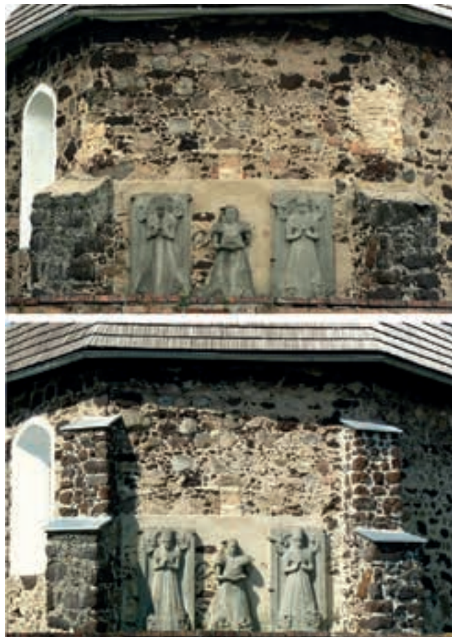
Fot. 12. Elewacja wschodnia przed i po rekonstrukcji przypór. Fot. D. Kwaśniak
