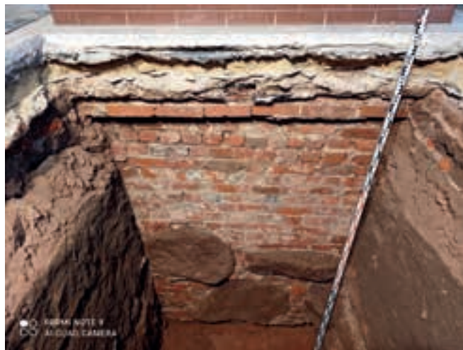
Fot. 19. Sondaż „C”. XVIII-wieczny fundament pod kolumnę (konstrukcja „C”). Ujęcie od N, z góry. Fot. P. Banaszak
