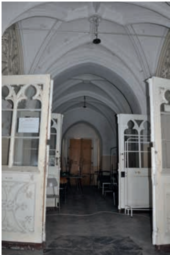
10. Wnętrze dawnego szpitala św. Doroty. Sień na osi wejścia głównego. Stan sprzed remontu w 2012 roku. Fot. B. Bieliniś-Kopec
