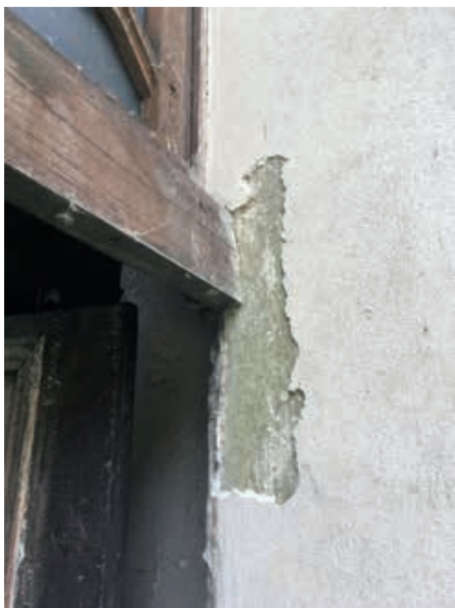
2. Odkrywanie w otworze drzwiowym elewacji północnej, widoczna oryginalna zielona warstwa malarska położona na elewację. Fot. P. Celecka
