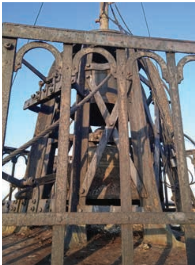
1. Konstrukcja zawieszenia dzwonów. Fot. M. Tureczek
