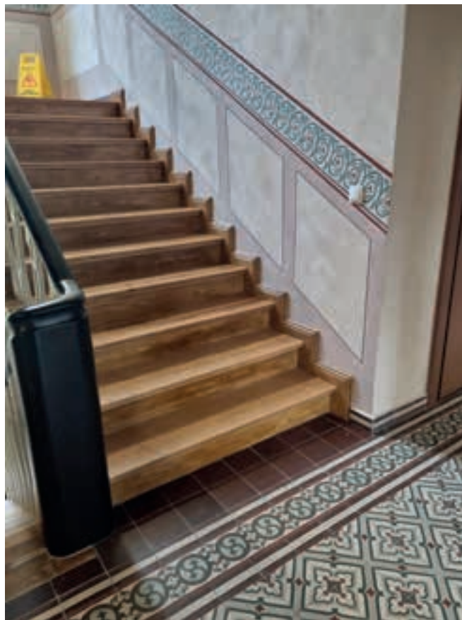
19. Klatka schodowa w dawnym Domu Marii po pracach konserwatorskich, stan z 2020 roku. Fot. B. Bieliniś-Kopec
