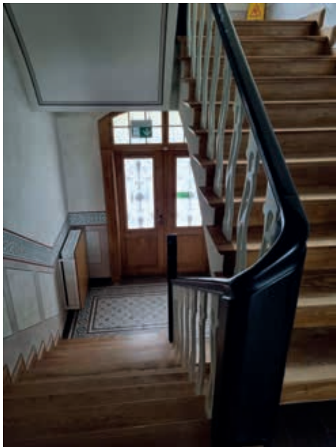
18. Klatka schodowa w dawnym Domu Marii po pracach konserwatorskich, stan z 2020 roku. Fot. B. Bieliniś-Kopec
