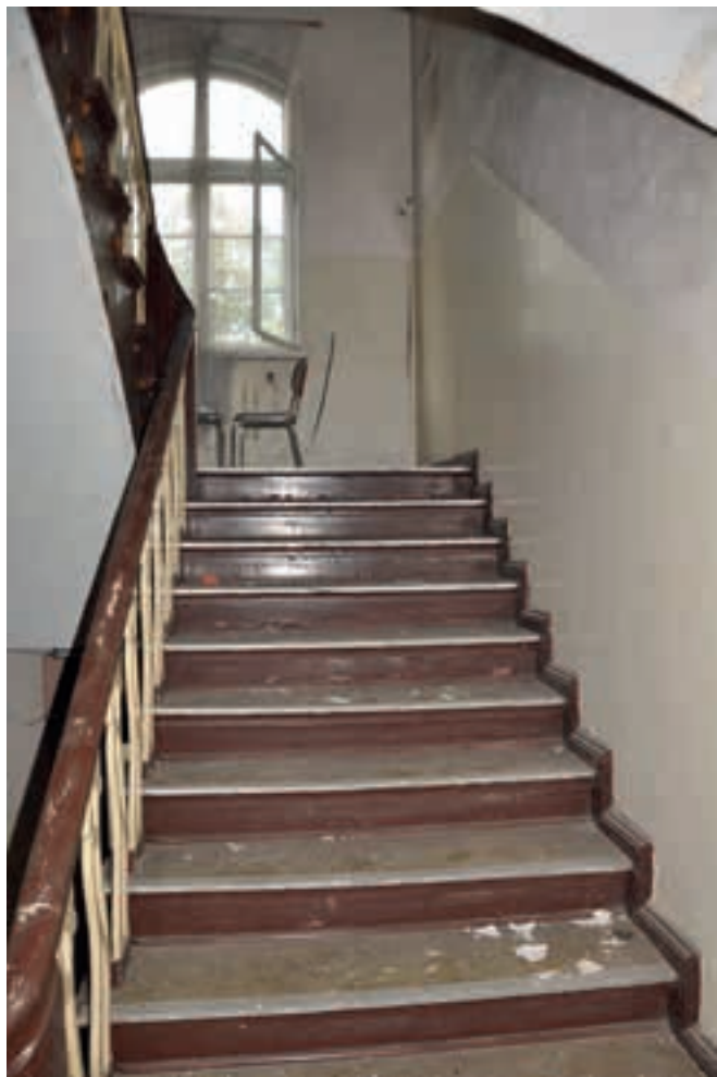
12. Wnętrze dawnego Domu Marii przed remontem w 2012 roku – klatka schodowa. Fot. B. Bielinis-Kopec
