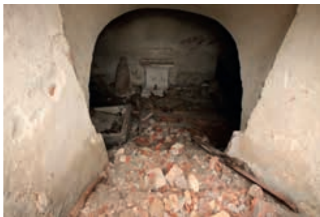
Ryc. 5. Widok zagruzowanych schodów i otynkowanego ołtarzyka, po lewej stronie rzeźba klęczącej kobiety. Fot. J. Gawroński
