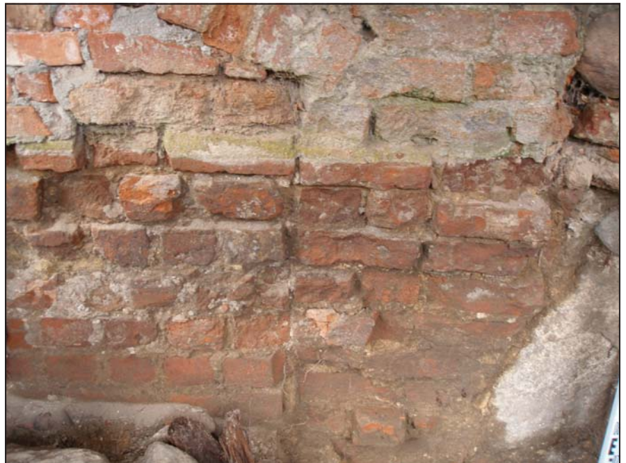
Ryc. 11. Krosno Odrzańskie, zamek, dziedziniec, wykop nr 2/2017, profil N wykopu, część wschodnia, partie górne, widoczne strzępiał oraz zamurowany otwór okienny w przyziemiu skrzydła N ściany południowej zamku. Fot. J. Lewczuk.
