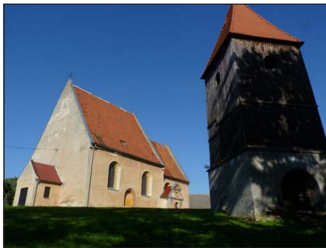
Fot. 11. Dzwonnica kościoła w Starej Koperni. Fot. D. Kwaśniak.
