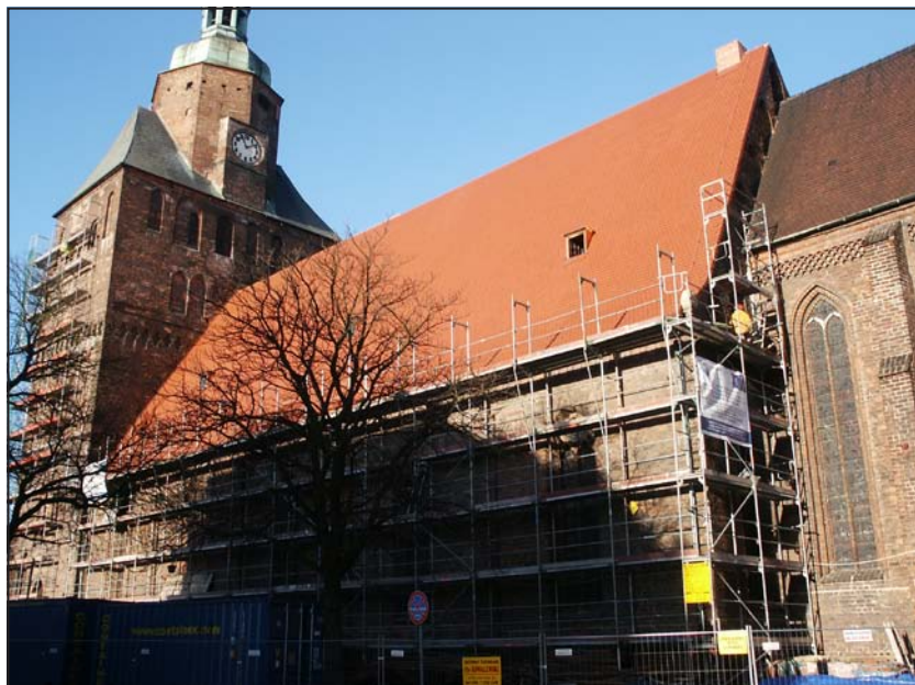
Ryc. 8. Remont katedry w latach 2006-2007 – widok od strony południowo-wschodniej, zdjęcie ze zbiorów Pracowni Miejskiego Konserwatora Zabytków w Gorzowie Wielkopolskim.
