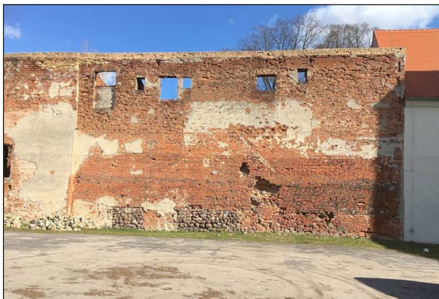
Fot. 5. Elewacja zachodnia skrzydła zachodniego, widok ogólny. W przyziemiu widoczny mur kamienny uznany za najstarszy, datowany na początek XIII wieku. Fot. P. Celecka.
