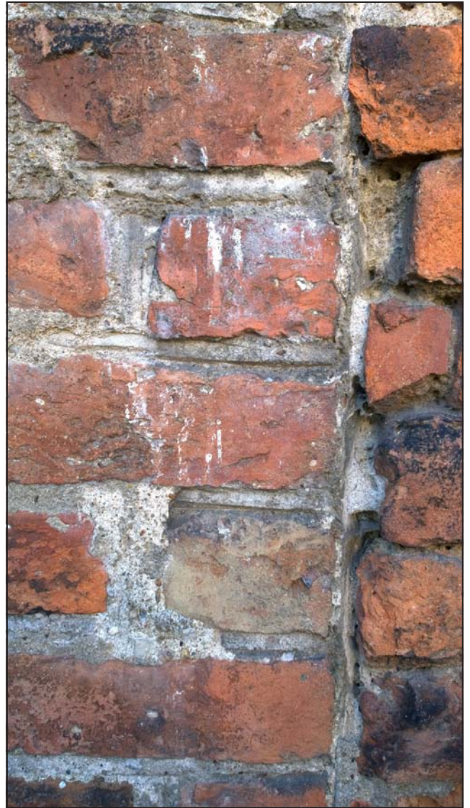
Ryc. 8. Szprotawa – fara. Zachowane na północnej ścianie kaplicy formowane gotyckie spoiny.
