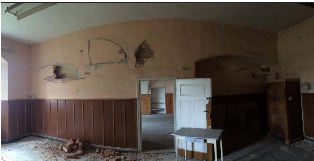
Ryc. 11. Miłaków, dwór, parter, trakt frontowy, pomieszczenie południowe, ściana międzytraktowa z układem wnęk renesansowych.
