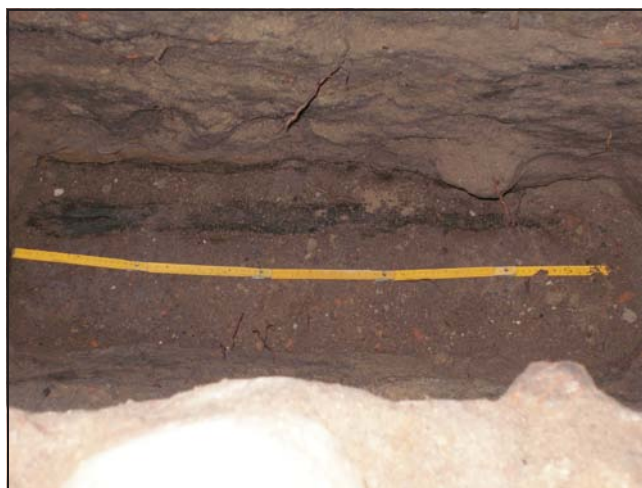
Ryc. 4. Krosno Odrzańskie, zamek, dziedziniec, wykop nr 1/2017, gł. około 260 cm, dno wykopu z uchwyconym „in situ” drewnianym elementem stabilizującym grząskie piaszczysto-gliniaste podłoże, średnica drewna od 5-6 w części N do 8-10 cm w części S, dł. około 100 cm, ujęcie z góry od strony E. Fot. J. Lewczuk.
