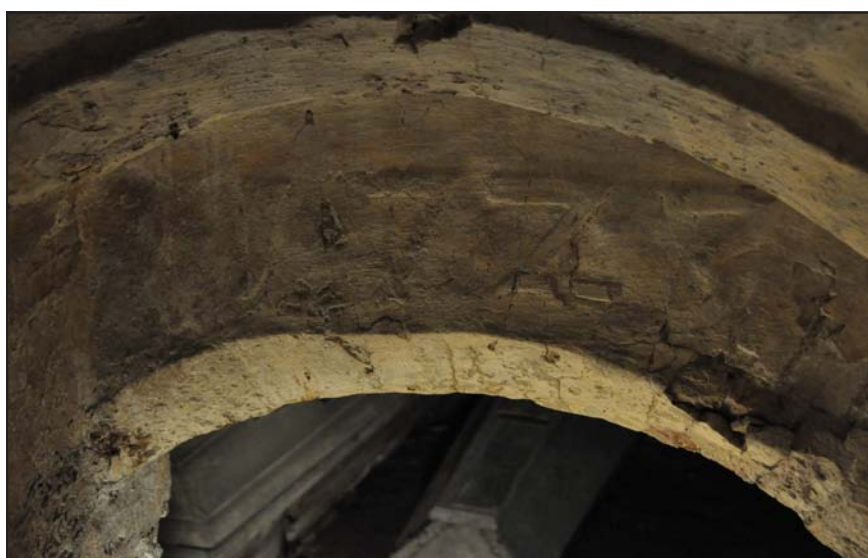
Ryc. 18. Jabłonec. Data 1723 nad wejściem do krypty. Fot. J. Wrzesiński.
