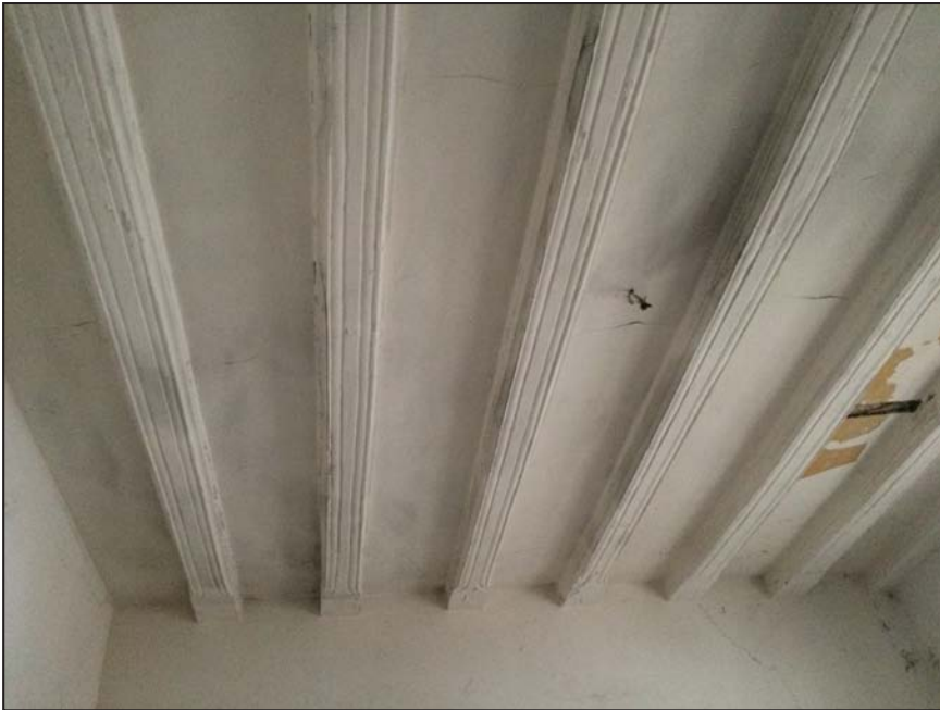
Ryc. 12. Miłaków, dwór, parter, trakt tylni, pasmo południowe, sala, renesansowy strop belkowy.
