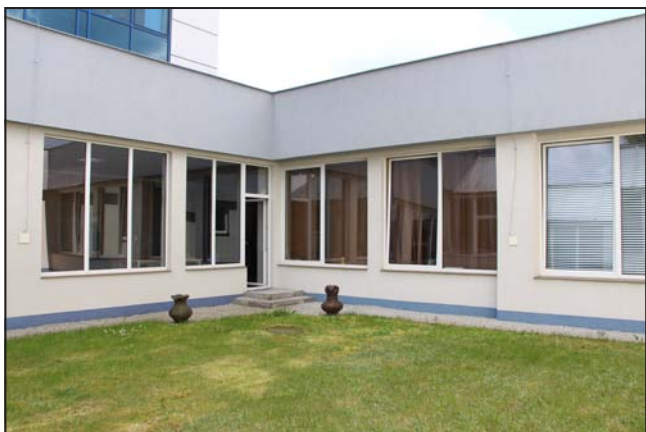
Il. 12. Pozostałości po rzeźbach z dawnej fontanny autorstwa Marka Przeclawskiego na patio budynku głównego zakładu „Novita”, marzec 2017 r.
