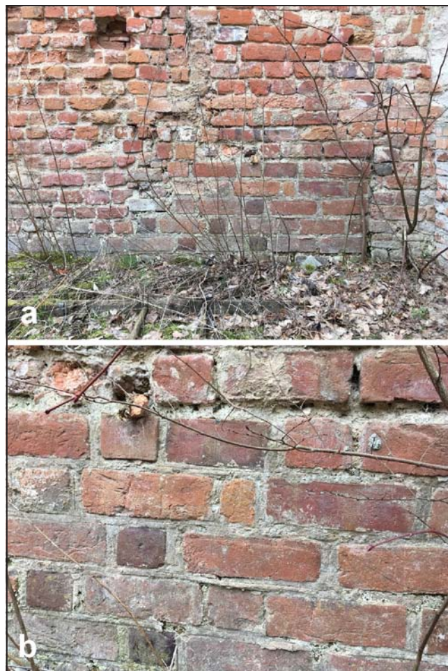
Fot. 3. Ściana obwodowa skrzydła północnego, fragment muru widzianyego z górnego poziomu ryzalitu, wtykę ceglany z podciętą, profilowaną fugą, wymiary cegieł: 29-30 x 13 x 9, 1510, IV faza chronologiczna. Fot. P. Celecka.
