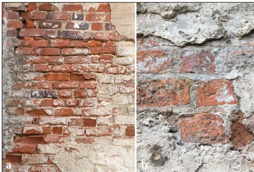
Fot. 4. Elewacja północna skrzydła północnego
