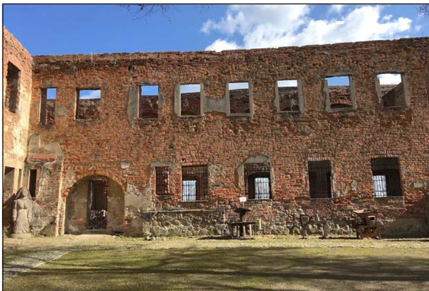
Fot. 6. Elewacja zachodnia skrzydła wschodniego, część północna, z bramą, w której odkryto nawarstwienia przedstawione na fotografii nr 7. Fot. P. Celecka.
