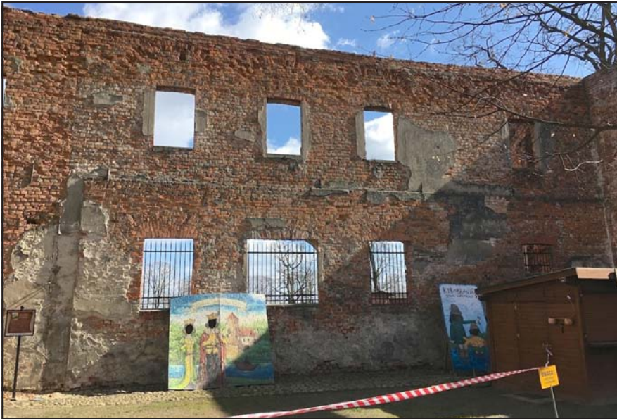
Fot. 8. Elewacja zachodnia skrzydła wschodniego, część południowa, wyraźnie widać, że wybudowana w innym czasie niż część północna (granica styku obu wybudowań widoczna po lewej stronie). Fot. P. Celecka.
