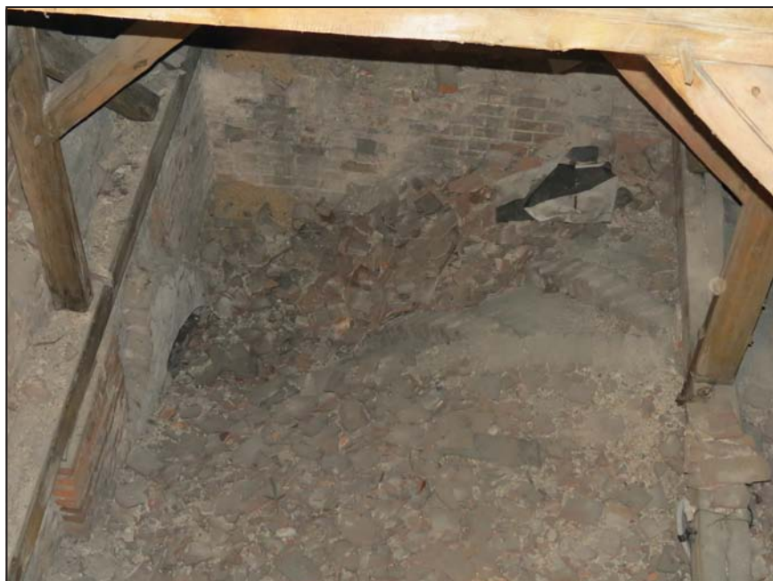
Ryc. 9. Szprotawa – fara. Sklepienie kaplicy widoczne od strony poddasza.
