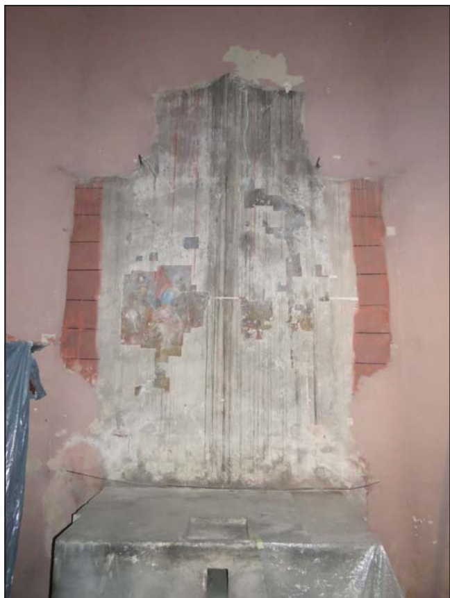
Ryc. 15. Szprotawa – fara. Ściana północna kaplicy po demontażu ołtarza i wykonaniu odkrywek stratygraficznych.
