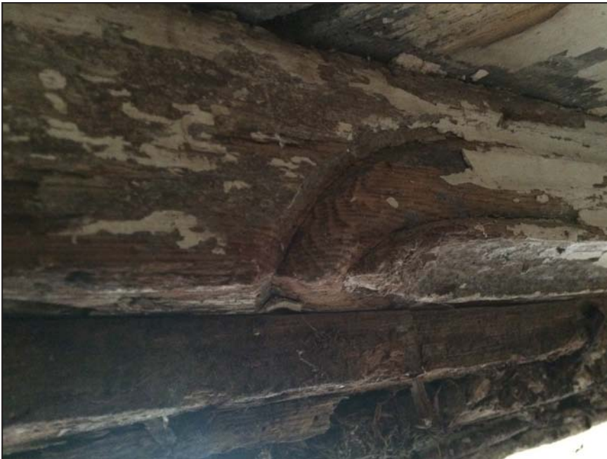
Ryc. 13. Miłaków, dwór, parter, trakt frontowy, pomieszczenie południowe, detal belki stropowej.
