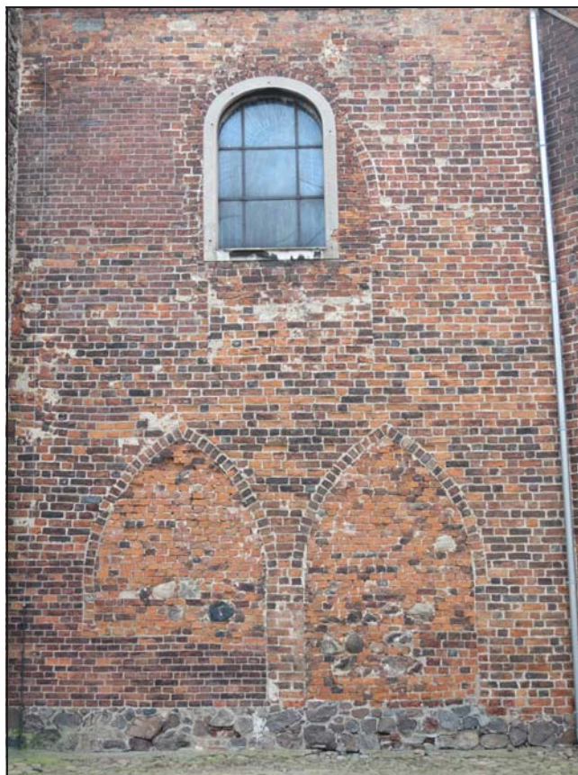
Ryc. 6. Szprotawa – fara. Widok północnej ściany kaplicy.
