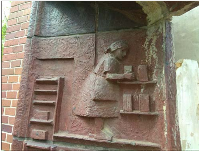
Il. 17. Widok fragmentu portalu. Fot. P. Pachut.
