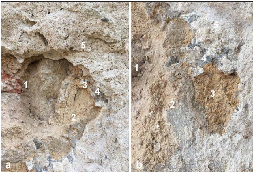
Fot. 9. Relikty wystroju tynkarskiego na pokazanej na fotografii nr 8 styku dwóch faz wybudowania skrzydła wschodniego, stwierdzone na murze części północnej 1 – mur ceglany z kamiennymi elementami, murowany zaprawą wapienno-piaskową o ciepłym beżowym odcieniu, prawdopodobnie około 1700, VIII faza chronologiczna; 2 – tynk podkładowy o nieco jaśniejszym, beżowym odcieniu, jak wyżej; 3 – ugrowy tynk wapienno-piaskowy wykończeniowy barwiony w masie, jak wyżej; 4 – warstwa malarska, ciemnoszara lub biała zniszczona długotrwałą ekspozycją, jak wyżej (lub późniejsze przemalowanie?); 5 – zaprawa wapienno-piaskowa modyfikowana hydraulicznie, koniec XIX w, XIII faza. Fot. P. Celecka.
