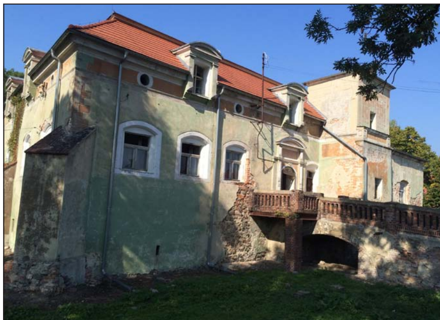
Ryc. 6. Miłaków, dwór, widok ogólny od południowego-wschodu.
