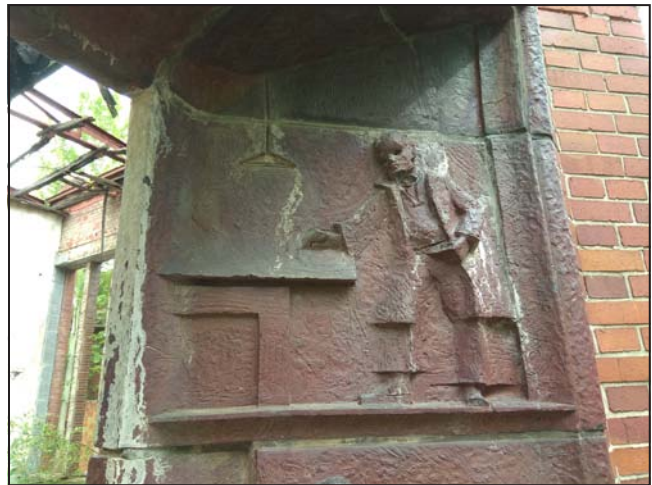
Il. 18. Widok fragmentu portalu. Fot. P. Pachut.
