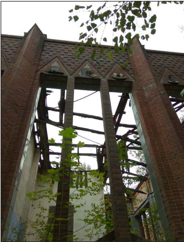
Il. 5. Widok elementów konstrukcyjnych. Fot. P. Pachut.
