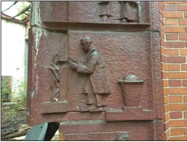
Il. 19. Widok fragmentu portalu. Fot. P. Pachut.
