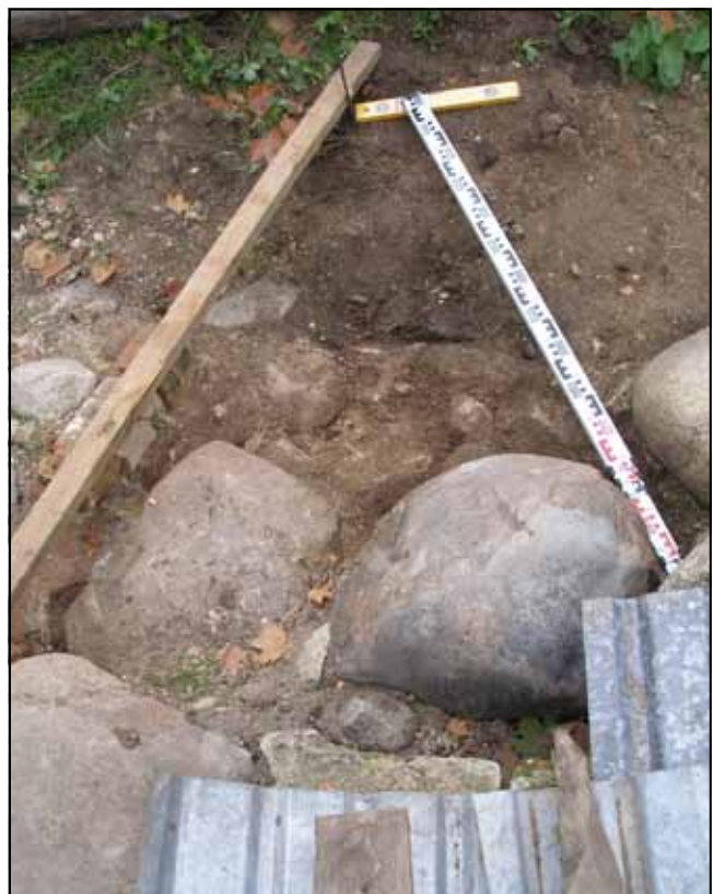
Ryc. 24. Koźuchów, ul. Obywatelska, dz. nr 491/2, basteja, wykop nr 5, widok od strony północnej na relikty (zarys rekonstruowany) otworu strzelniczego nr V. Fot. J. Lewczuk.
