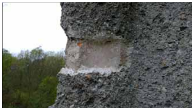
Ryc. 22. Odkrywka nr 18: mur ceglany (kształtka); rapowany tynk cementowo-wapienny z gruboziarnistym żwirowym wypełniaczem.
