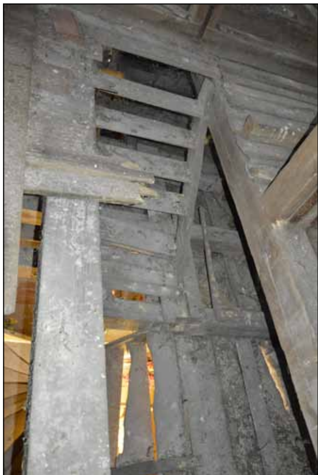
Fot. 23. Schody i strop w Radowie. Fot. autor.
