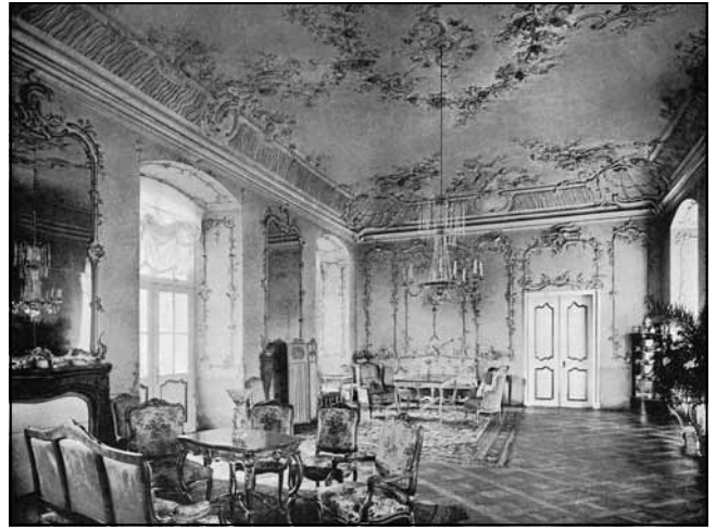
Il. 15. Sala balowa (kryształowa) na piętrze w skrzydle południowym pałacu w Zaborze z wystrojem rokokowym. Stan z ok. 1913 r. Fot. Heinrich Goetz. Reprodukacja: RICHARD KONWIARZ, Alt-Schlesien: Architektur, Raumkunst, Kunstgewerbe , Frankfurt a. M. 1979 [reprint wydania Stuttgart 1913], s. 203.
