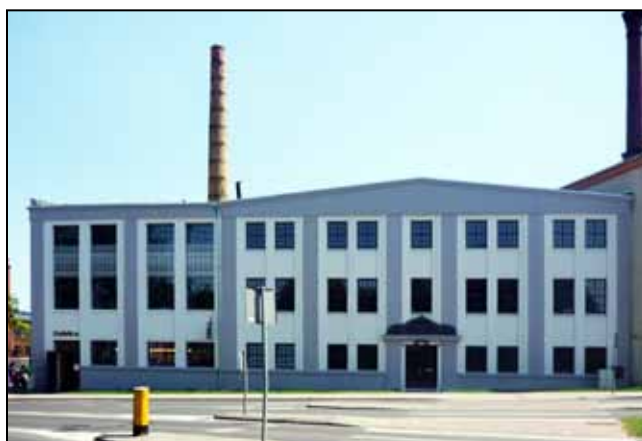
Il. 17. Fasada fabryki winiaków Heinricha Raetscha przy zbiegu ulic Sulechowskiej i Bolesława Chrobrego (rozbudowa z 1921 roku). Fot. Magdalena Kozik.
