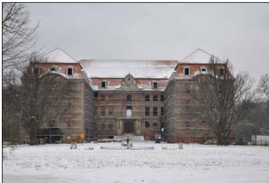
Fot. 4. Pałac w Brodach po remoncie dachu w 2013 r. Fot. ze zbiorów WUOZ w Zielonej Górze.
