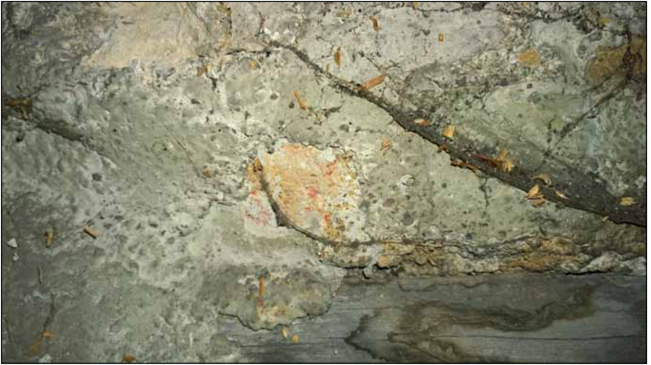
Ryc. 24. Odkrywka nr 20: mur ceglany; narzut wapienno-piaskowy w kolorze ugrowo-beżowym pobielony wapnem.
