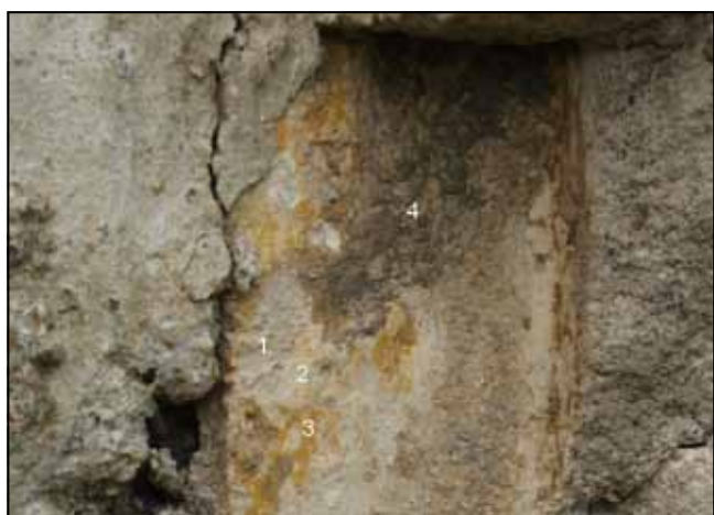
Fot. 2. Odkrywka na elewacji zachodniej pałacu, widoczny fragment opaski okiennej z II połowy XVII wieku (1 – zaprawa wapienno-piaskowa, 2 – pobiała wapienna, 3 – ugrowa warstwa malarska na spoiwie wapiennym, 4 – zabrudzenia powierzchniowe).
