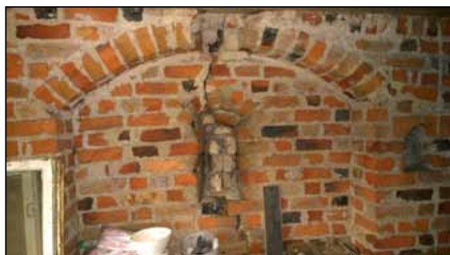
Ryc. 13. Olszyniec – dwór. Pierwsze piętro – zamurwane okno szczelinowe, stan w 2014 r.
