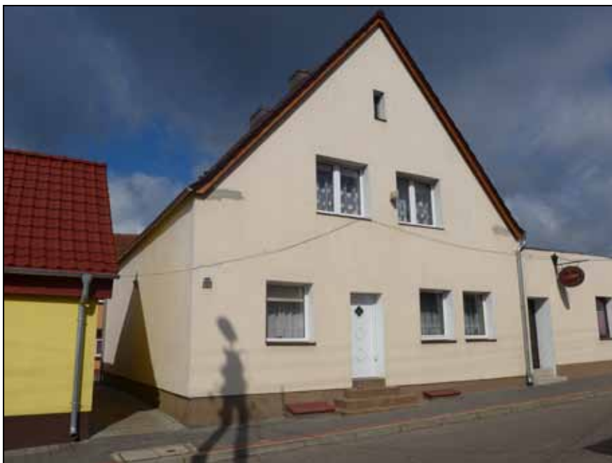
Ryc. 5. Były dom Brunona Pade przy dawnej ul. Gorzowskiej 13 (niem. Landsberger Straße), zbudowany na miejscu synagogi 2016 r.
