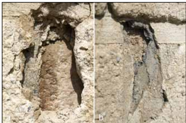
Fot. 1. Odkrywki na elewacji zachodniej, widoczne fragmenty bardzo źle zachowanej dekoracji sgraffitowej z końca XVI wieku.
