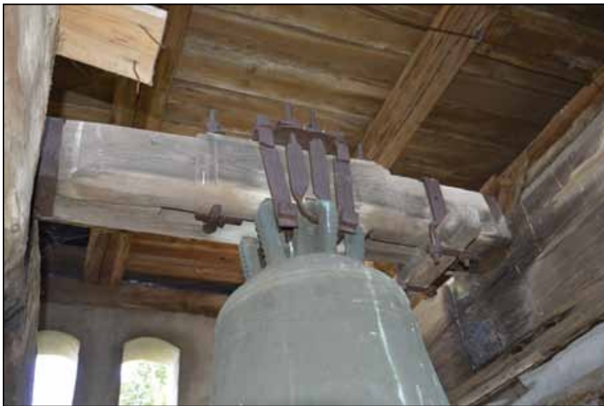
Fot. 2. Jarzmo oraz korona dzwonu w Radówku. Fot. autor.
