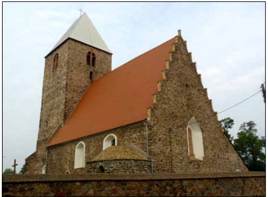
Il. 7. Kościół w Witkowie, widok od południowego-wschodu. Fot. autor.
