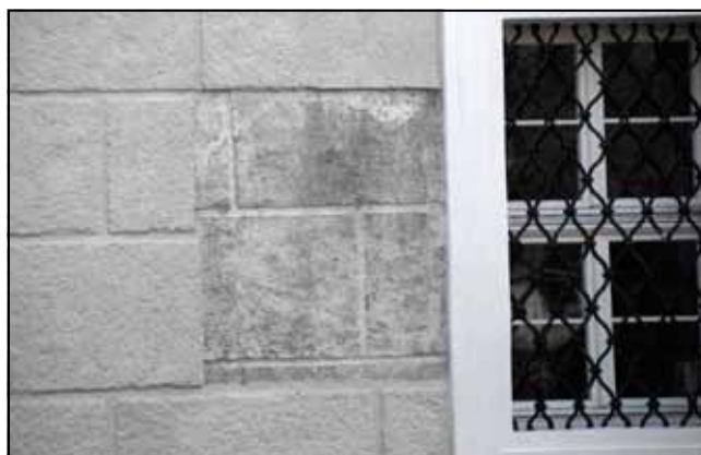
Il. 6. Odkrywka na elewacji frontowej (część zachodnia) skrzydła parawanowego pałacu w Zaborze. Stan z 2015 r. Fot. K. Adamek-Puj szo.
