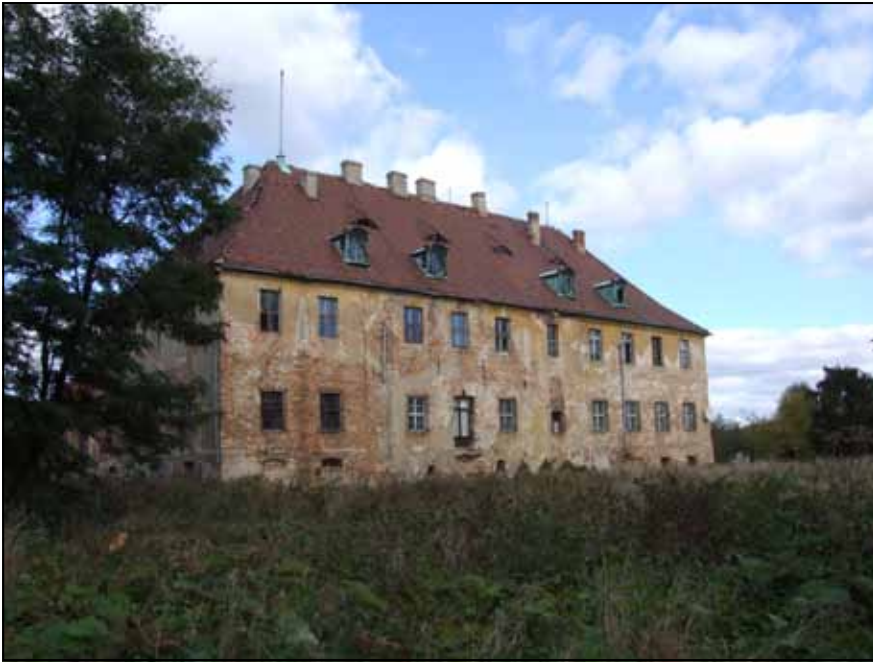
Fot. 2. Elewacja ogrodowa pałacu w Bieczu – stan obecny. Fot. ze zbiorów WUOZ w Zielonej Górze.
