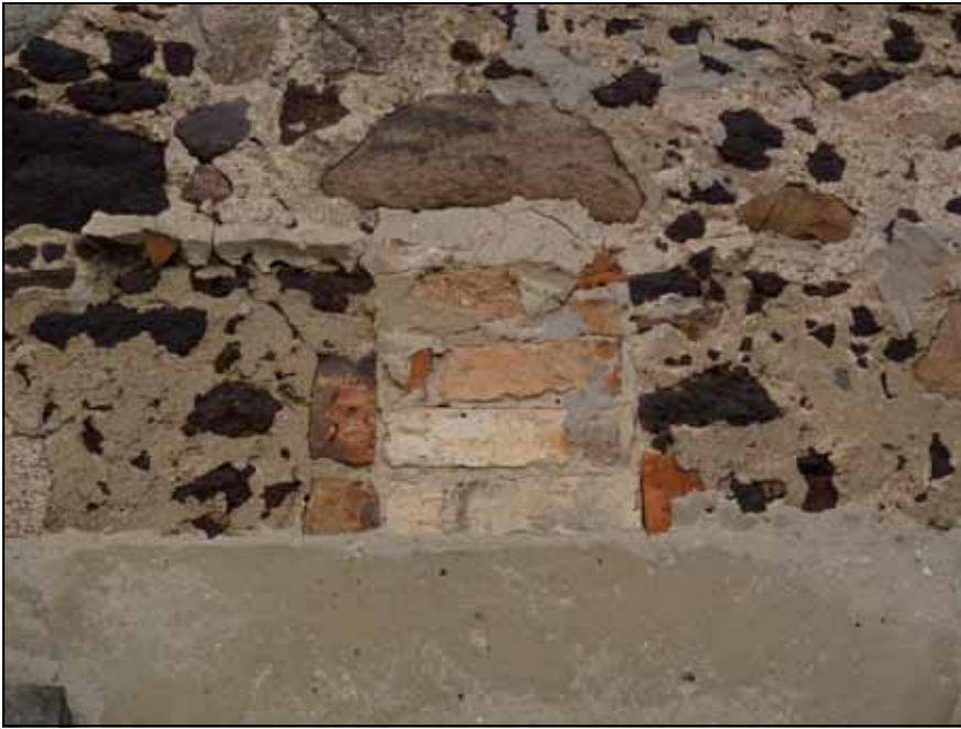
Il. 6. Kościół w Studziencu, zamurowane okno prezbiterium. Fot. autor.
