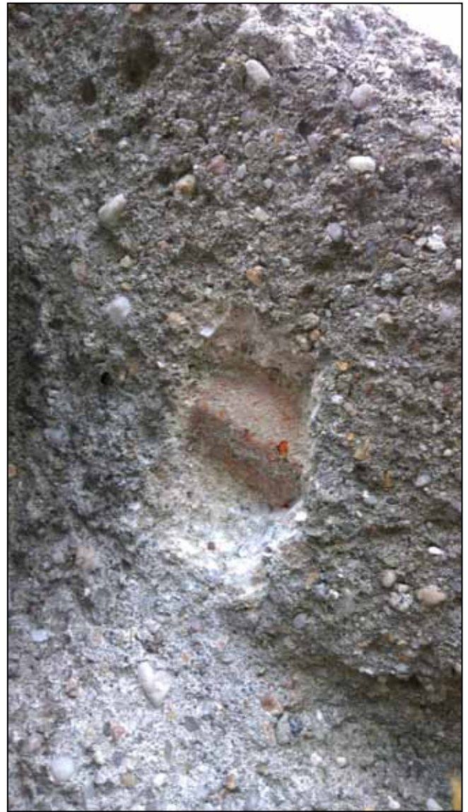
Ryc. 19. Odkrywka nr 1: mur ceglany (kształtka); rapowany tynk cementowo-wapienny z gruboziarnistym żwirowym wypełniaczem.
