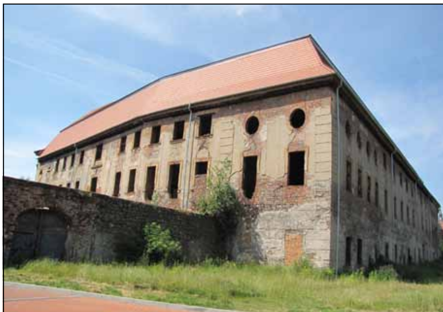
Fot. 11. Pałac w Żarach po remoncie dachu w 2013 r. Fot. ze zbiorów WUOZ w Zielonej Górze.
