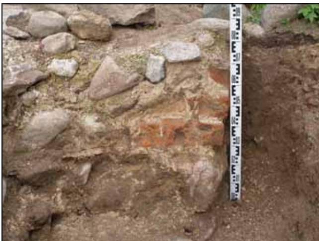
Ryc. 20. Koźuchów, ul. Obywatelska, dz. nr 491/2, basteja, wykop nr 4, widok na wykop i rozkuty otwór strzelniczy nr IV od strony południowej, widoczne relikty ceglanego policzka północnego. Fot. J. Lewczuk.
