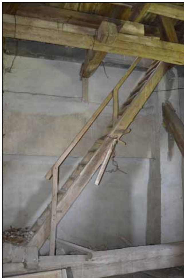
Fot. 24. Schody i konstrukcje stropowe w Radówku. Fot. autor.
