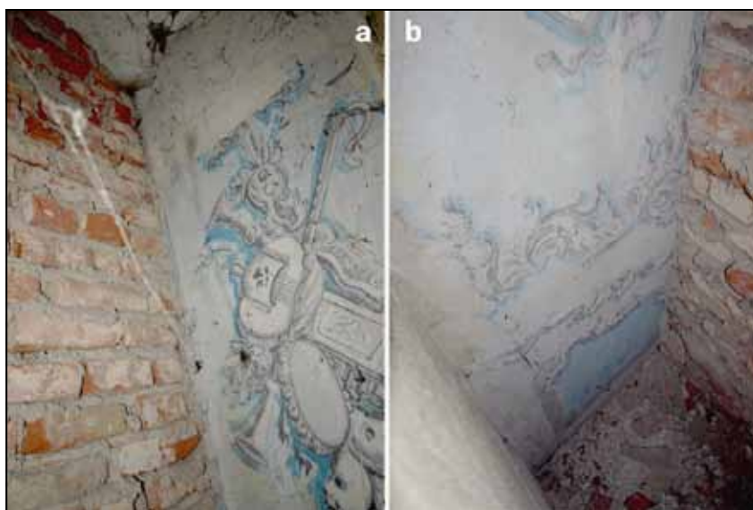
Fot. 5. Polichromia zachowana w zamurowaniu wnęki okiennej w pomieszczeniu na parterze południowo-wschodniego narożnika pałacu.
