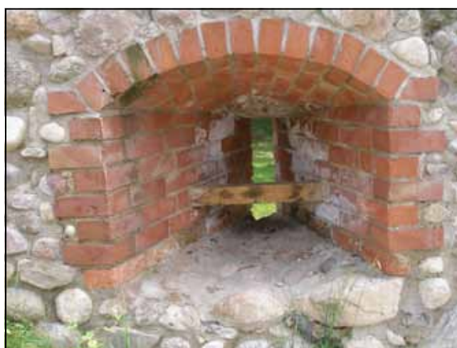
Ryc. 32. Koźuchów, ul. Obywatelska, dz. nr 491/2, basteja, widok z wnętrza obiektu na zrekonstruowany otwór strzelniczy nr I, czerwiec 2016 roku. Fot. J. Lewczuk.
