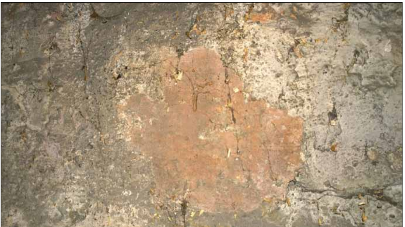
Ryc. 25. Odkrywka nr 22: mur ceglany; narzut wapienno-piaskowy w kolorze ugrowo-beżowym.
