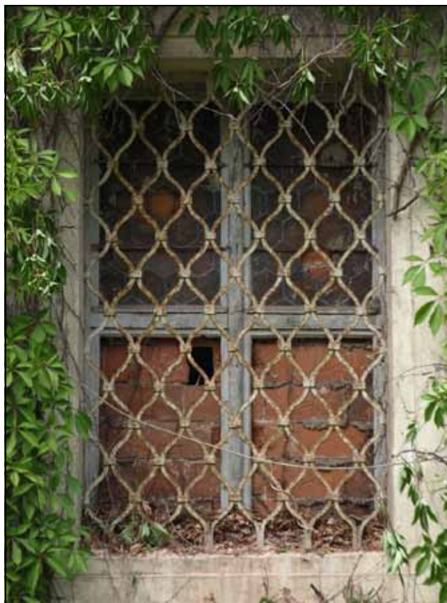
Fot. 3. Historyczna stolarka okienna zamurowanego otworu okiennego na elewacji południowej z zachowanym oryginalnym szkleniem witrażowym.
