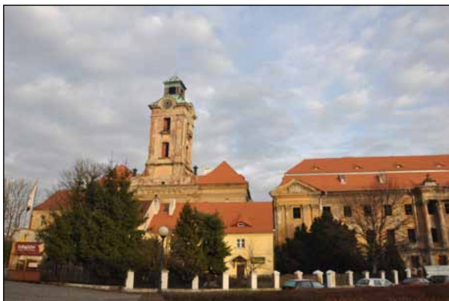
Fot. 12. Zamek i pałac w Żarach, stan obecny. Fot. ze zbiorów WUOZ w Zielonej Górze.
