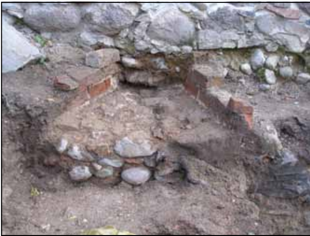
Ryc. 9. Kozuchów, ul. Obywatelska, dz. nr 491/2, basteja, wykop nr 1b, widok od strony zachodniej na otwór strzelniczy nr I; widoczne – podkolanek (na pierwszym planie), wykładany eratykami parapet, fragmenty ceglanych policzków – północnego i południowego, zablokowany otwór strzelniczy w ścianie wschodniej bastei. Fot. J. Lewczuk.
