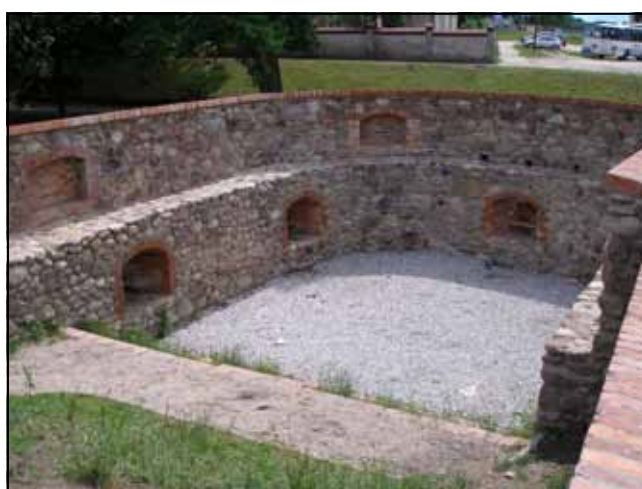
Ryc. 31. Koźuchów, ul. Obywatelska, dz. nr 491/2, basteja, widok na wnętrze obiektu od strony północnej, czerwiec 2016 roku. Fot. J. Lewczuk.
