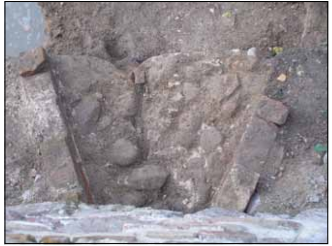
Ryc. 10. Kozuchów, ul. Obywatelska, dz. nr 491/2, basteja, wykop nr 1b, widok z korony muru bastei na otwór strzelniczy nr I; widoczne – wykładany eratykami parapet oraz fragmenty ceglanych policzków – północnego i południowego. Fot. J. Lewczuk.
