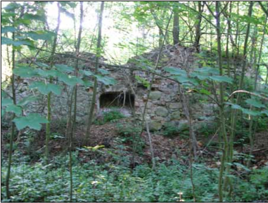
Fot. 6. Relikty pałacu w Gębicach, stan z 2012 r. Fot. ze zbiorów WUOZ w Zielonej Górze.
