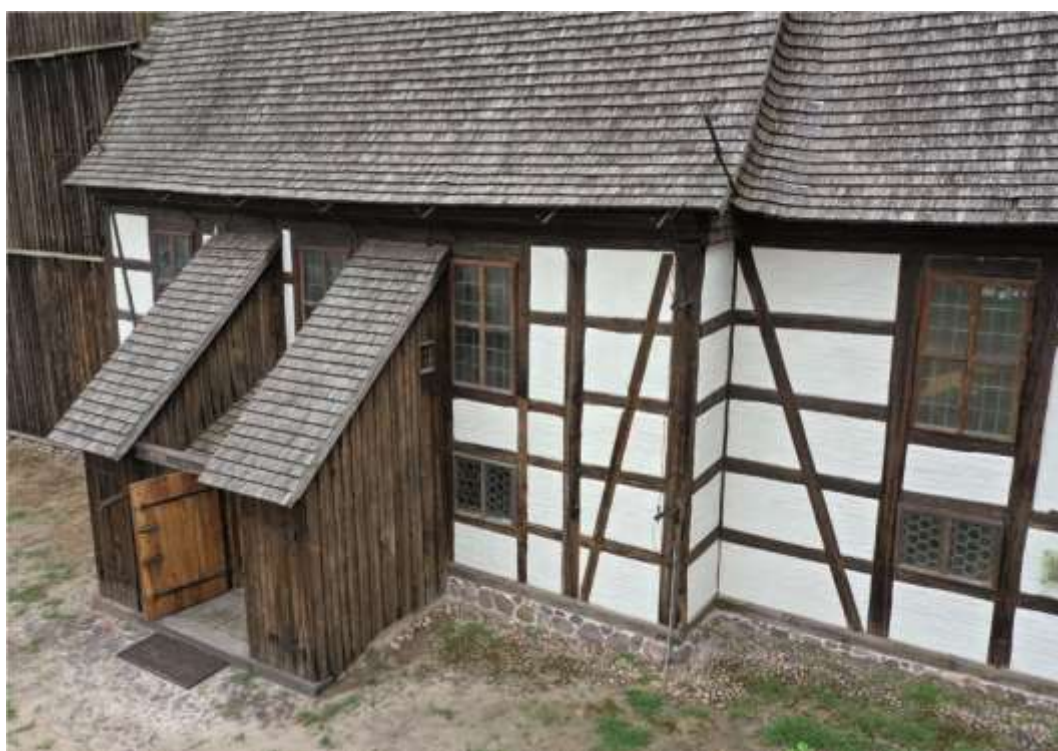
Klępsk. Południowa elewacja nawy i prezbiterium kościoła, zbudowana w konstrukcji szkieletowej z ceglanym wypełnieniem. Fot. A. Hardt, 2023
