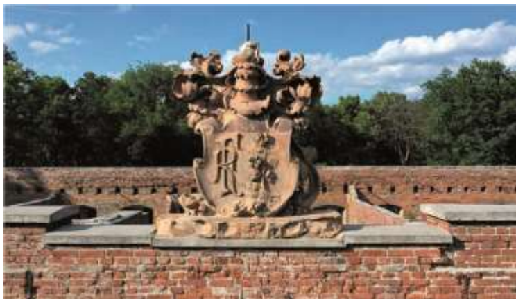
Zielona Góra-Zatonie, pałac, ob. trwała ruina – tarcza z inicjałami Rudolfa Friedenthala. Fot. A. Hardt
