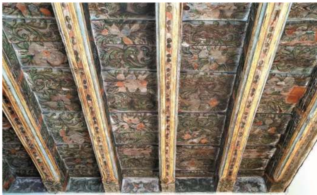
Strop plebanii w Brzeźnicy
