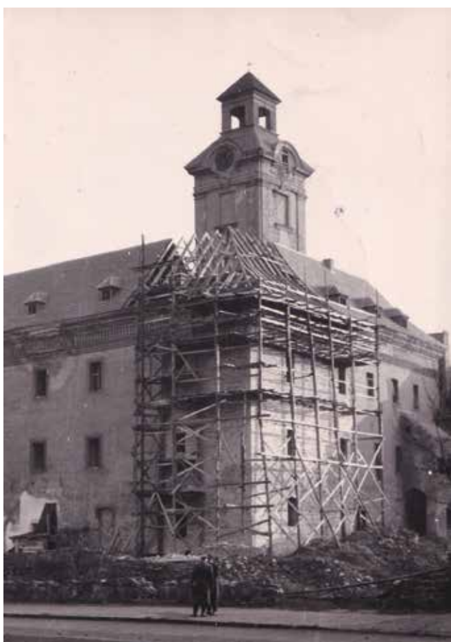
Żary, zamek w czasie rekonstrukcji półn.-zach. narożnika, 1964 r., fot. St. Kowalski
