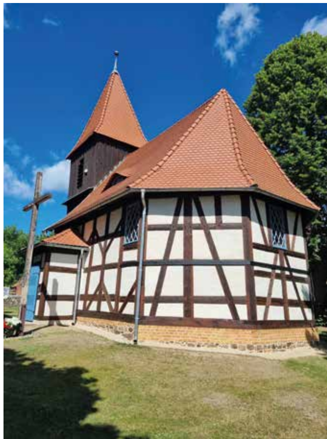
Fot. 171. Kościół w Lubiechni Małej
