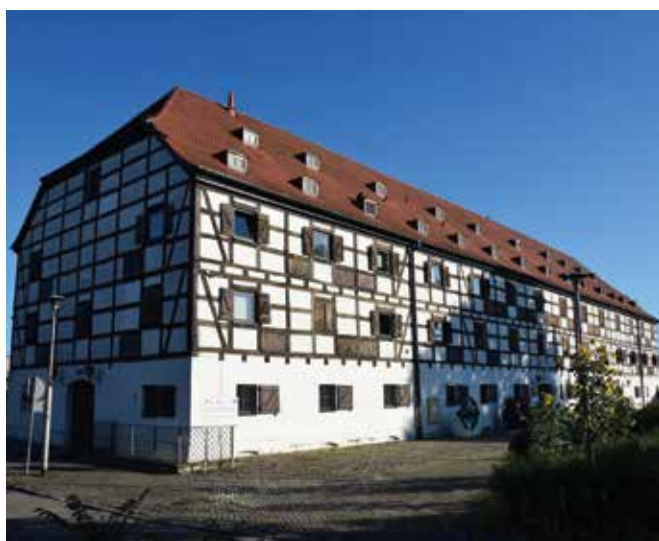
Gorzów Wielkopolski, ul. Fabryczna 1, spichlerz, 2023 r., fot. A. Dębski
