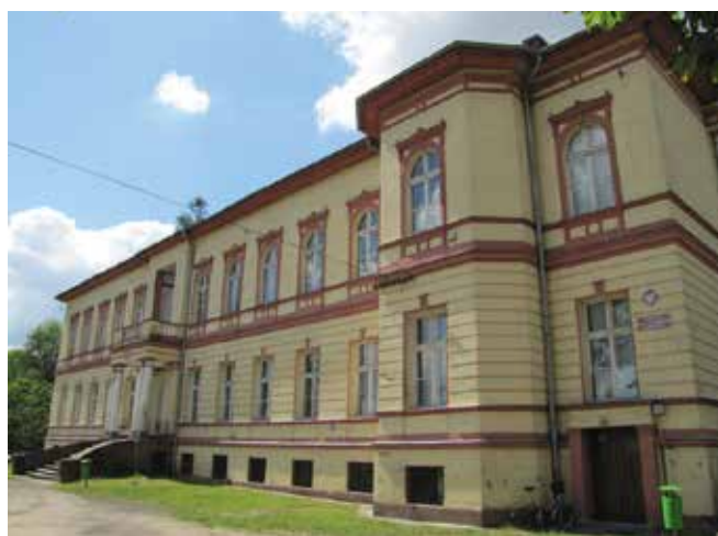
Fot. 138. Pałac w Mostkach
