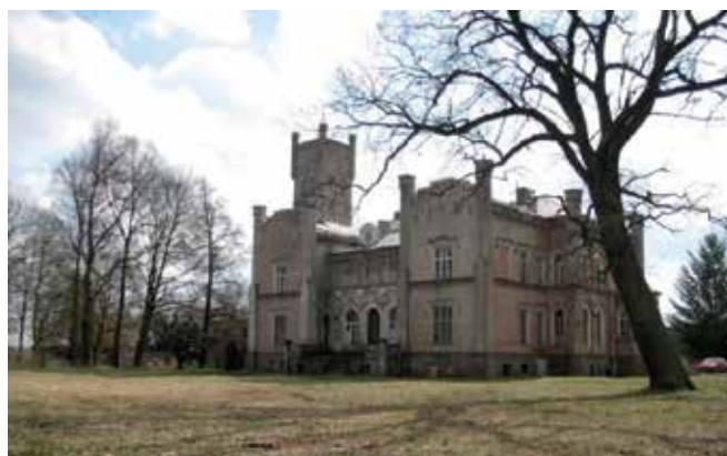
Fot. 131. Pałac w Luboszycach
