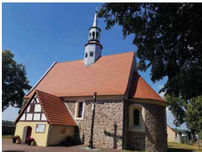
Fot. 1. Kościół pw. św. Wincentego w Starym Żaganiu
