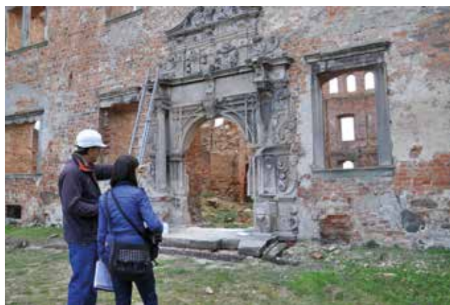
Siedlisko, zamek – prace konserwatorskie przy portalu
