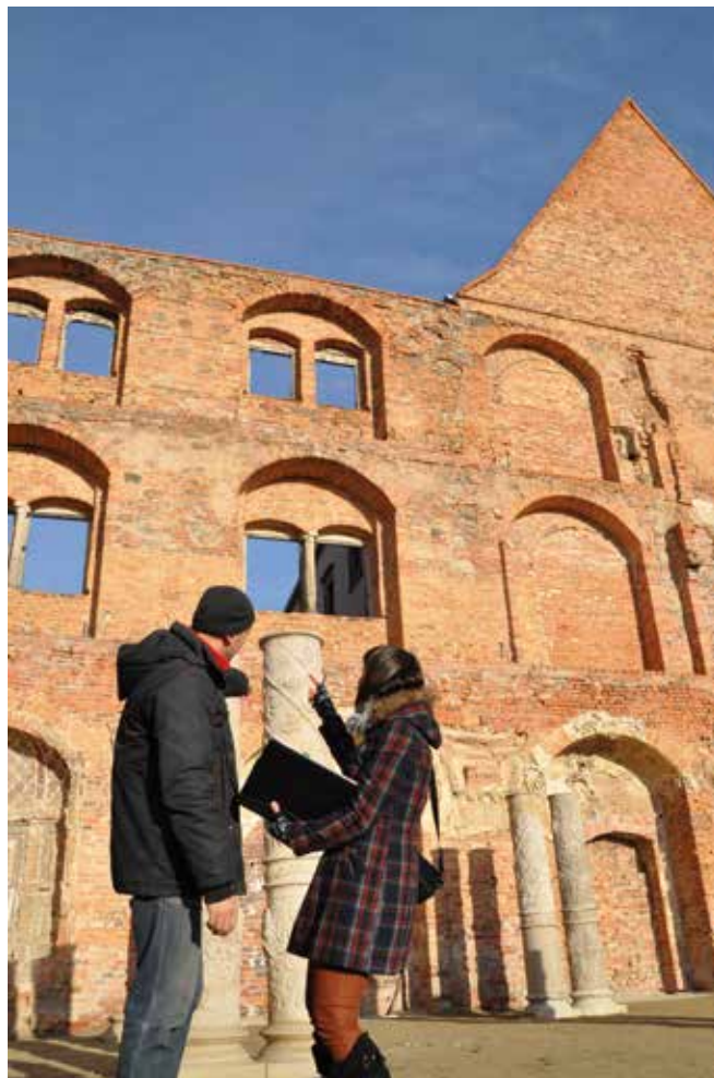
Siedlisko, zamek – sala kolumnowa
