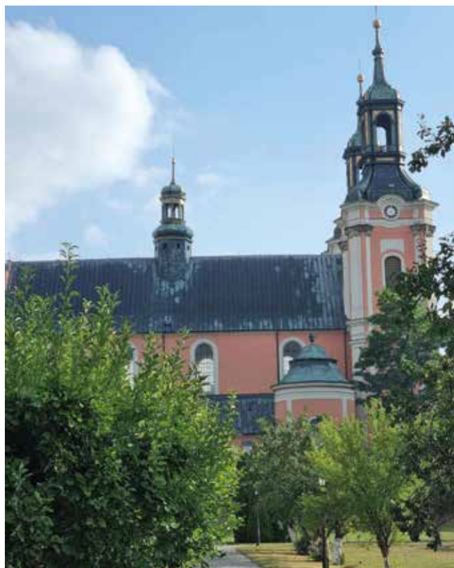
Fot. 21. Kościół pw. Wniebowzięcia NMP i św. Marcina z Tours
