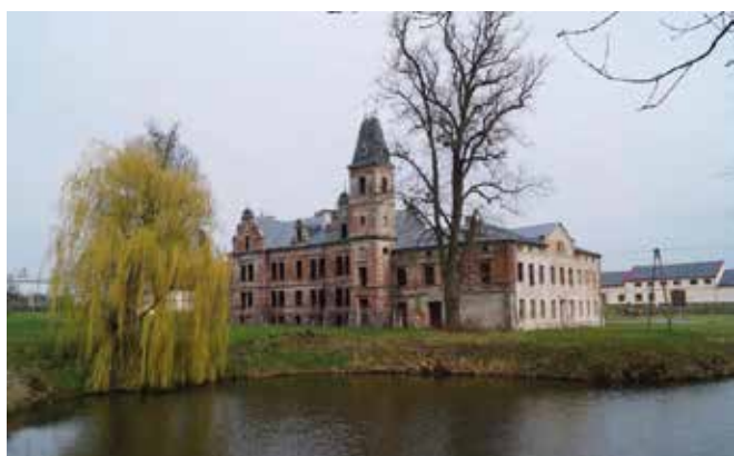
Fot. 134. Pałac w Stanowicach
