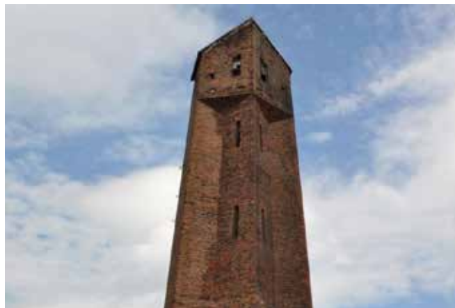
Fot. 160. Wieża wodna w Jankowej Żagańskiej
