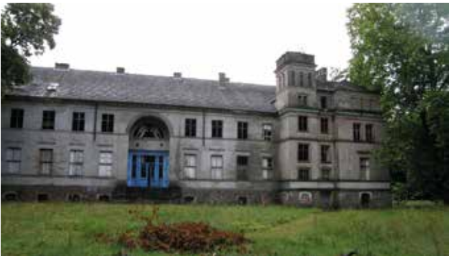
Fot. 110. Pałac w Sosnach
