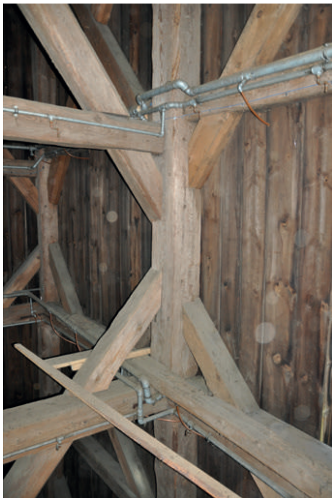
10. Kępno, kościół poewangelicki. Wieża. Widoczne rygle pełniące jednocześnie funkcję oczepu dla dolnej części konstrukcji ściany i oczepu dla środkowej. Fot. U. Schaaf, 2022
