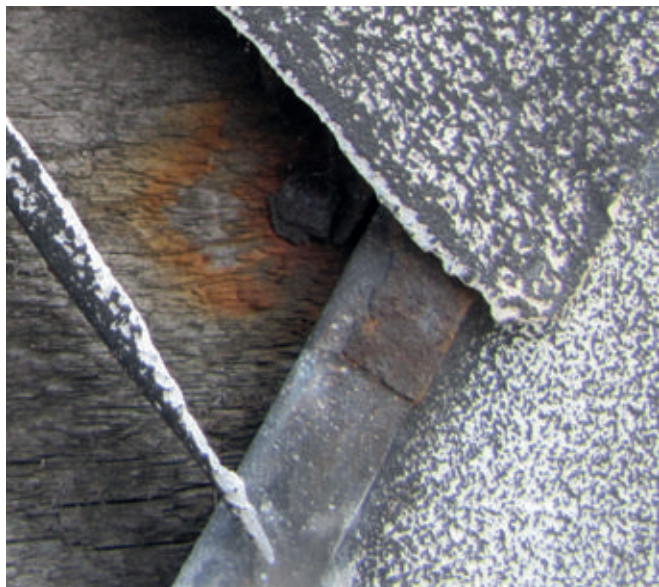
12. Korozja i zniszczenie połączenia żelaznej żabki z blachą cynkową. Wieża dawnego kościoła ewangelickiego w Babimoście (pow. zielonogórski), 2024
