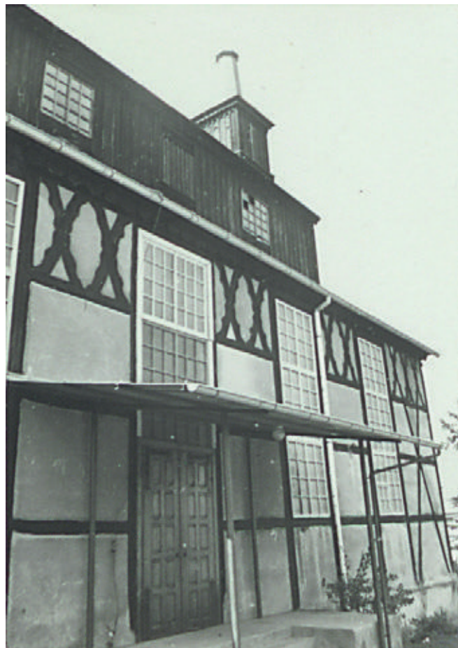
8. Fotografia z białej karty obiektu z 1997 roku autorstwa B. Bieliniś-Kopeć. Górną pozorną część oryginalnych drzwi zastąpiono szkleniem o podziałach nawiązujących do modułu powyżej
