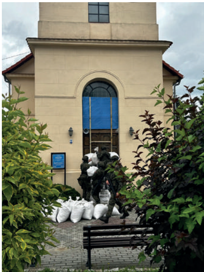
3. Zabezpieczanie stolarki drzwiowej kościoła
