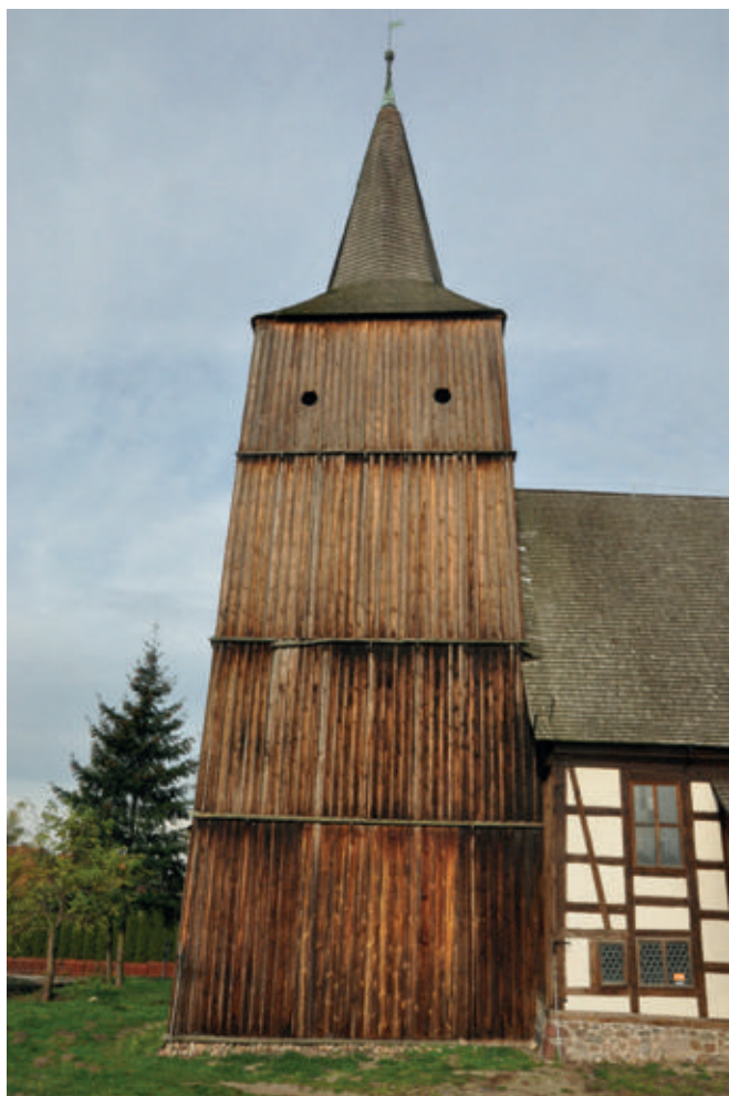
2. Klepsk, kościół poewangelicki. Wieża zachodnia od strony południowej. Fot. U. Schaaf, 2022
