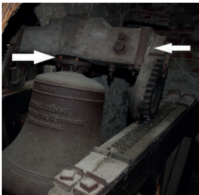
4. Jarzmo na prowadnicach zębatkowych firmy Bochumer Verein, Zielona Góra-Zatonie. Strzałkami zaznaczono uszkodzenia mocowania dzwonu oraz podstawy jarzma, co wywołało odchylenie dzwonu od pozycji pionowej podczas spoczynku, ponadto podczas dzwonięcia następuje zderzenie dzwonu z jarzmem. W trakcie oględzin dzwonu w 2023 roku zalecono nieużywanie dzwonu oraz konserwację jarzma. Jest to interesujący przykład rozwiązania technicznego napędu dzwonów
