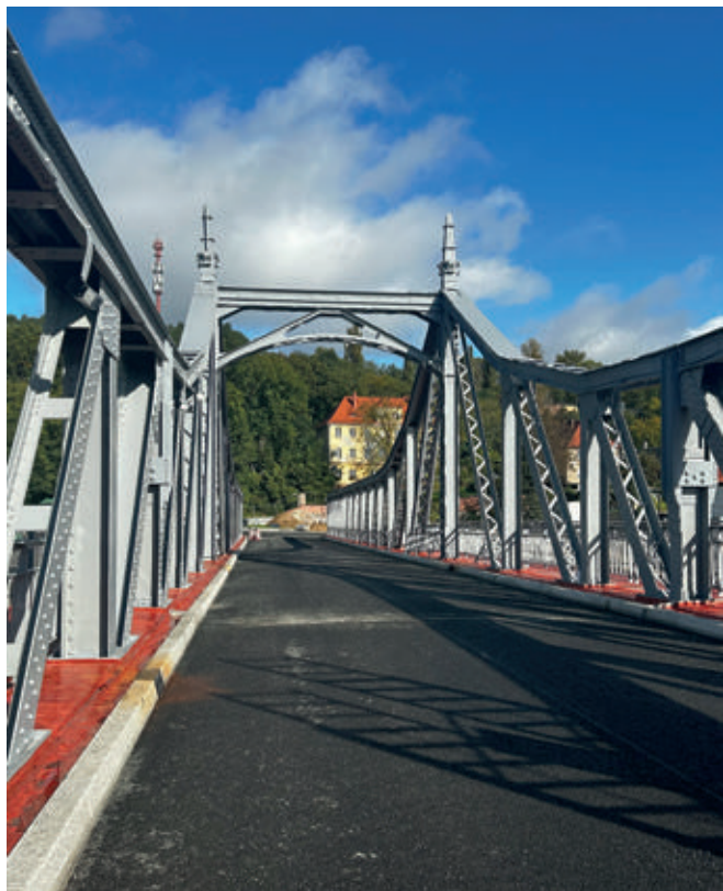
12. Most Odrzański w trakcie obecnego remontu, wrzesień 2024
