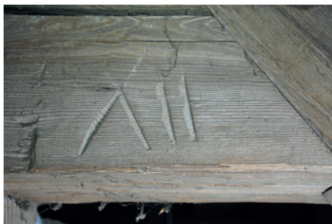
14. Kępno, kościół poewangelicki. Wieża. Znak montażowy. Fot. U. Schaaf, 2022
