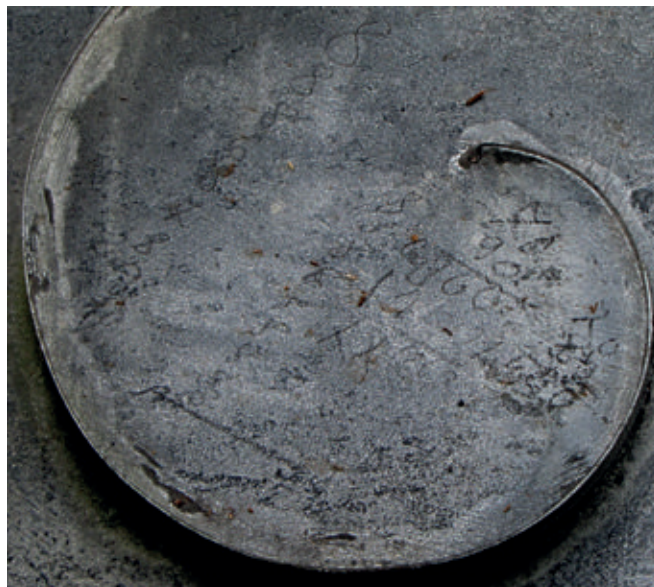
14. Inskrypcja (adnotacje kalkulacyjne) na splywie wolutowym wykonanym w blasze opierzenia fasady wystawki dachowej pałacu w Trzebiechowie, 2024
