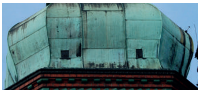
23. Otwory na pomosty robocze w połaci hełmu tzw. willi Sallet przy ul. Łużyckiej 29 w Świebodzinie, 2018
