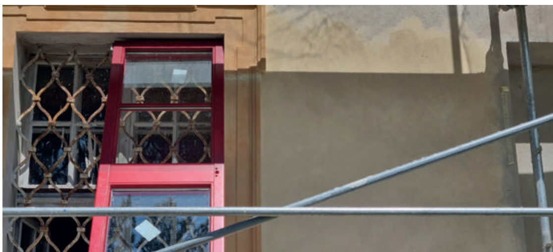
12–14. Próby kolorystyczne elewacji, stolarki okiennej i odtworzonych obramień okiennych
