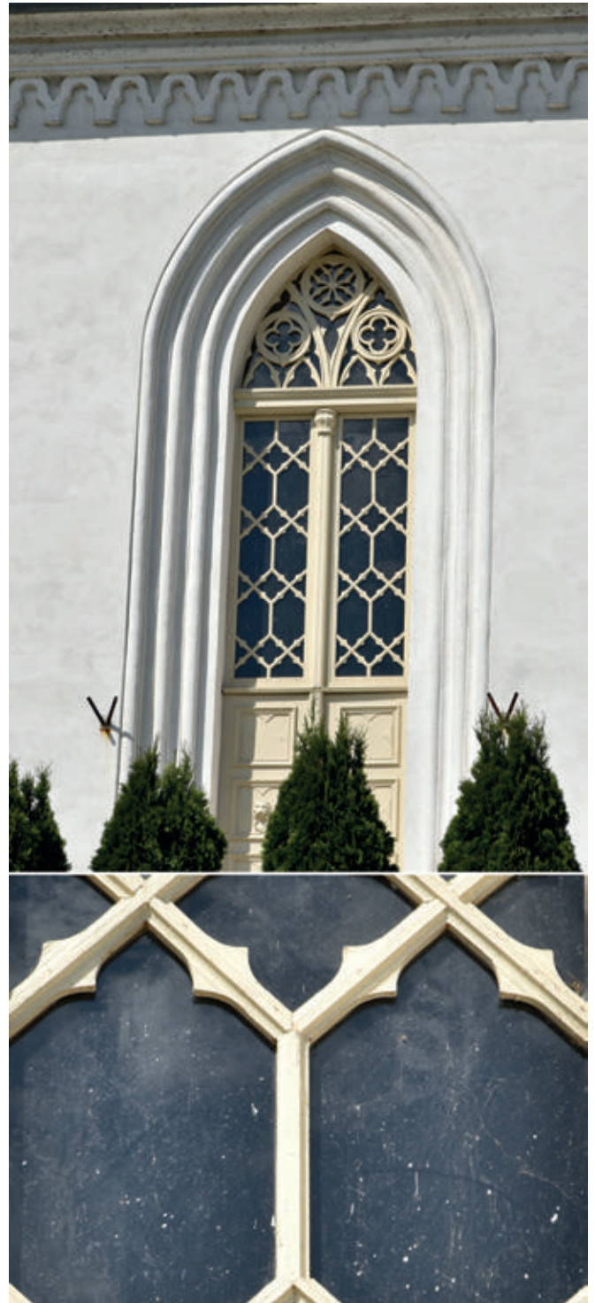
5. Nadświetle neogotyckiego okna z kościoła pw. św. Andrzeja w Krośnie Odrzańskim (1825–1827) projektu K.F. Schinkla. Fragment z trójkątnym układem szczeblin. Podobne rozwiązanie uzyskania uproszczonego maswerku przez dodanie trójkątnego detalu po bokach skośnych szczeblin mogło być zastosowane w górnych częściach okien w kościele w Osiecznicy
