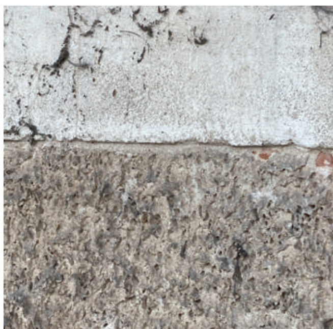
Ryc. 10. Milsko, kościół filialny pw. św. Jadwigi, prezbiterium, elewacja północna, partia nad ciemnicą, detal wystroju (gładkie obramienie i fakturowany tynk)
