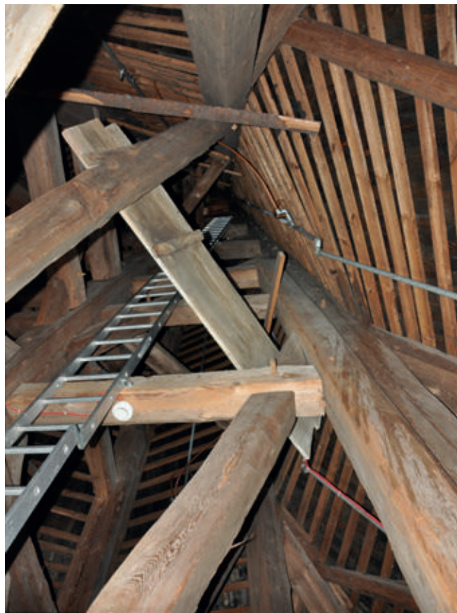
3. Klepsk, kościół poewangelicki. Konstrukcja hełmu wieży. Fot. U. Schaaf, 2022
