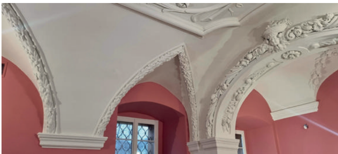
18–20. Sień po remoncie konserwatorskim
