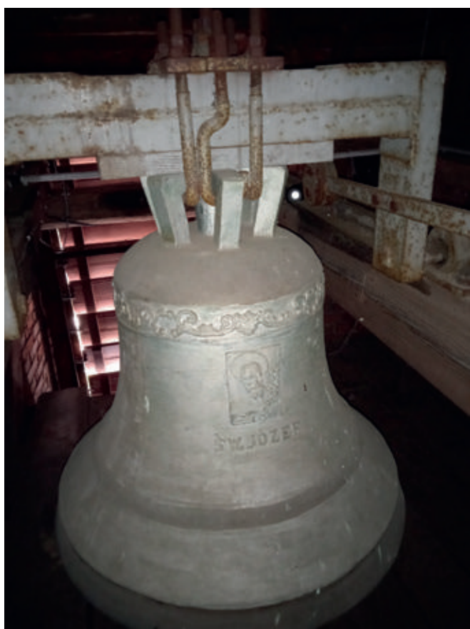
11. Dzwon z 1986 roku i niepoprawne jarzmo wykorbione w miejscowości Wyszanowo, powiat międzyrzecki. Analiza akustyczna tego dzwonu wykazała, że w wyniku przeniesienia środka ciężkości za pomocą jarzma, dźwięk cechuje się zbyt niskim tonem w porównaniu do wartości konstrukcyjnych profilu, ponadto cechą charakterystyczną jest niemal niesłyszalne wybrzmienie, co sugeruje, że dzwon jest uszkodzony pomimo stwierdzenia braku wad odlewu
