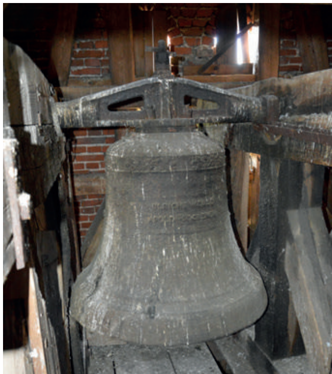
3. Jarzmo proste odlewane firmy Urlich & Weule Apolda und Bockenem oraz dzwon tej odlewni ze stopu żelaza, osadzone wtórnie w drewnianej kolebie, Górki Noteckie, pow. strzelecko-drezdenecki
