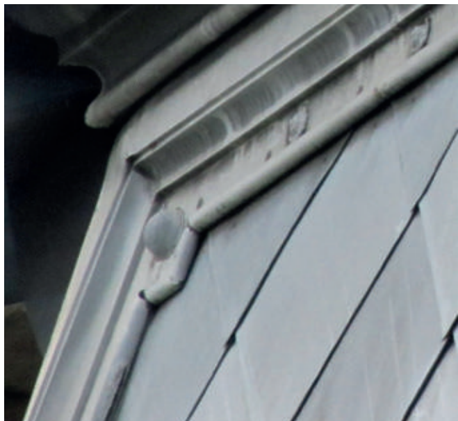
24. Dekoracyjna forma opierzenia blachą cynkową grzbietu dolnej połaci dachu mansardowego pałacu w Trzebiechowie (pow. zielonogórski), 2024
