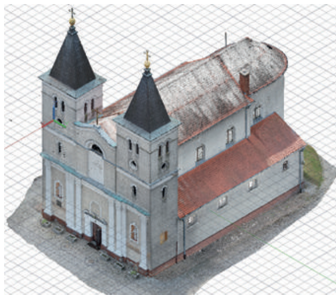
Ryc. 5. Model cyfrowy kościoła wykonany z chmury punktów na podstawie skanowania laserowego
