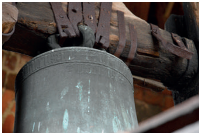
9a i b. Gościszowice, pow. żagański i 9b. Gorzupia Dolna, pow. żagański – korozja i ubytki biologiczne drewna oraz wyrzut smarowidła
