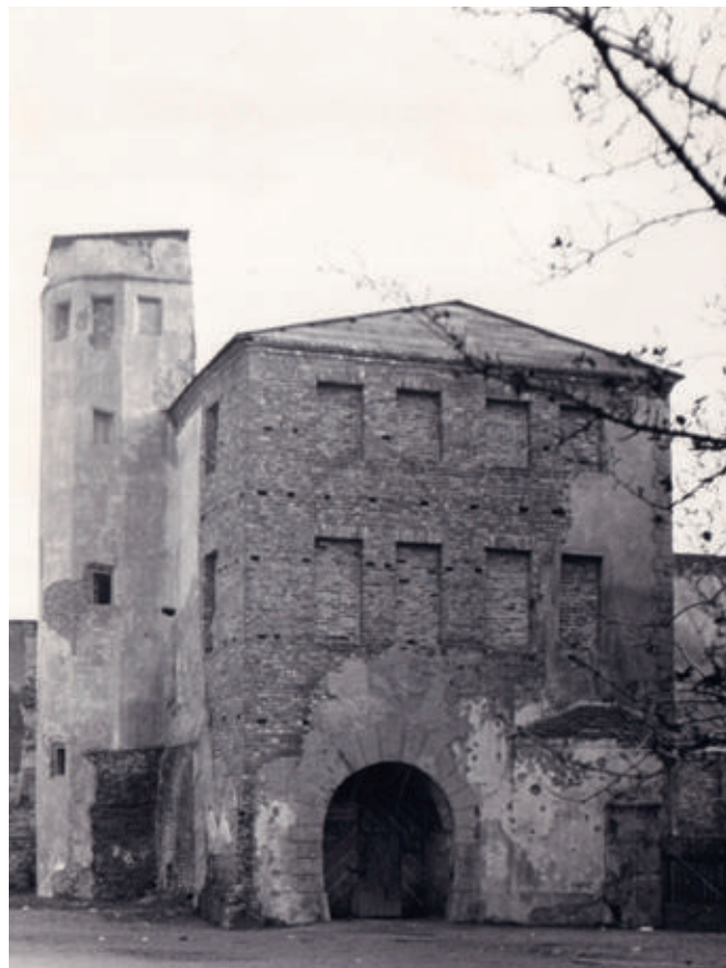
4. Zamek w Krośnie Odrzańskim po zabezpieczeniu dachu budynku bramnego w latach 50. XX wieku
