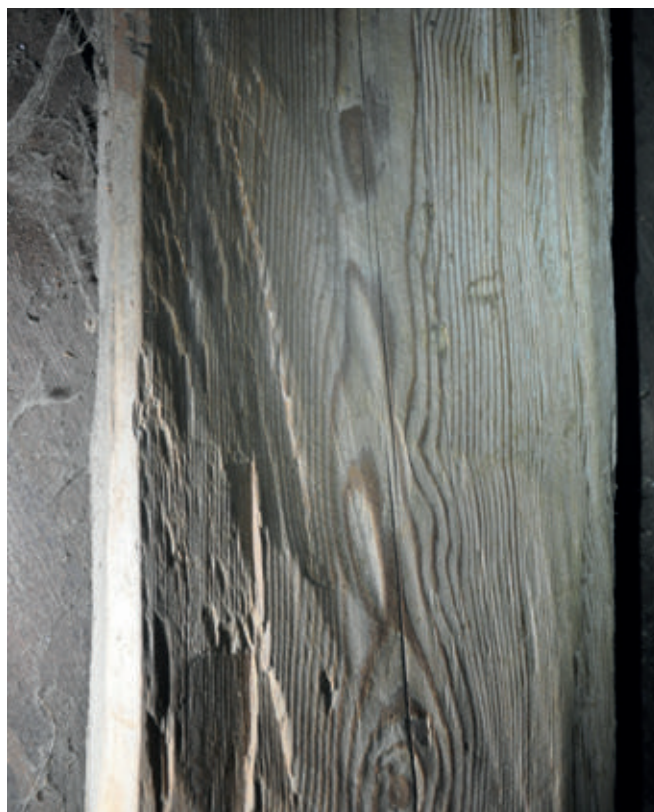
13. Kępno, kościół poewangelicki. Wieża. Łódkowate ślady po wygładzeniu budulca toporem. Fot. U. Schaaf, 2022
