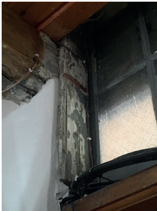
11. Pierwotne profilowanie ościeży okiennych i drzwiowych
