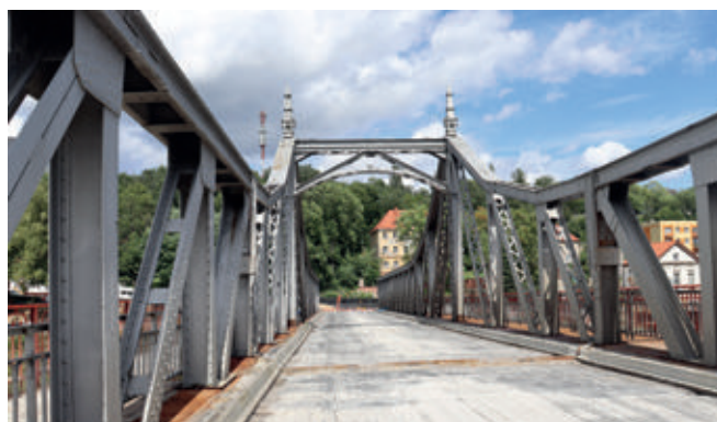
11. Most Odrzański w trakcie remontu, sierpień 2023
