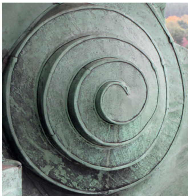
4. Ślimacznica wykonana z blachy miedzianej na wieży południowej kościoła pw. Wniebowzięcia NMP i św. Marcina z Tours w dawnym klasztorze cystersów w Gościkowie-Paradyżu (pow. świebodziński), 2020
