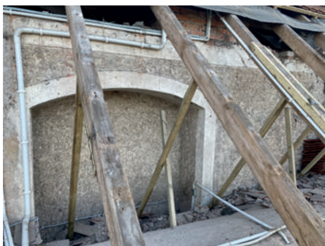
Ryc. 9. Milsko, kościół filialny pw. św. Jadwigi, prezbiterium, elewacja północna, partia nad ciemnicą
