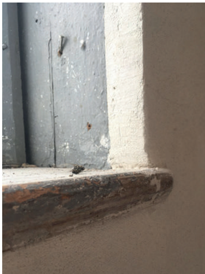
12. Jeden z zachowanych oryginalnych parapetów, widok profilu
