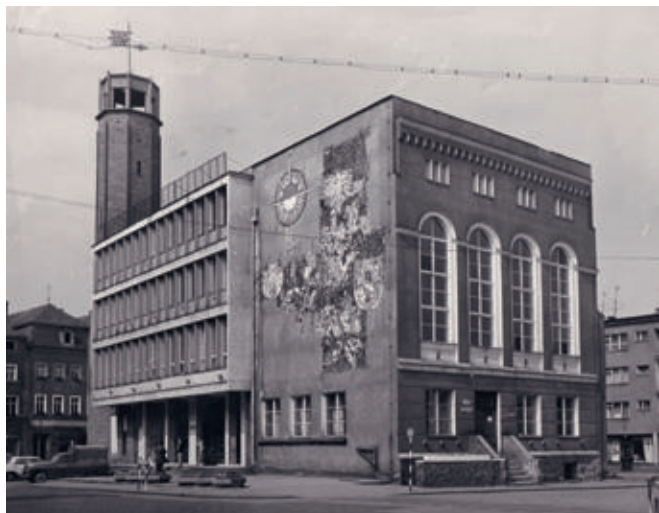
7. Ratusz w Koźuchowie po odbudowie w duchu modernizmu w latach 60. XX wieku
