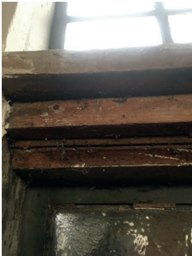
9. Profil pierwotnego śłemia wysokich skrzydeł drzwiowych północnego wejścia z wtórnie nadbitym parapetem i surową listwą na styku śłemia i parapetu
