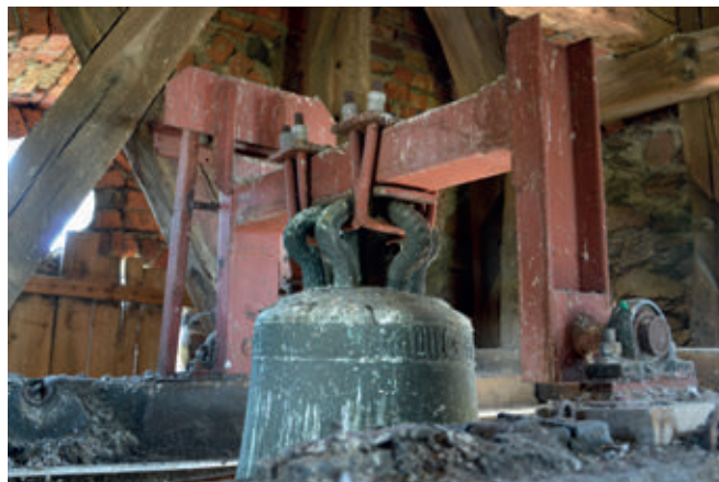
10a i b. Lutol Mokry, pow. międzyrzecki – nowa, wadliwie wykonana konstrukcja nośna, która zastąpiła oryginalną kolebę drewnianą oraz dzwony zawieszane na jarzmach wykorbionych bez podkładek amortyzujących – negatywny przykład niepoprawnych prac remontowych oraz 10b. Dzierzychowice, pow. żagański – niepoprawne jarzmo wykorbione na średniowiecznym dzwonie oraz nieprawidłowa podkładka amortyzująca z cienkiego tworzywa sztucznego
