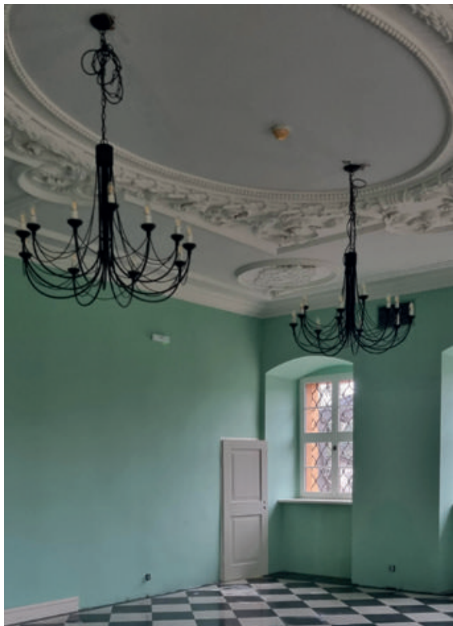
27. Wnętrza dworu po pracach remontowo-konserwatorskich
