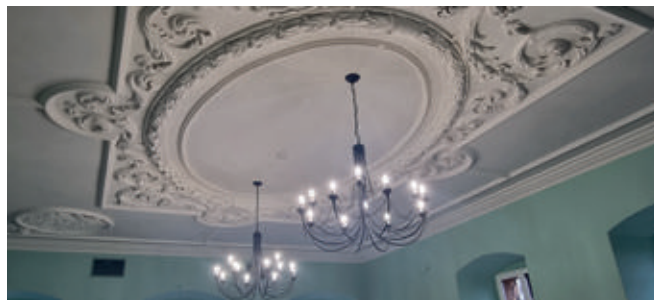
30. Wnętrza dworu po pracach remontowo-konserwatorskich
