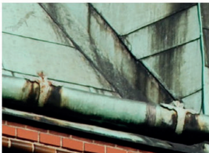
28. Dekoracyjne elementy wykonane z blachy miedzianej na hełmie wieży XIX-wiecznego kościoła parafialnego pw. Matki Bożej Królowej Polski w Świebodzinie
