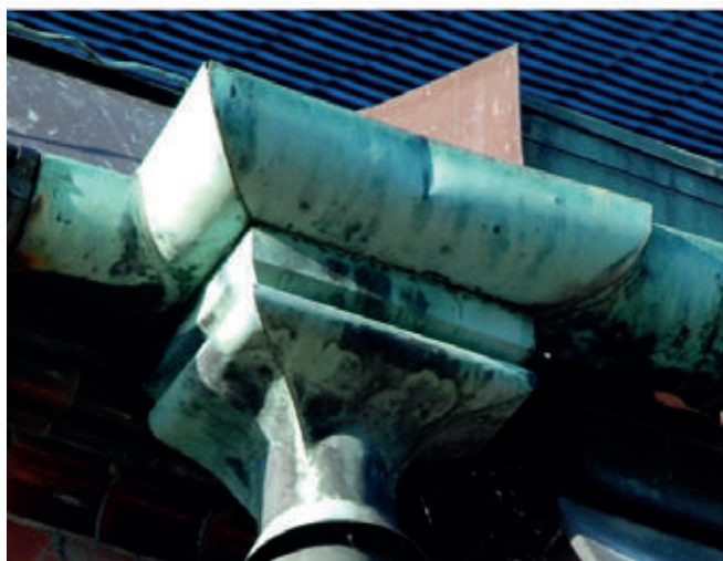
28. Dekoracyjne elementy wykonane z blachy miedzianej na hełmie wieży XIX-wiecznego kościoła parafialnego pw. Matki Bożej Królowej Polski w Świebodzinie
