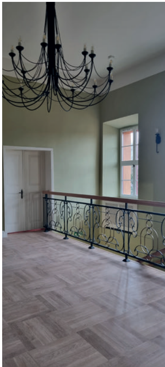
26. Odtworzona balustrada schodów na piętrze
