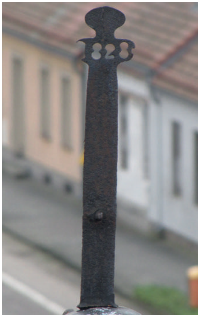
6. Relikt krzyża z datą 1828 osadzony na kalenicy dachu korpusu dawnego kościoła ewangelickiego w Babimoście (pow. zielonogórski), 2024
