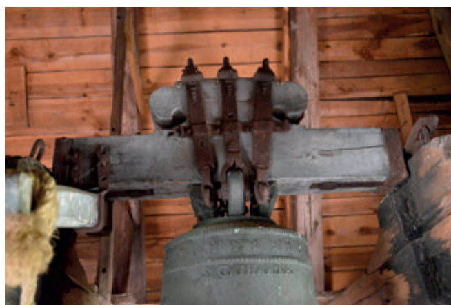
12. Oryginalne jarzmo proste z głowicą (przeciwważne), wykonane z drewna, Miodnica, pow. żagański
