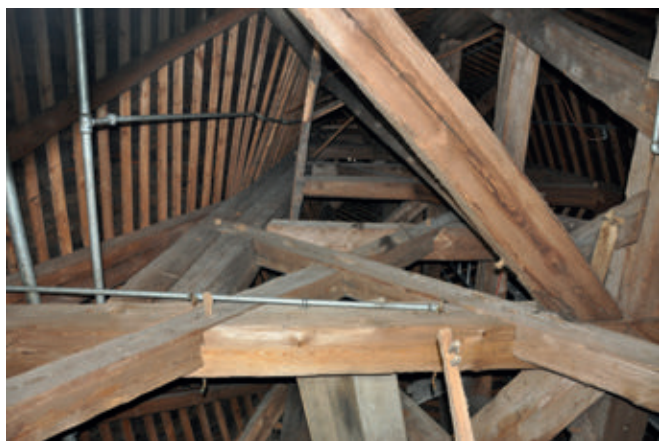
11. Kępno, kościół poewangelicki. Konstrukcja hełmu wieży. Fot. U. Schaaf, 2022
