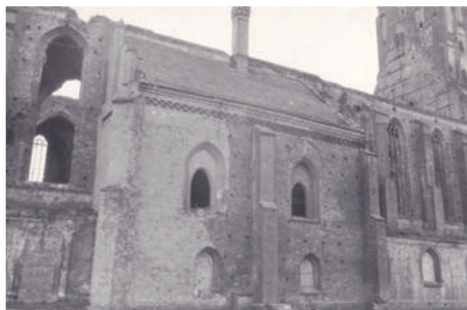
5. Fara w Gubinie po pracach zabezpieczających w latach 50. XX wieku
