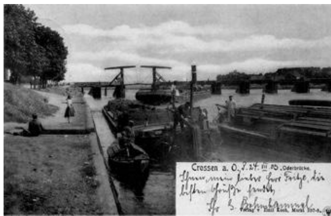
3. W tle drewniany most z podnoszonym przęsłem w prawobrzeżnej części Krośna Odrzańskiego. Pocztówka z 1903 roku. Źródło: polska-org.pl
