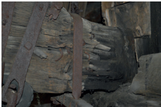
9a i b. Gościszowice, pow. żagański i 9b. Gorzupia Dolna, pow. żagański – korozja i ubytki biologiczne drewna oraz wyrzut smarowidła
