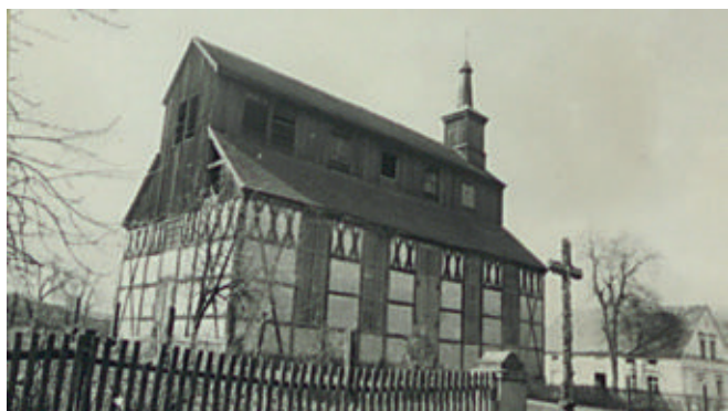
7. Fotografia z zielonej karty obiektu z 1966 roku (archiwum WUOZ), z zachowanym w drugim oknie od prawej maswerkowym górnym modulem
