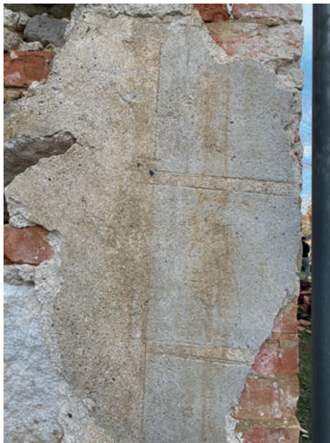
Ryc. 8. Milsko, kościół filialny pw. św. Jadwigi, zakrystia, elewacja wschodnia, detal boniowania narożnika
