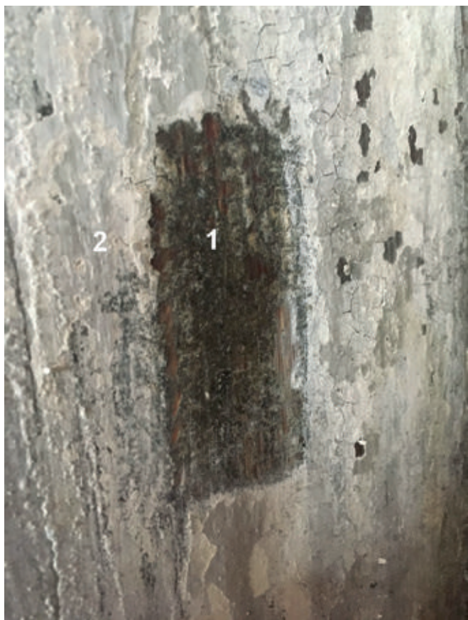
10. Ościeża przy otworze drzwiowym północnym: 1 – czarna, tłusta warstwa malarska na drewnie, 1816, I faza; 2 – biała warstwa malarska na chudym lub emulsyjnym spoiwie, przed 1960, III faza
