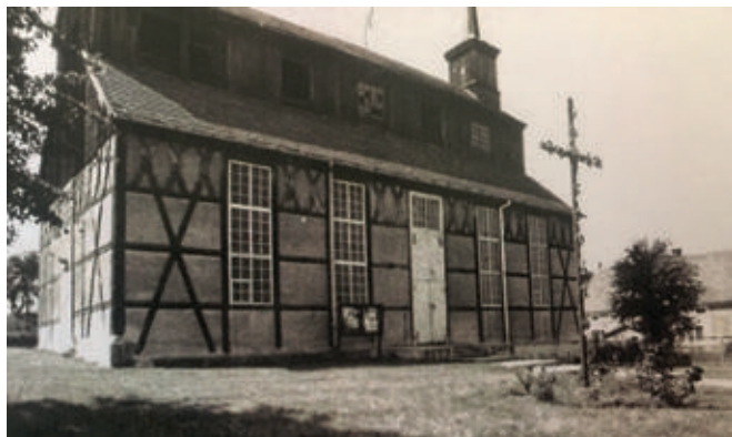
6. Fotografia z 1960 roku, z zielonej karty cmentarza (archiwum WUOZ). Zachowane oryginalne drzwi wejściowe północne obejmujące wysokością trzy farchy, mają trzy poziomy zawiasów. Nad środkowymi zawiasami widoczna pozioma linia dzieląca oba skrzydła drzwiowe
