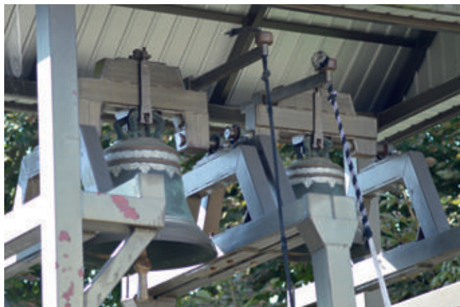
10a i b. Lutol Mokry, pow. międzyrzecki – nowa, wadliwie wykonana konstrukcja nośna, która zastąpiła oryginalną kolebę drewnianą oraz dzwony zawieszane na jarzmach wykorbionych bez podkładek amortyzujących – negatywny przykład niepoprawnych prac remontowych oraz 10b. Dzierzychowice, pow. żagański – niepoprawne jarzmo wykorbione na średniowiecznym dzwonie oraz nieprawidłowa podkładka amortyzująca z cienkiego tworzywa sztucznego
