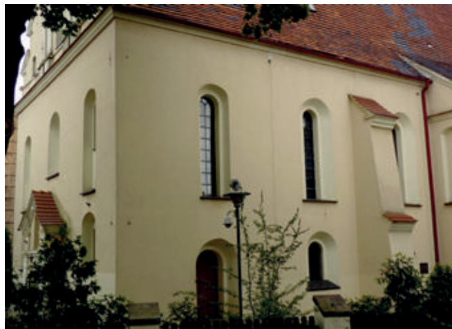
Il. 6. Aneks i przypora od strony południowej
