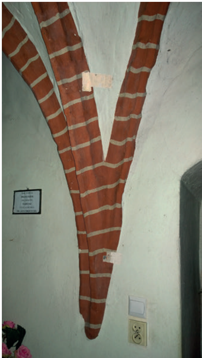
33. Chichy. Kościół. Odkrywki stratygraficzne wykonane w obrębie splotu żeber sklepiennych w zakrystii. Stan w 2023 roku
