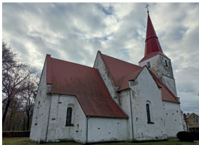
6. Chichy. Kościół. Widok kościoła od strony północnej. Stan w 2023 roku
